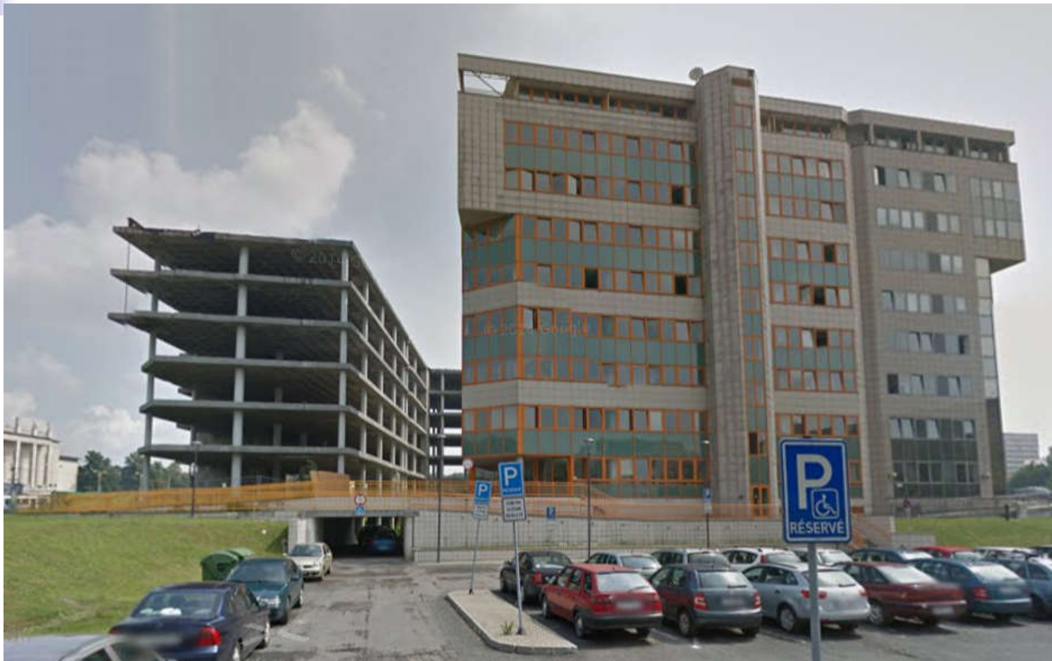
Nedostavěný krajský sjezdový palác KSČ a OSSZ v Ostravě
