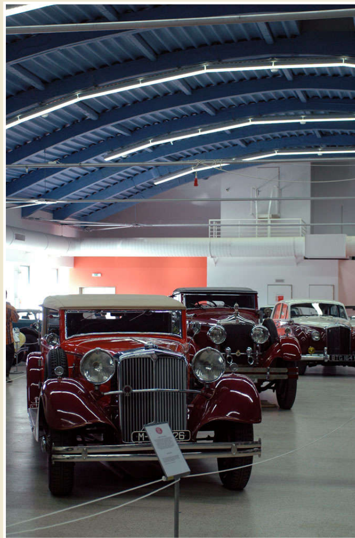
Střešní konstrukce se soustavou oblouků s táhly, Pavilon výstaviště Černá louka, Ostrava
