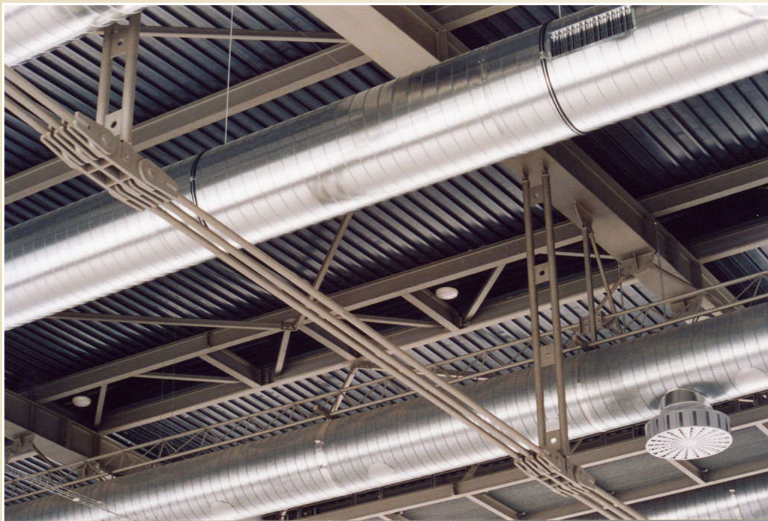
Konstrukce obloukové nosné konstrukce s táhlem, Pavilon G1, Brněnské výstaviště
