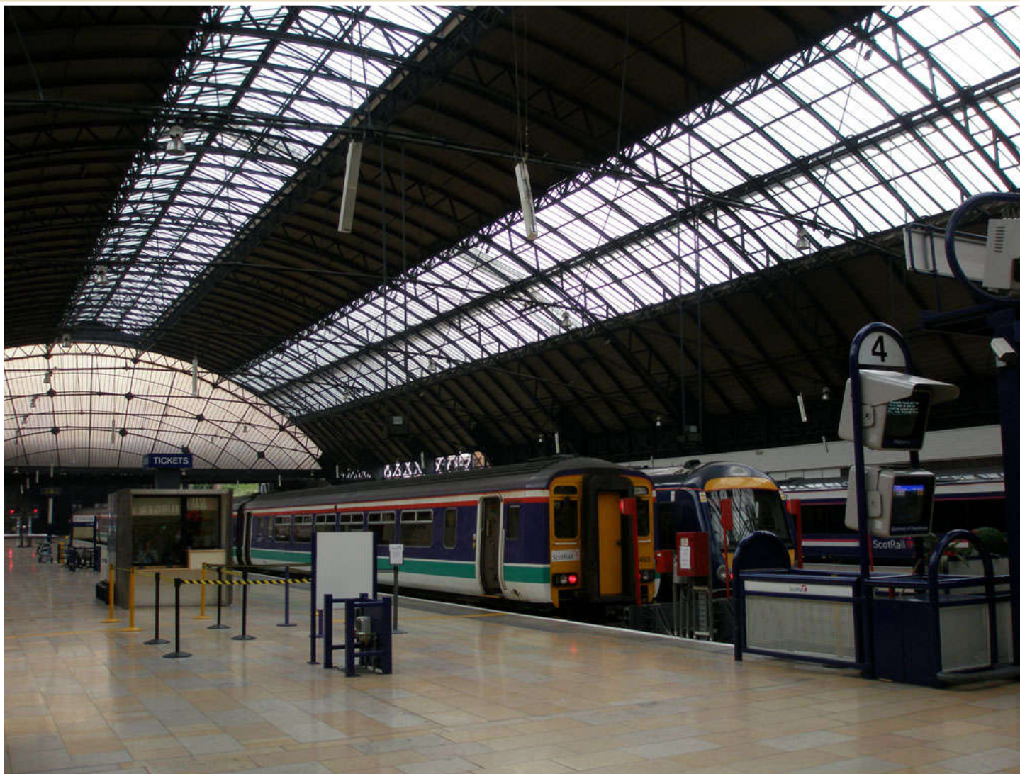
Konstrukce obloukové nosné konstrukce s táhly, Queen Street Station, Glasgow, Skotsko
