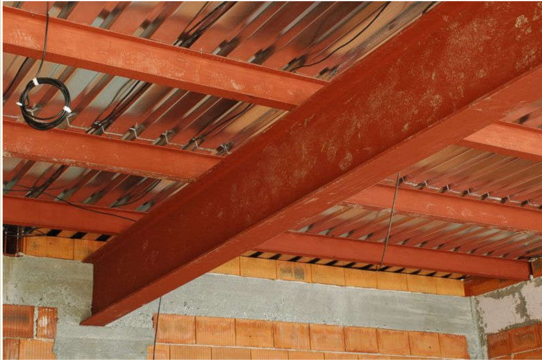
Ukázky konstrukcí tvořených spojitým nosníkem
