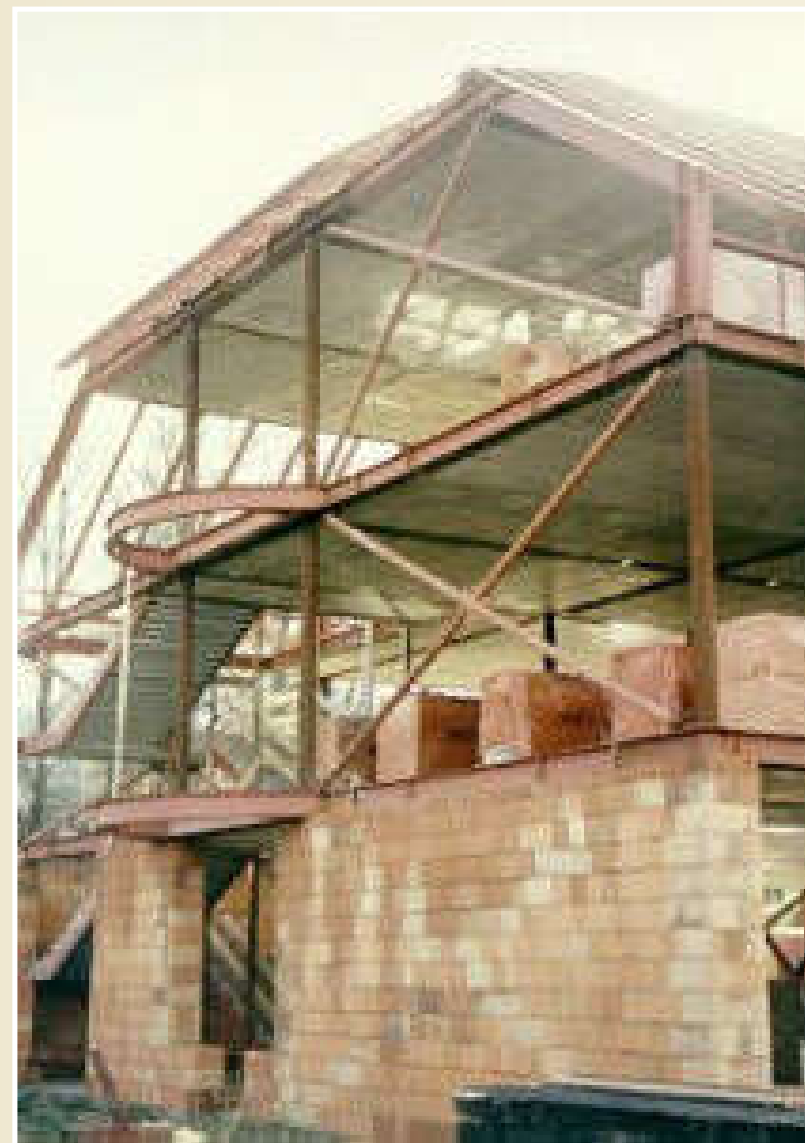
Rámová konstrukce se ztužením, projekt OKM
