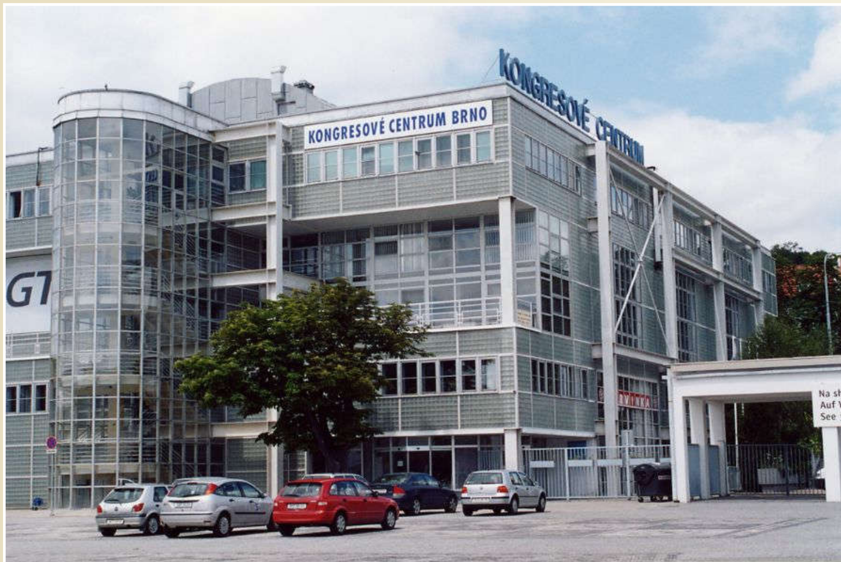
Přiznaná nosná prostorová rámová konstrukce
