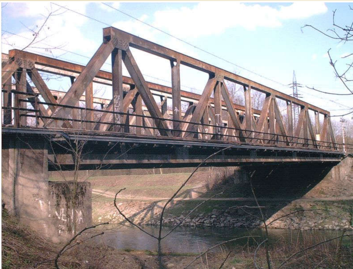
Most přes řeku Odru z r.1964, Polanecká spojka, Ostrava – Zábřeh
