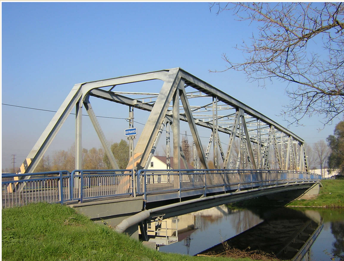
Příhradový most přes řeku Ostravici
