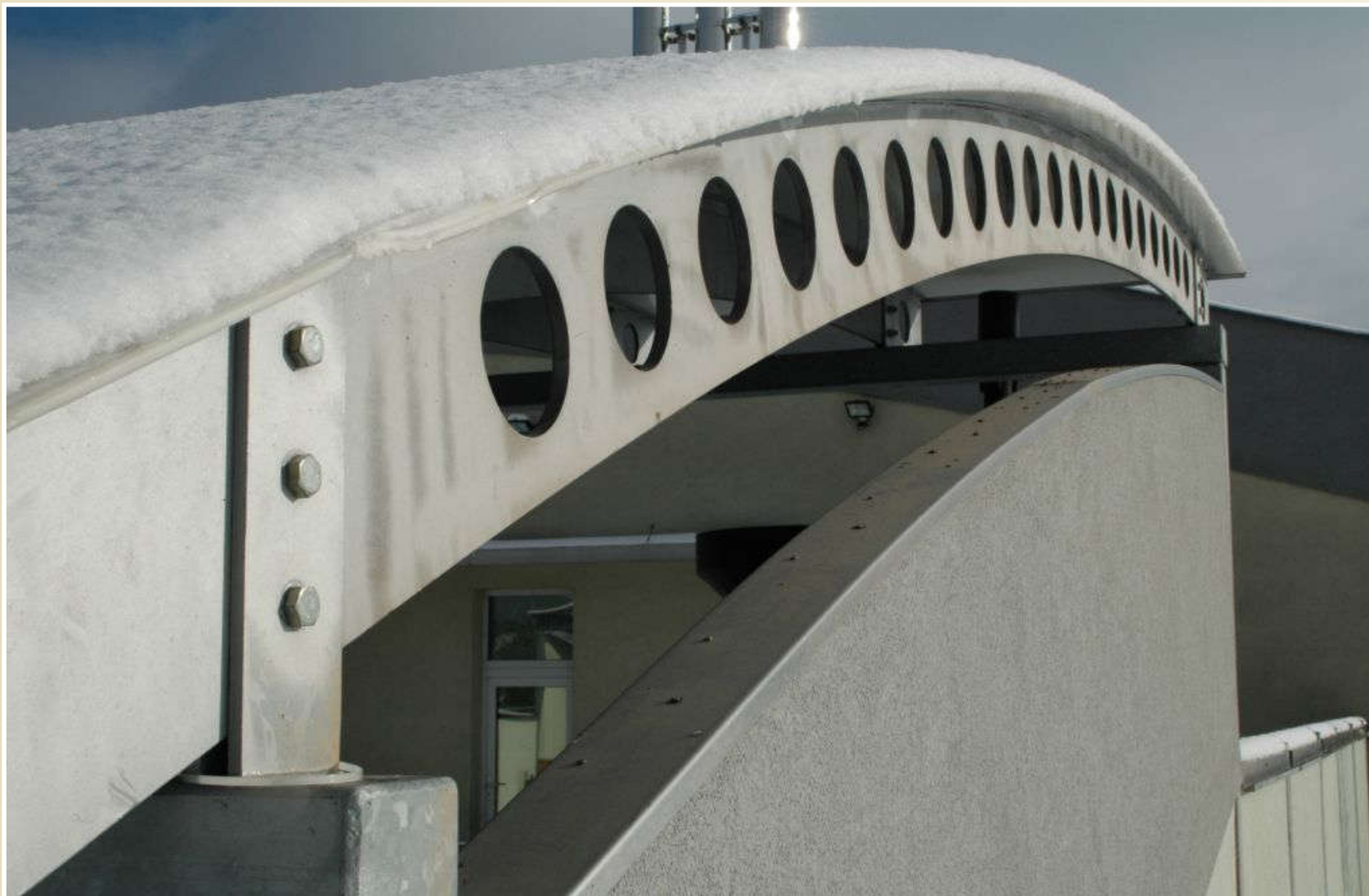
Rovinně zakřivený vazník, Výzkumné energetické centrum VŠB-TU Ostrava
