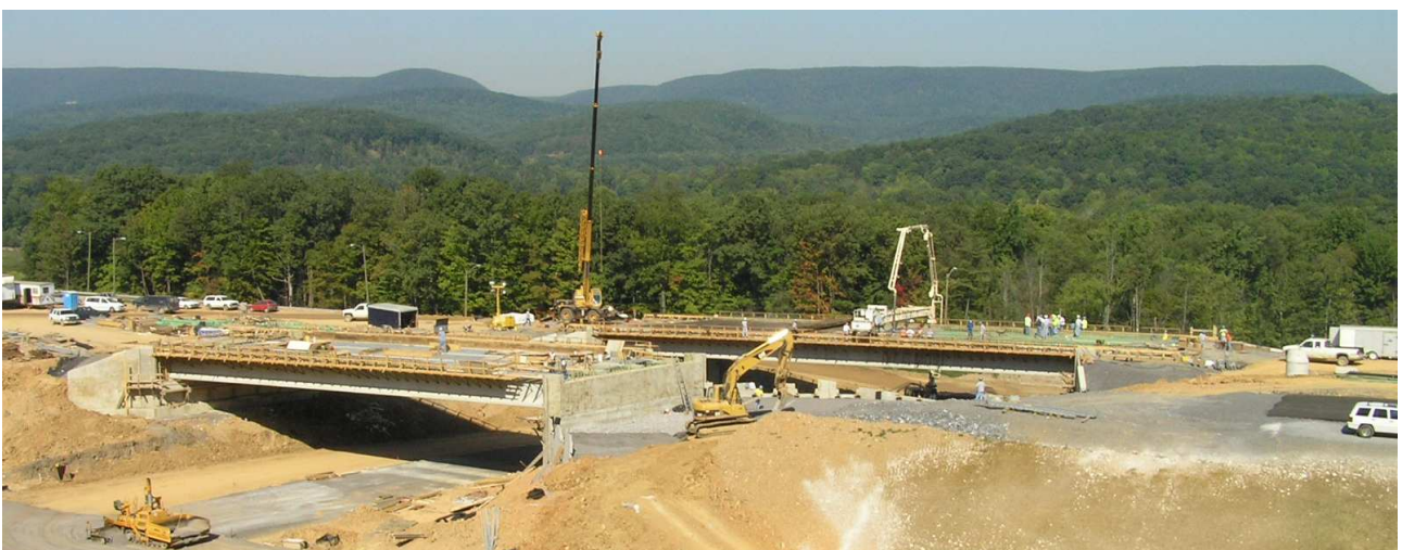
Obr. 4: Ilustrační foto z výstavby mostu s přímopojížděnou železobetonovou mostovkou s epoxidovou ochranou výztuže, I99 poblíž State College v Pennsylvanii, USA.
