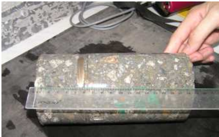
Obr. 14: Jádrový výmrt s výztuží ve spodní části.
