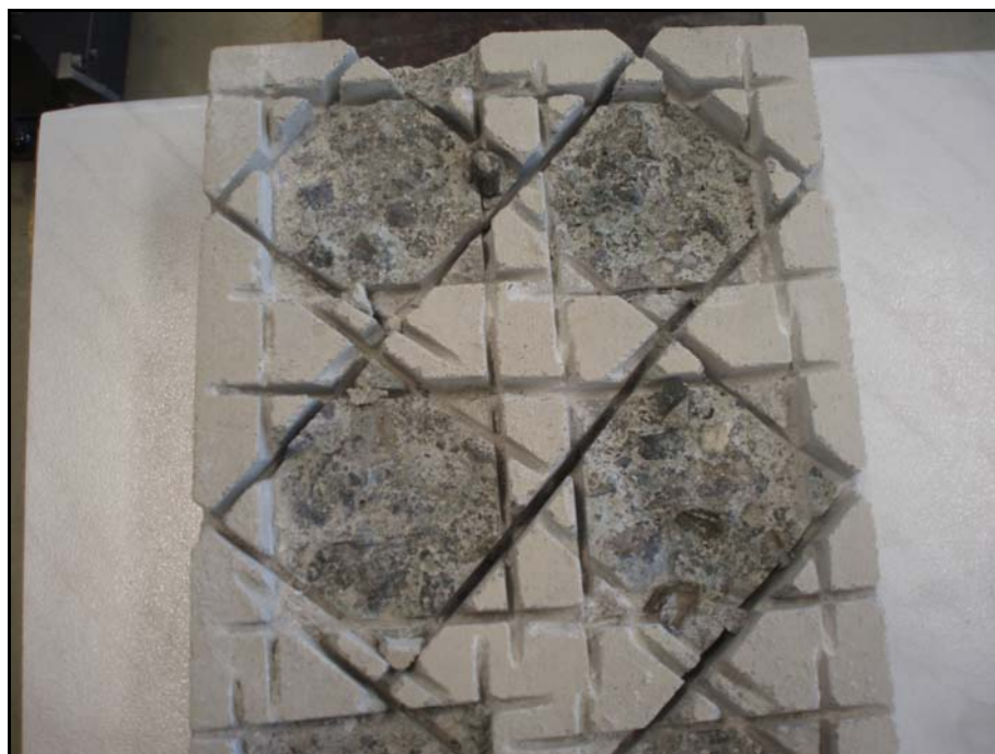
Obr. 14. Výsledek odtrhové zkoušky zatvrdlé malty
