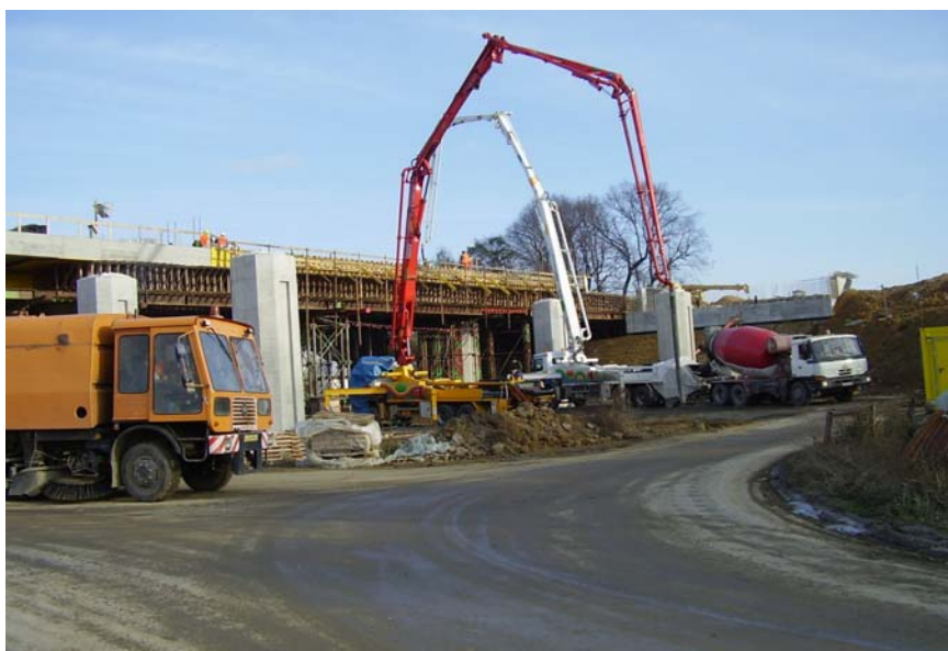
Obr.5. Aplikace transportbetonu autodomícháčem a betonovým čerpadlem
