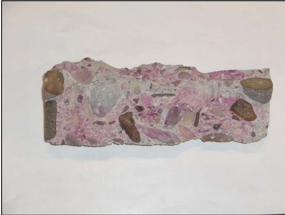
Obr. 10. Acidobazická reakce zdravého betonu při fenolftaleinové zkoušce
