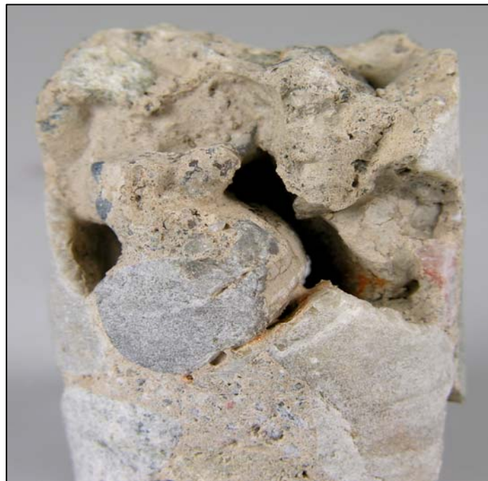
Obr.9. Vyloužení části cementového kamene v betonu v důsledku působení koroze I. typu
