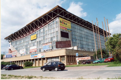
Prostorová příhradová ocelová konstrukce plaveckého stadiónu v Brně, autor nosné konstrukce: Ing. Dr. Ferdinand Lederer
