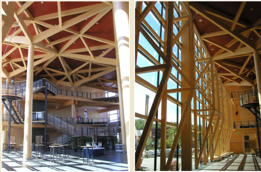
Koncertní a přednášková hala pro 500 lidí „Sibelius Hall“, Lahti, Finsko, nosná konstrukce vstupní haly z lepeného lamelového dřeva ve tvaru stromů, foto: prof. Ing. Antonín Lokaj, Ph.D.
