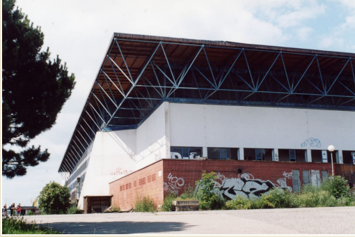
Prostorová příhradová ocelová konstrukce bývalého zimního stadiónu v Brně, autor nosné konstrukce: Ing. Dr. Ferdinand Lederer
