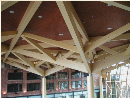
Koncertní a přednášková hala pro 500 lidí „Sibelius Hall“, Lahti, Finsko, nosná konstrukce vstupní haly z lepeného lamelového dřeva ve tvaru stromů, foto: prof. Ing. Antonín Lokaj, Ph.D.
