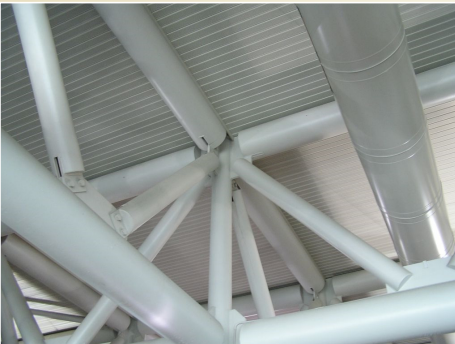
Prostorová příhradová konstrukce letištní haly v Římě, foto: prof. Ing. Alois Materna, CSc., MBA Prostorový svazek sil 15 / 56
