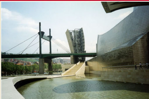
Futurologická ocelová konstrukce z roku 1997, titanové opláštění, výška 50 m, 32 000 m 2 plochy, architekt Frank Gehry
