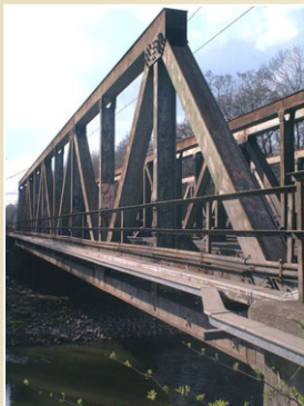
Most přes řeku Odru z r.1964, Polanecká spojka, Ostrava – Zábřeh
