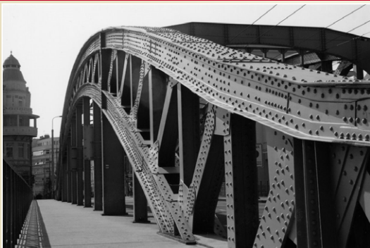
Ocelový příhradový oblouk o rozpětí 60 m a vzepětí 7 m, celková délka 92 m, šířka 16 m, vyrobeno 1913.
