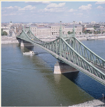
Ocelový příhradový most
