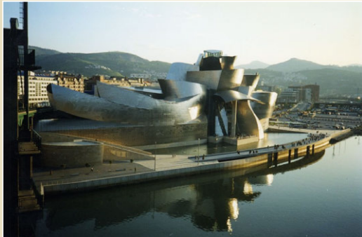
Futurologická ocelová konstrukce z roku 1997, titanové opláštění, výška 50 m, 32 000 m 2 plochy, architekt Frank Gehry
