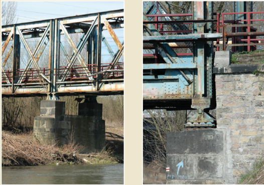
Ukázky kloubových příhradových konstrukcí
