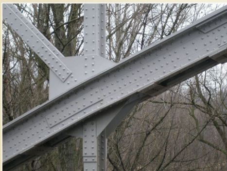
Ocelový příhradový oblouk o rozpětí 50 m, vyrobeno 1929.
