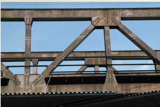
Most přes železniční trať v Polance z roku 1964
