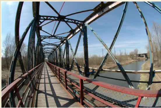
Ukázky kloubových příhradových konstrukcí
