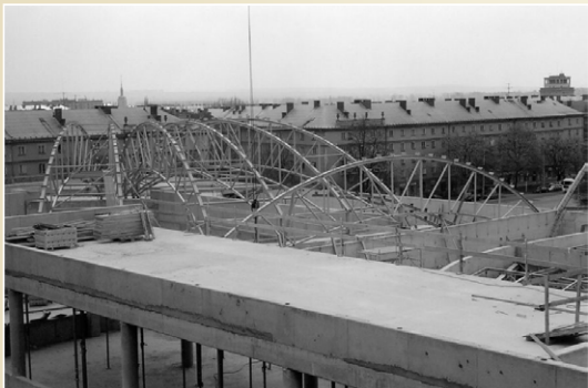
Příhradová konstrukce zastřešení přednáškového sálu
