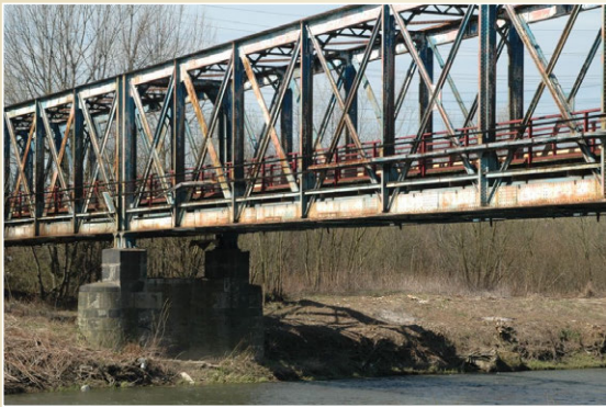
Ukázky kloubových příhradových konstrukcí
