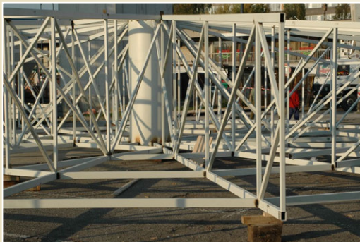
Detail rotačně symetrické příhradové konstrukce střechy
