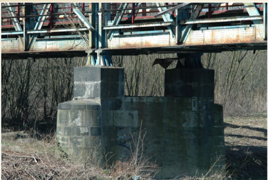
Ukázky kloubových příhradových konstrukcí
