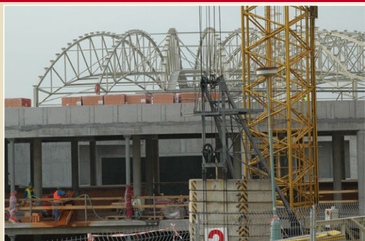
Příhradová konstrukce zastřešení přednáškového sálu
