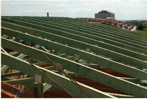
Soustava dřevěných příhradových vazníků konstrukce střechy
