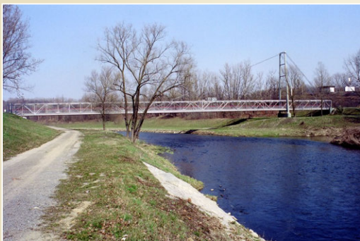
Příhradová lávka přes řeku Ostravici
