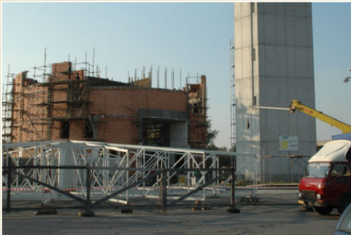
Rotačně symetrická příhradová konstrukce střechy
