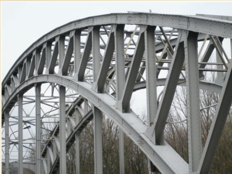
Ocelový příhradový oblouk o rozpětí 50 m, vyrobeno 1929.
