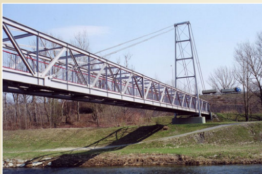
Přihradová lávka přes řeku Ostravici
