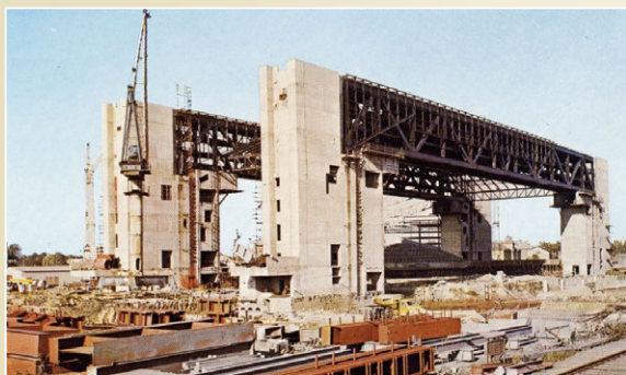
Ocelová konstrukce z roku 1980, půdorys 125x109 m, výška 31 m
