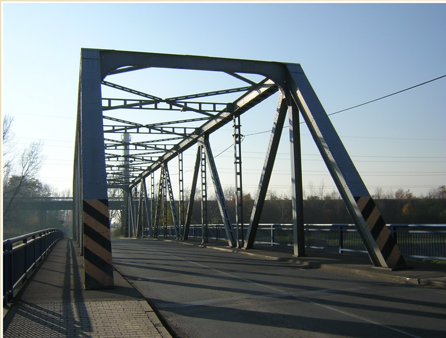
Příhradový most přes řeku Ostravici
