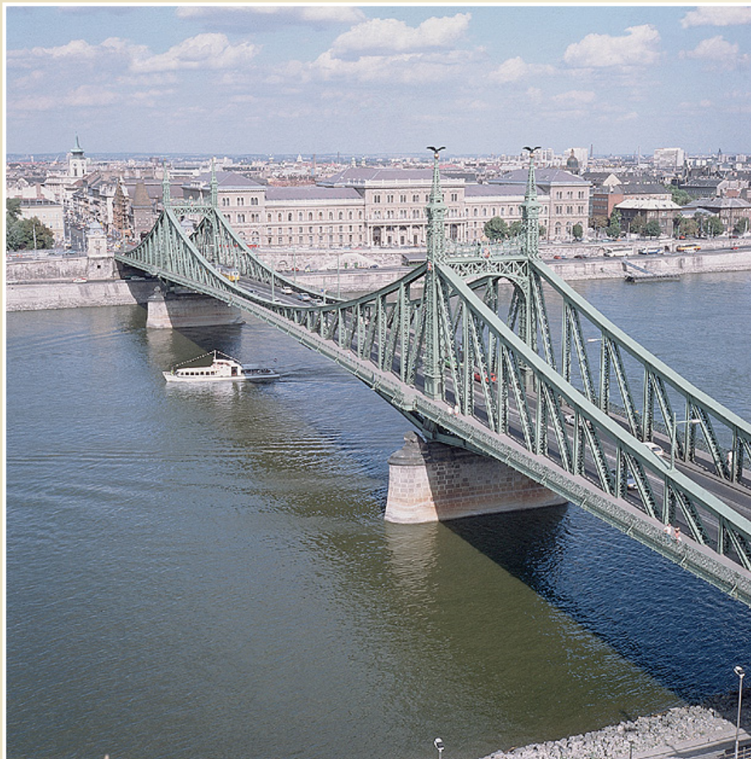
Ocelový příhradový most
