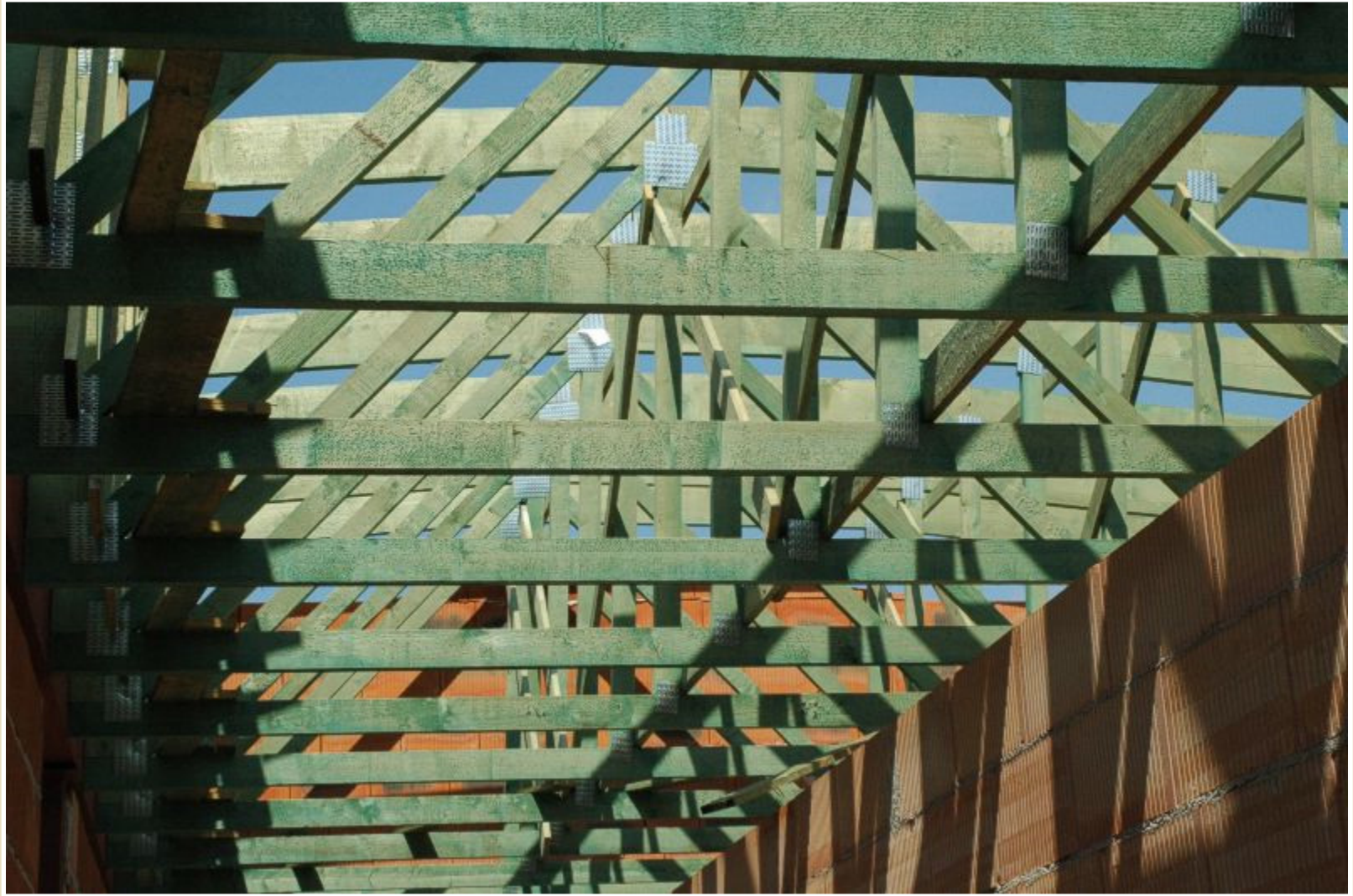
Soustava dřevěných příhradových vazníků konstrukce střechy
