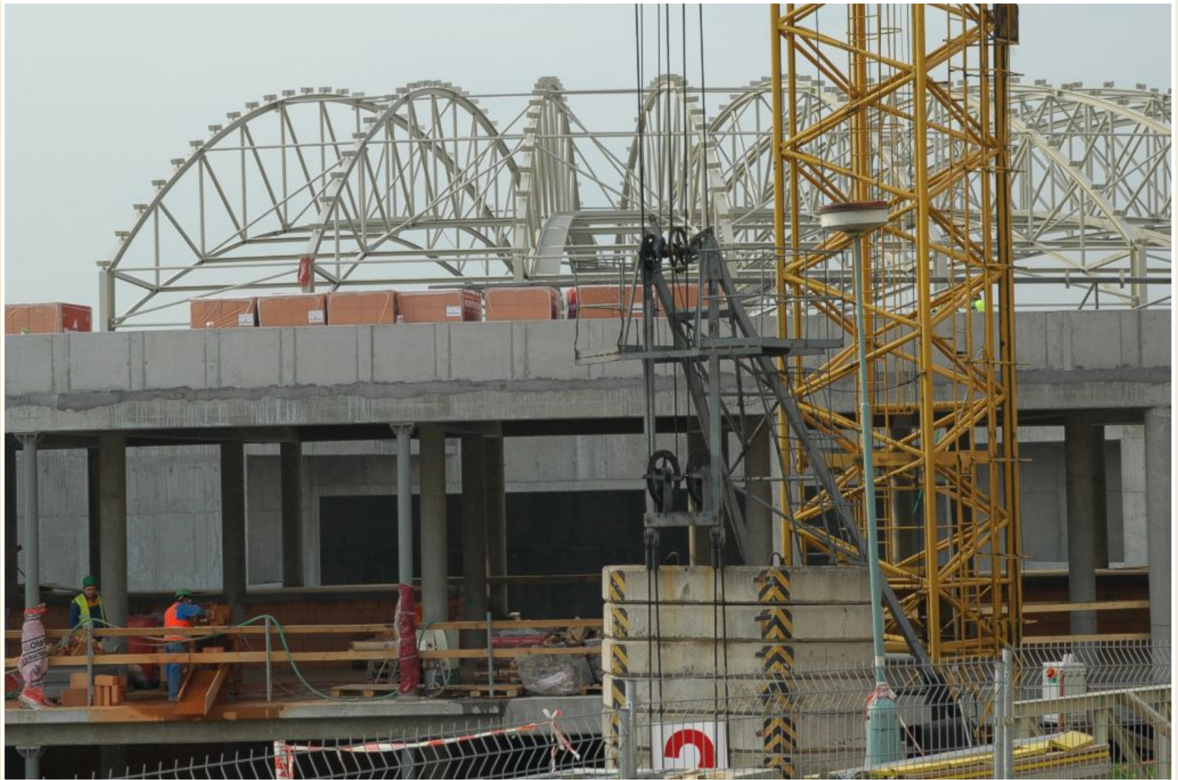
Příhradová konstrukce zastřešení přednáškového sálu
