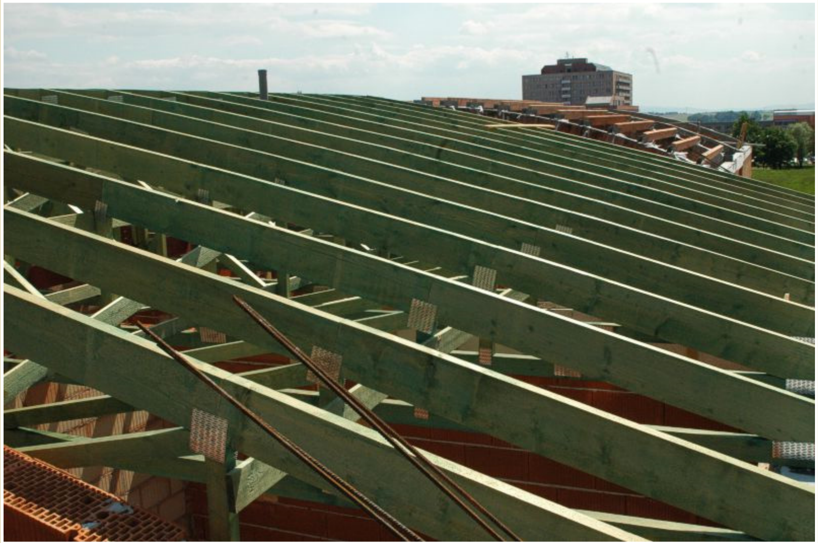
Soustava dřevěných příhradových vazníků konstrukce střechy
