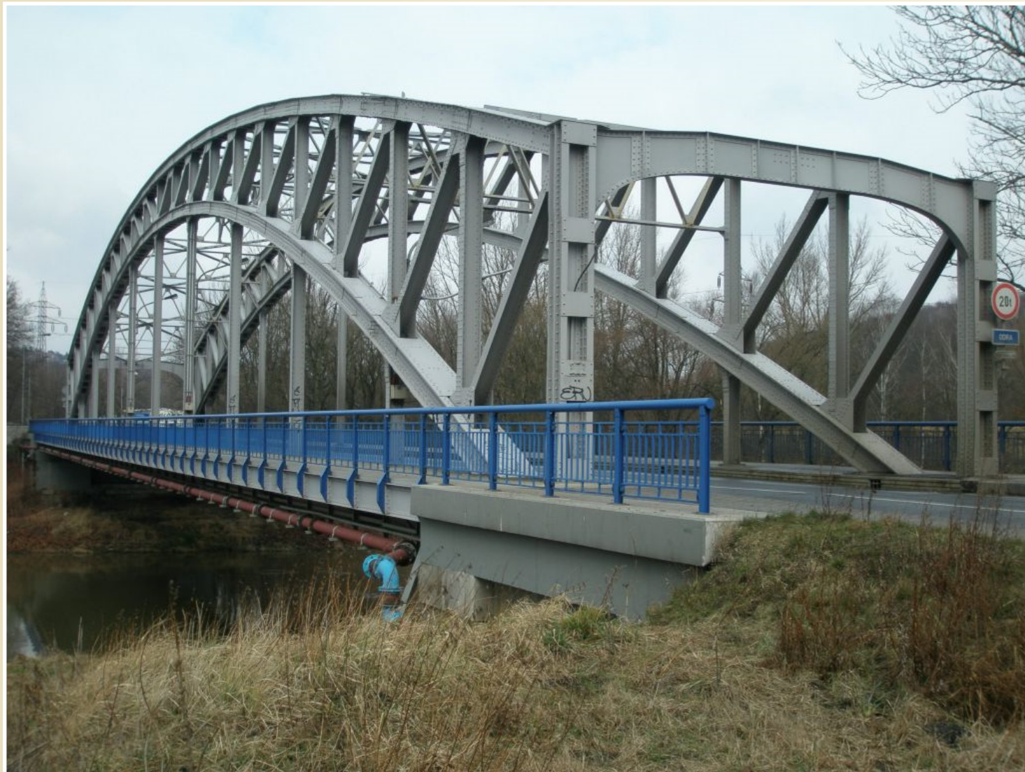
Ocelový příhradový oblouk o rozpětí 50 m, vyrobeno 1929.
