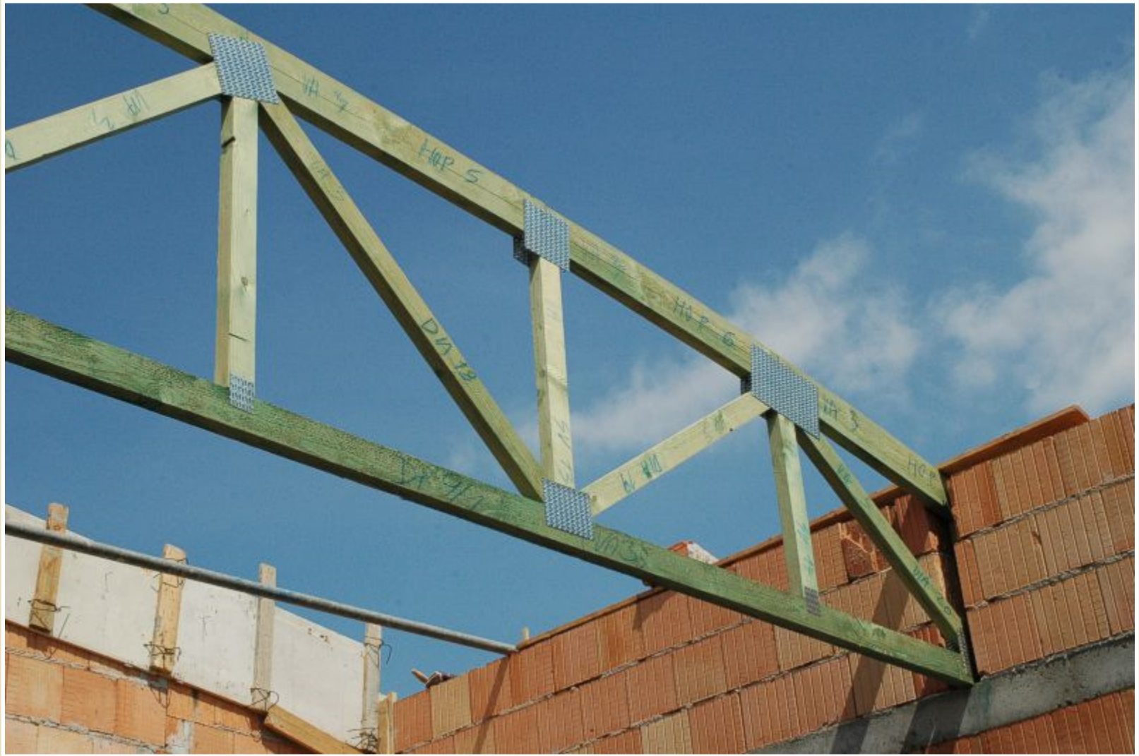
Dřevěný příhradový vazník konstrukce střechy
