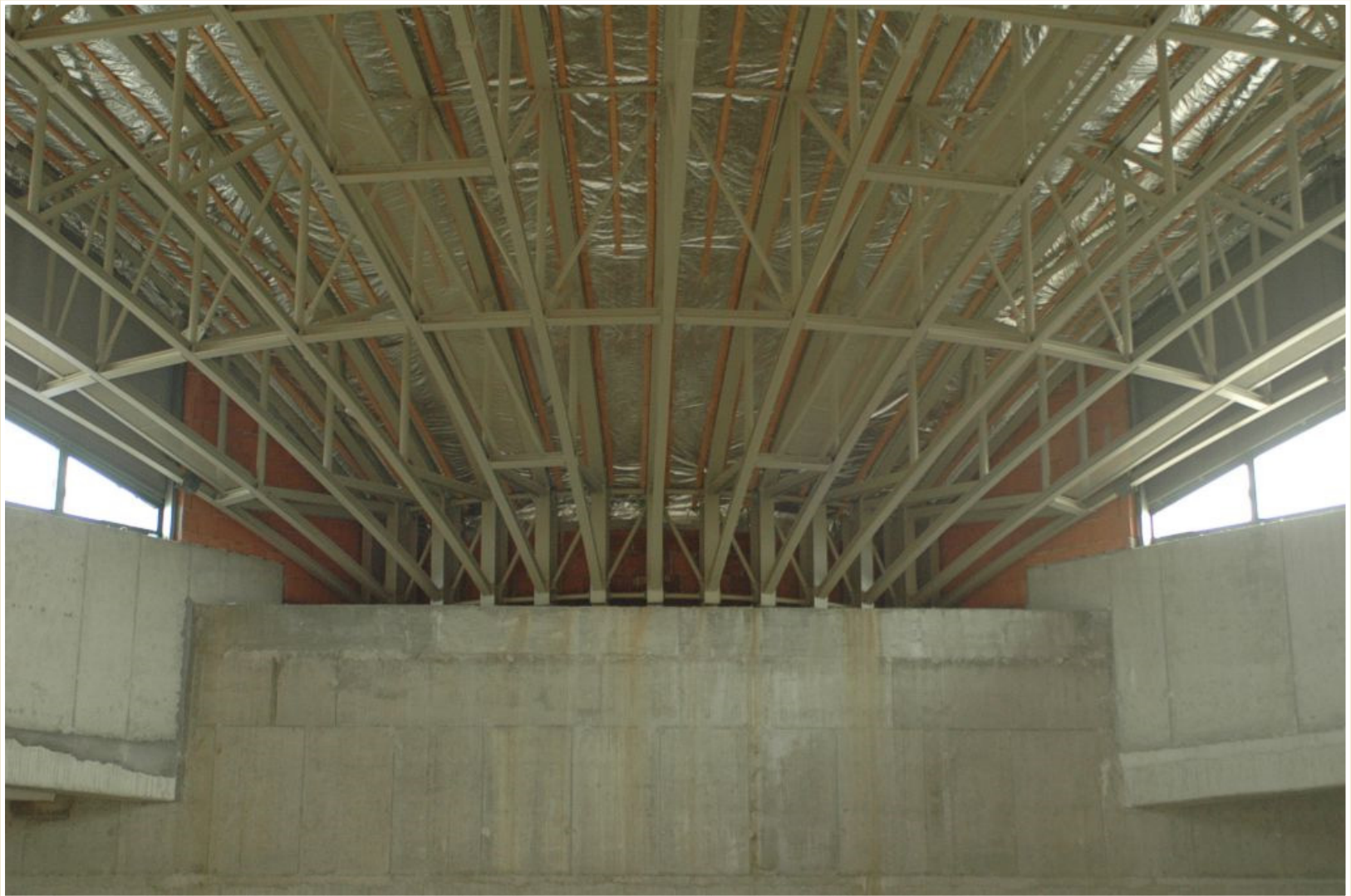
Příhradová konstrukce zastřešení přednáškového sálu
