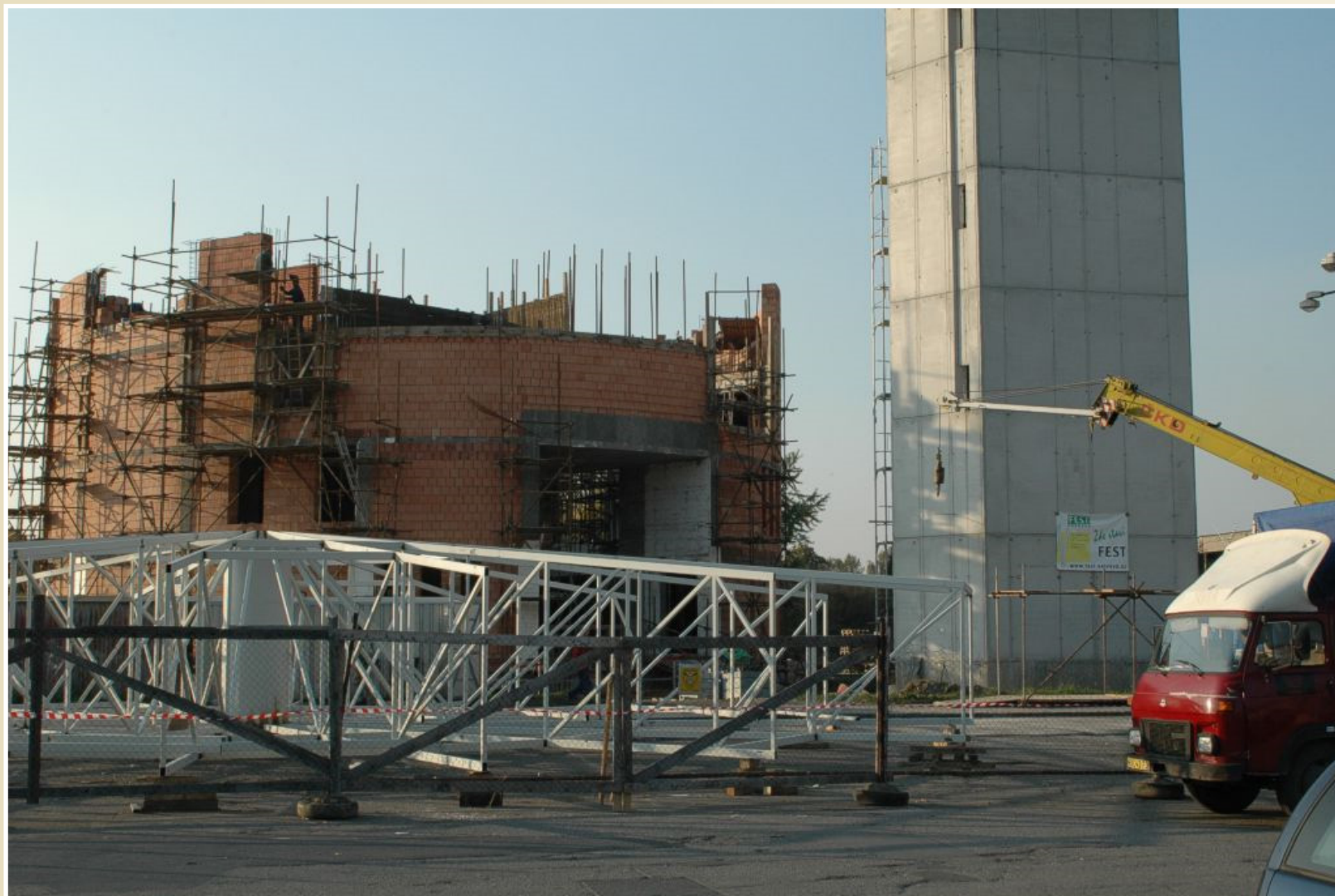
Rotačně symetrická příhradová konstrukce střechy
