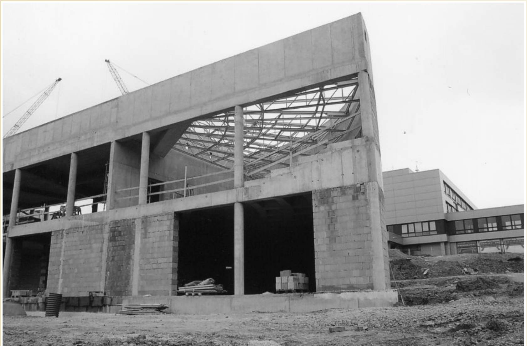
Příhradová konstrukce zastřešení přednáškového sálu
