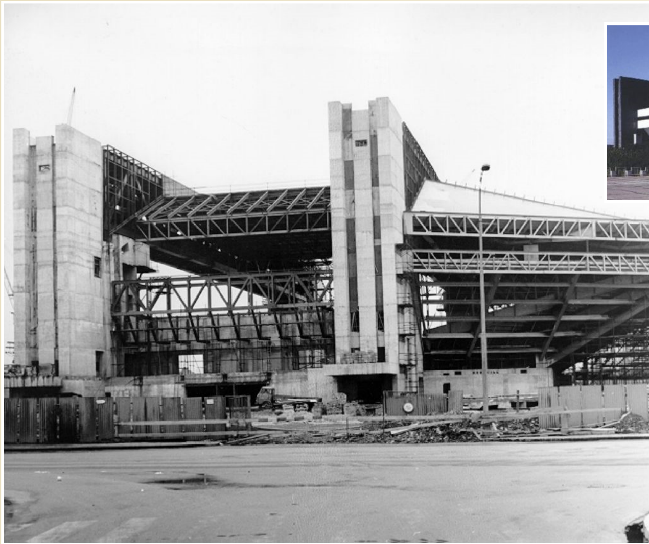
Ocelová konstrukce z roku 1980, půdorys 125x109 m, výška 31 m
