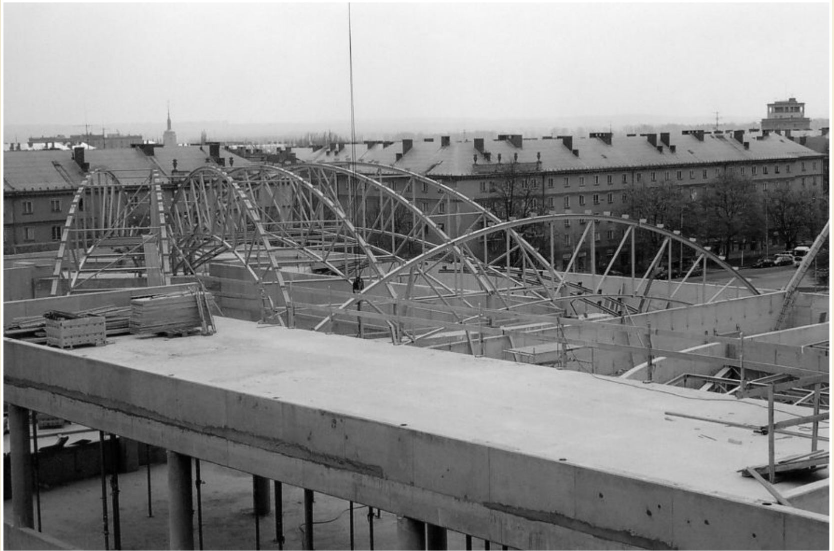
Příhradová konstrukce zastřešení přednáškového sálu
