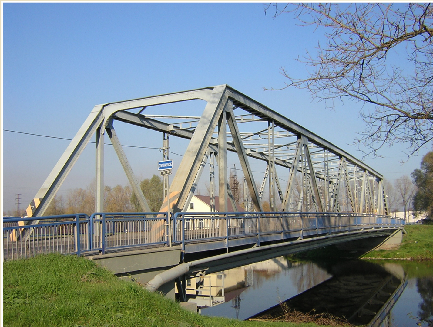
Příhradový most přes řeku Ostravici
