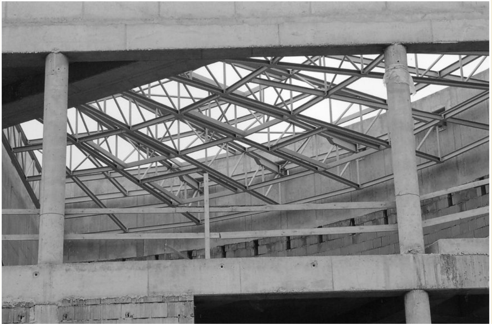
Příhradová konstrukce zastřešení přednáškového sálu
