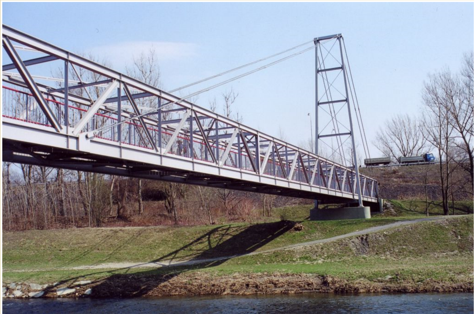
Příhradová lávka přes řeku Ostravici
