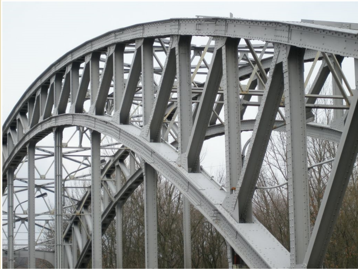
Ocelový příhradový oblouk o rozpětí 50 m, vyrobeno 1929.
