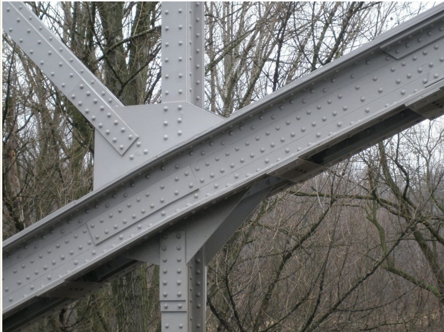
Ocelový příhradový oblouk o rozpětí 50 m, vyrobeno 1929.
