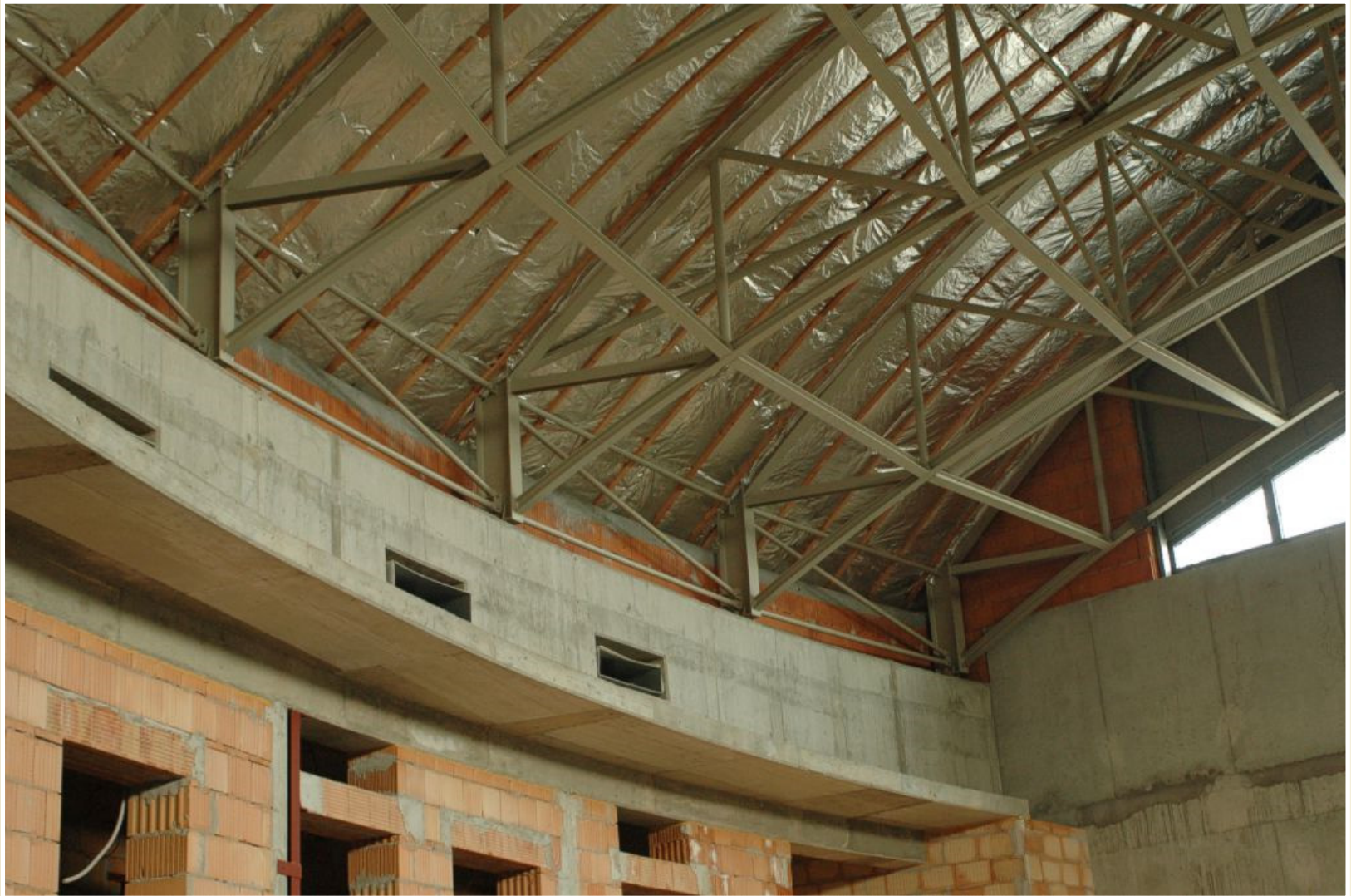
Příhradová konstrukce zastřešení přednáškového sálu
