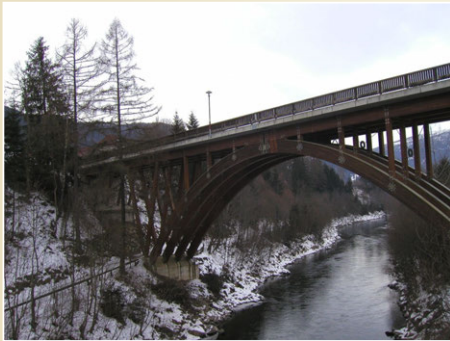
Most z lepeného lamelového dřeva Wennerbruecke přes řeku Mur, St. Georgen, Murau, Rakousko, 4 parabolické trojkloubové oblouky o rozpětí 45 m a vzezpečí 12,5 m, foto: prof. Ing. Antonín Lokaj, Ph.D. Trojkloubový rám a oblouk 86 / 129
