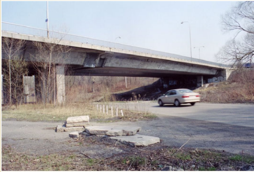
Most přes řeku Ostravici, 2 pole, 1 vnitřní kloub, oboustranný převislý konec, Černá louka, Ostrava Spojitý nosník s vloženými klouby 46 / 129
