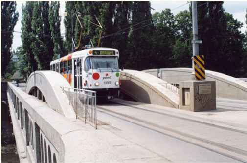
Maloměřický most z roku 1928, 3 oblouky o rozpětí 33 m s průřezem 1 m 2 , mezilehlá mostovka, Brno Trojkloubový rám a oblouk 82 / 129
