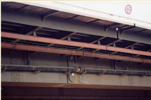
Most přes železniční trať z roku 1980, Ostrava – Svinov, délka 130 m, hmotnost 2.840 t
