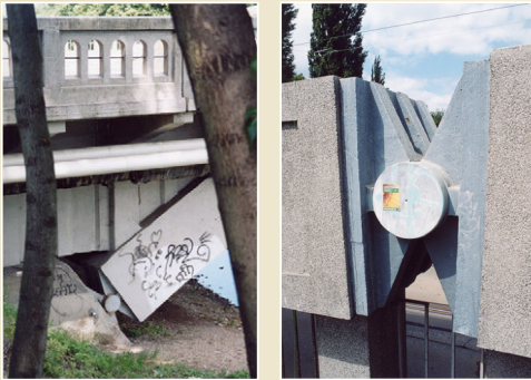
Maloměřický most z roku 1928, 3 oblouky o rozpětí 33 m s průřezem 1 m 2 , mezilehlá mostovka, Brno Trojkloubový rám a oblouk 85 / 129
