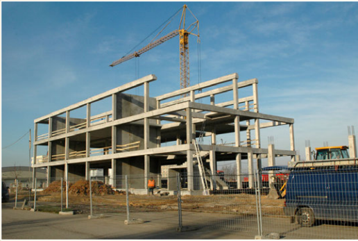
Centrum pokročilých technologií, VŠB-TU Ostrava, realizace 2007
