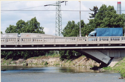
Maloměřický most z roku 1928, 3 oblouky o rozpětí 33 m s průřezem 1 m 2 , mezilehlá mostovka, Brno Trojkloubový rám a oblouk 83 / 129
