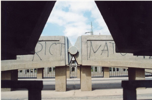
Maloměřický most z roku 1928, 3 oblouky o rozpětí 33 m s průřezem 1 m 2 , mezilehlá mostovka, Brno Trojkloubový rám a oblouk 84 / 129
