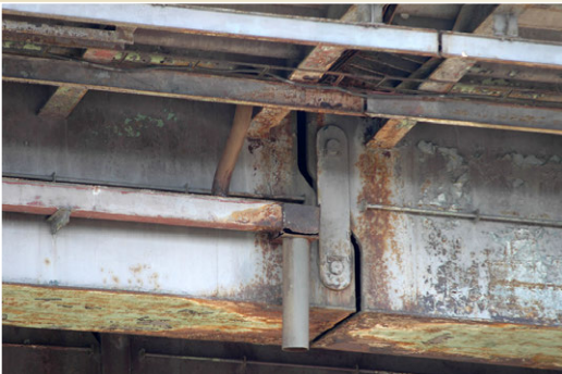
Ocelový most přes řeku Odru z roku 1980, délka 130 m, hmotnost 2.840 t, Ostrava - Svinov
