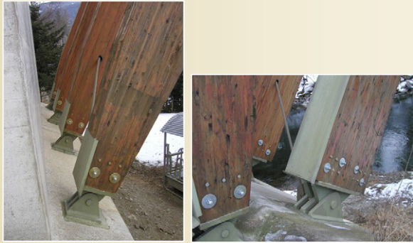
Most z lepeného lamelového dřeva Wennerbruecke přes řeku Mur, St. Georgen, Murau, Rakousko, 4 parabolické trojkloubové oblouky o rozpětí 45 m a vzhpětí 12,5 m, foto: prof. Ing. Antonín Lokaj, Ph.D.
