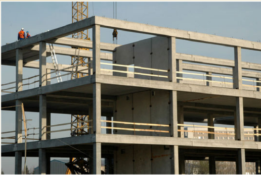
Centrum pokročilých technologií, VŠB-TU Ostrava, realizace 2007
