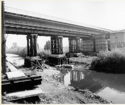
Ocelový most přes řeku Odru z roku 1980, délka 130 m, hmotnost 2.840 t, Ostrava - Svinov
