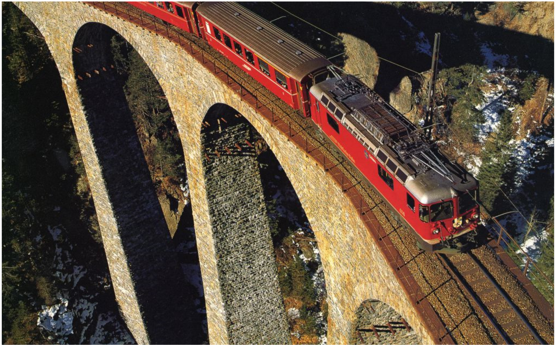
Viadukt u Filisur, výstavba 1901–2, délka 142 m, rozpětí klenby 20 m, výška 65 m, Švýcarsko
