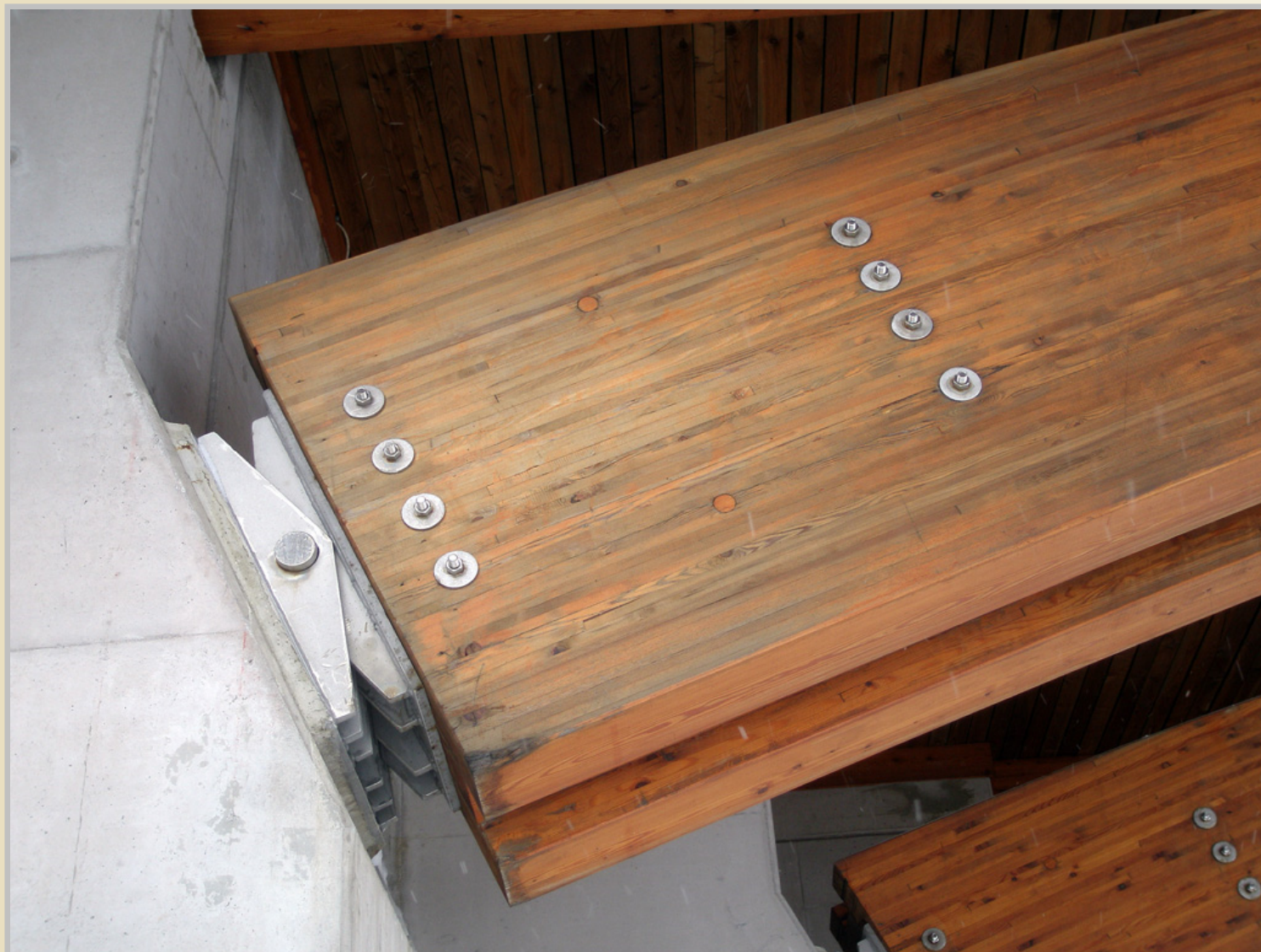
Most z lepeného lamelového dřeva, Obertauern, Rakousko
