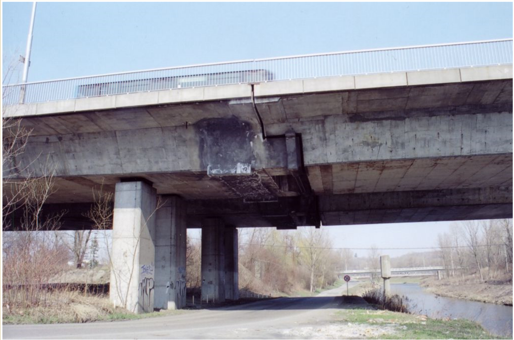
Most přes řeku Ostravici, 2 pole, 1 vnitřní kloub, oboustranný převislý konec, Černá louka, Ostrava
