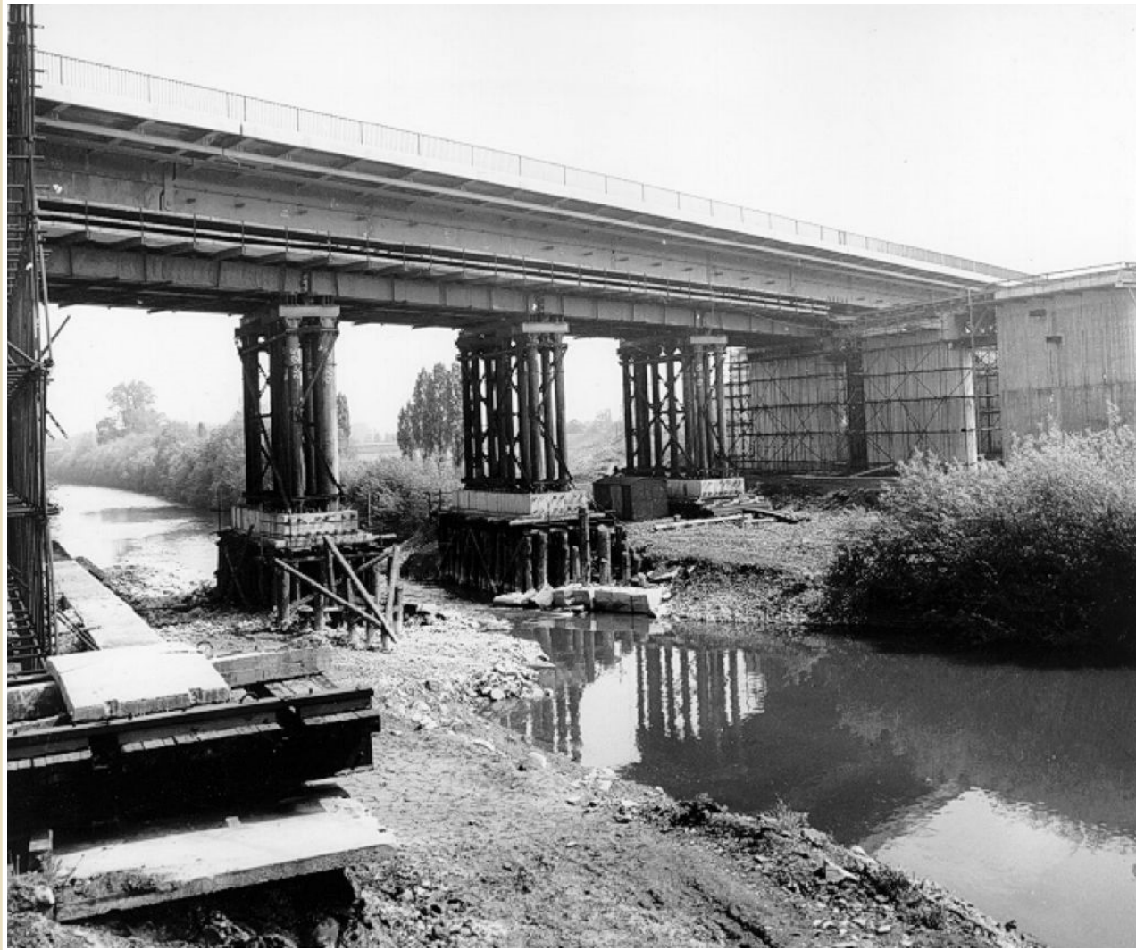
Ocelový most přes řeku Odru z roku 1980, délka 130 m, hmotnost 2.840 t, Ostrava - Svinov
