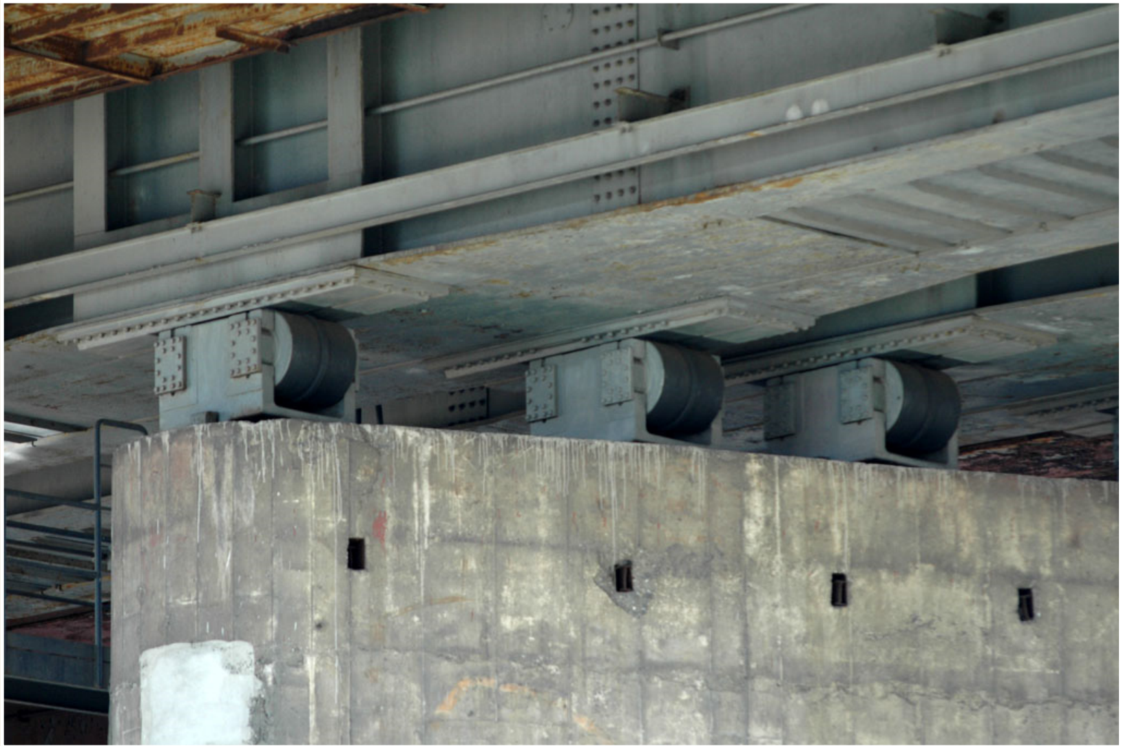
Ocelový most přes řeku Odru z roku 1980, délka 130 m, hmotnost 2.840 t, Ostrava - Svinov
