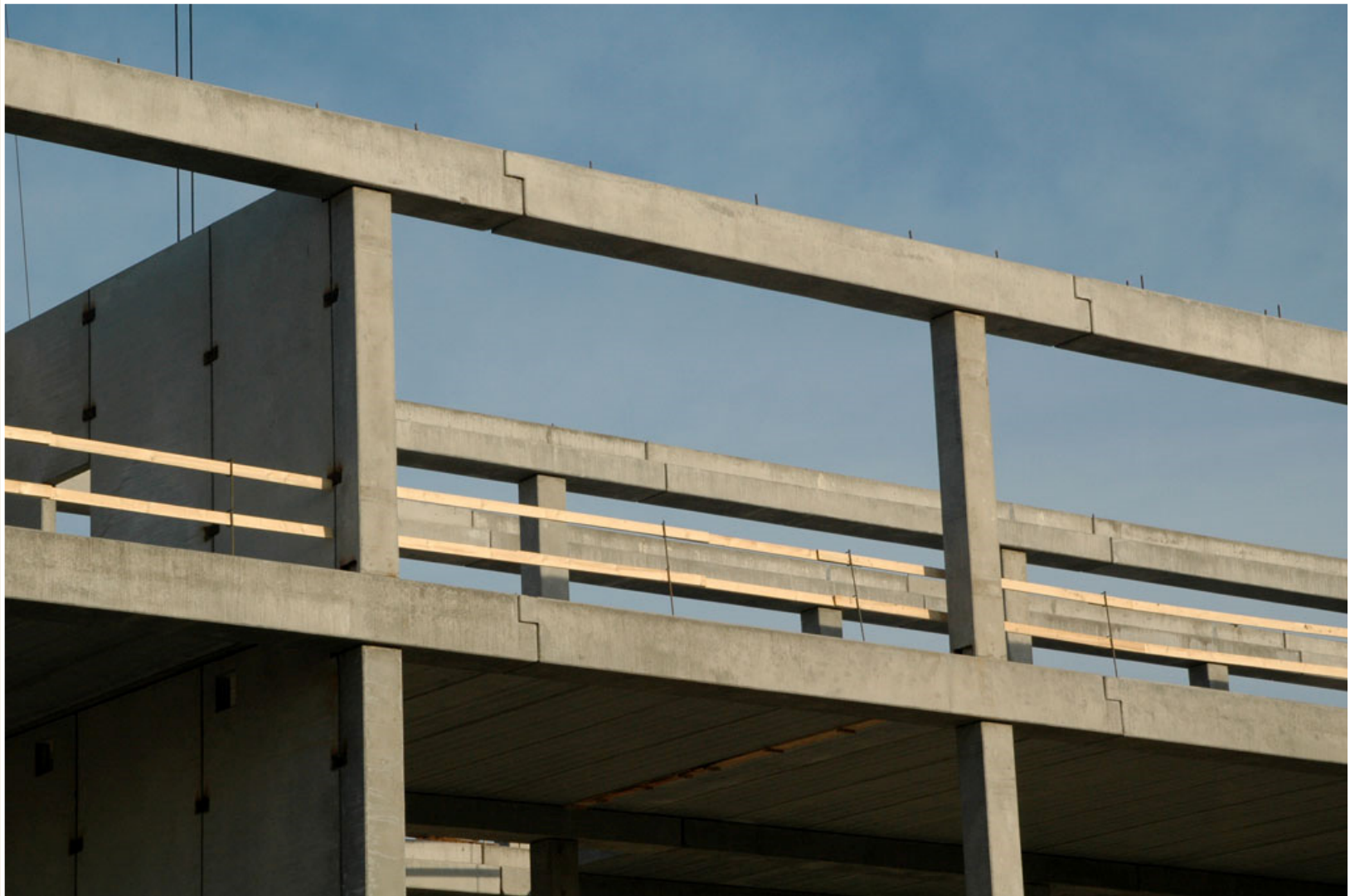
Centrum pokročilých technologií, VŠB-TU Ostrava, realizace 2007
