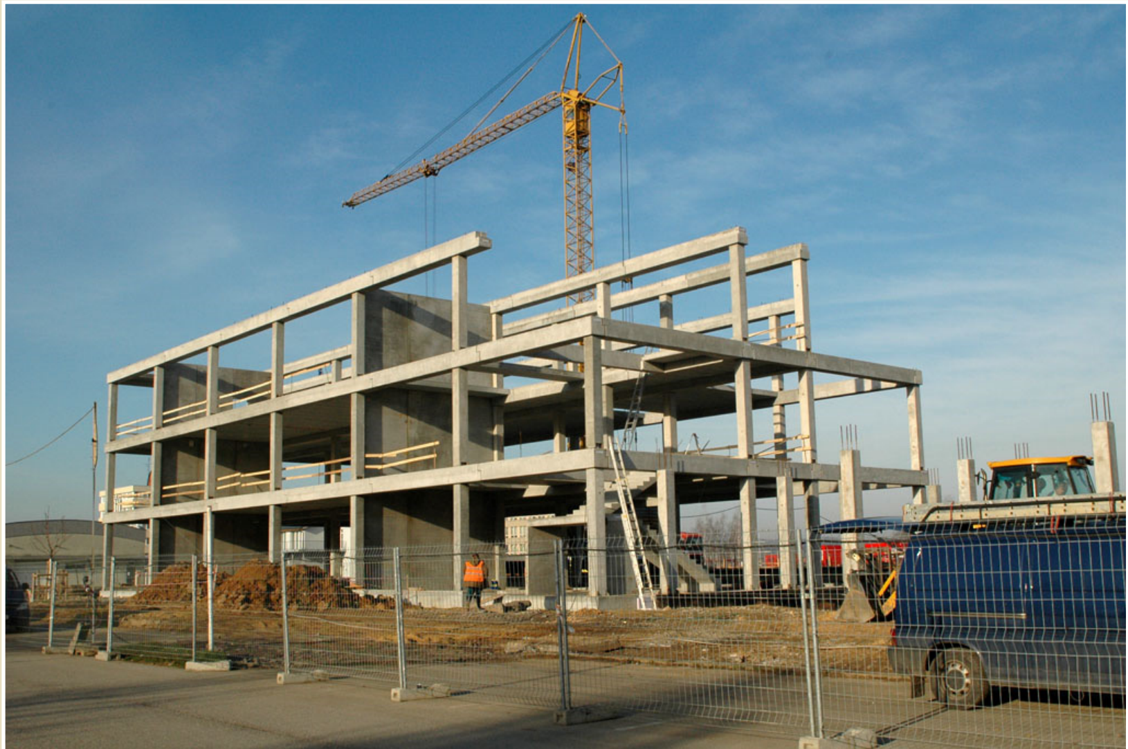
Centrum pokročilých technologií, VŠB-TU Ostrava, realizace 2007
