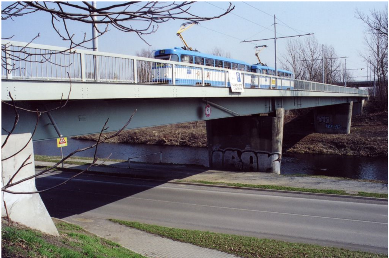
Most přes řeku Ostravici, 3 pole, 2 vnitřní klouby, Černá louka, Ostrava
