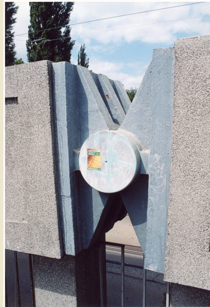
Maloměřický most z roku 1928, 3 oblouky o rozpětí 33 m s průřezem 1 m 2 , mezilehlá mostovka, Brno
