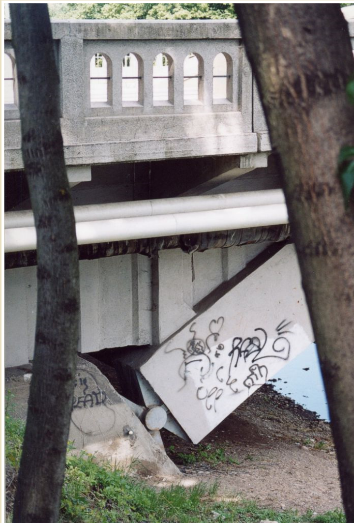
Maloměřický most z roku 1928, 3 oblouky o rozpětí 33 m s průřezem 1 m 2 , mezilehlá mostovka, Brno
