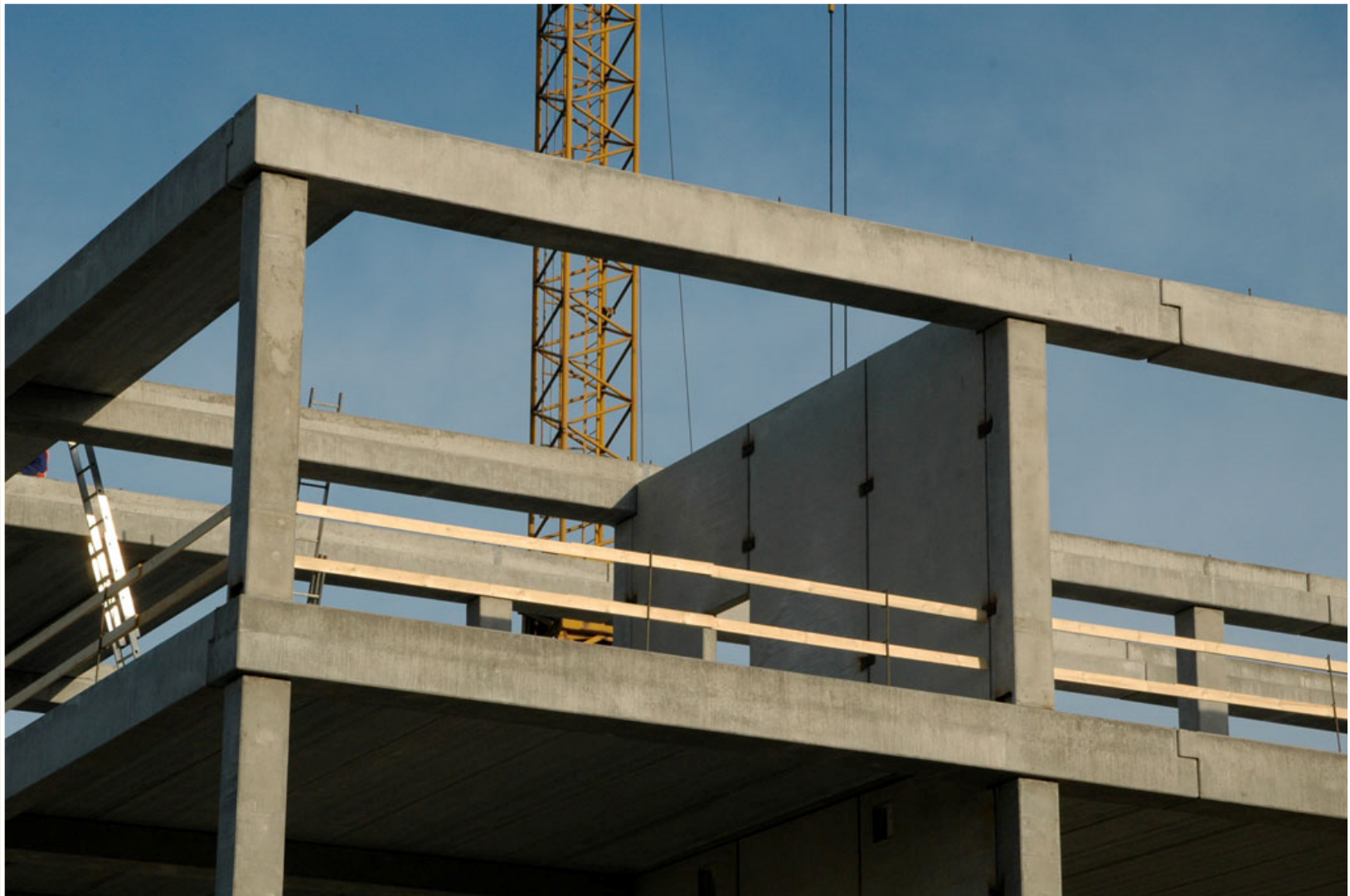
Centrum pokročilých technologií, VŠB-TU Ostrava, realizace 2007
