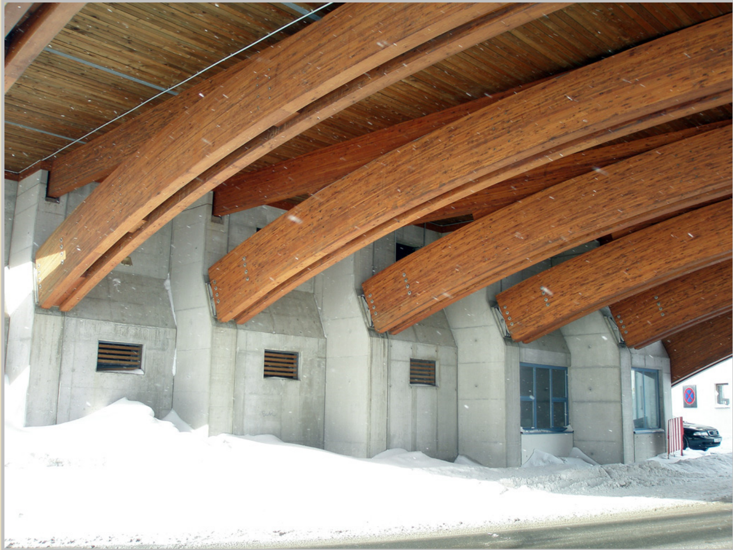
Most z lepeného lamelového dřeva, Obertauern, Rakousko
