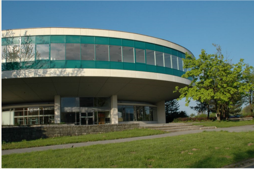
Posluchárny Vysoké školy báňské – Technická univerzita Ostrava
