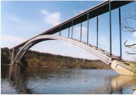
Žďákovský obloukový most z roku 1965, délka 540 m, hlavní oblouk o rozpětí 330 m podpírá konstrukci mostovky ve výšce 50 m nad hladinou jezera Orlické přehrady.
