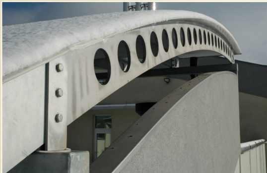
Rovinně zakřivený vazník, Výzkumné energetické centrum VŠB-TU Ostrava
