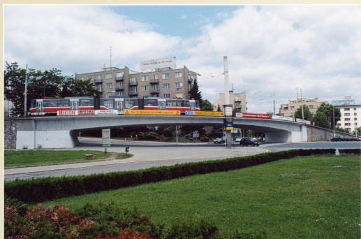
Železobetonový předpjatý tramvajový most Brno – Pisárky, specifický svým zakřivením, stoupáním a nestějnou tloušťkou, šířky 9 m.
