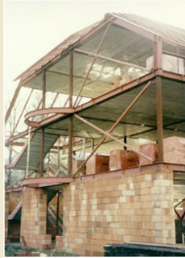
Balkónové nosníky nosné konstrukce základní školy, Brumov – Bylnice, projekt OKM
