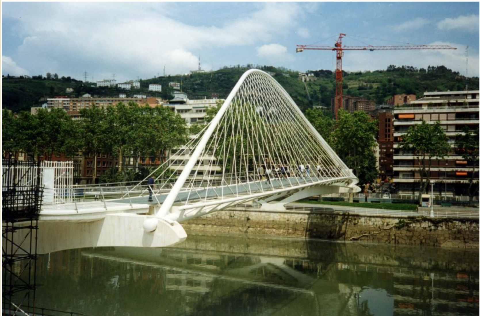
Prostorově zakřivený nosník mostu Zubizuri Bridge, Bilbao, Španělsko
