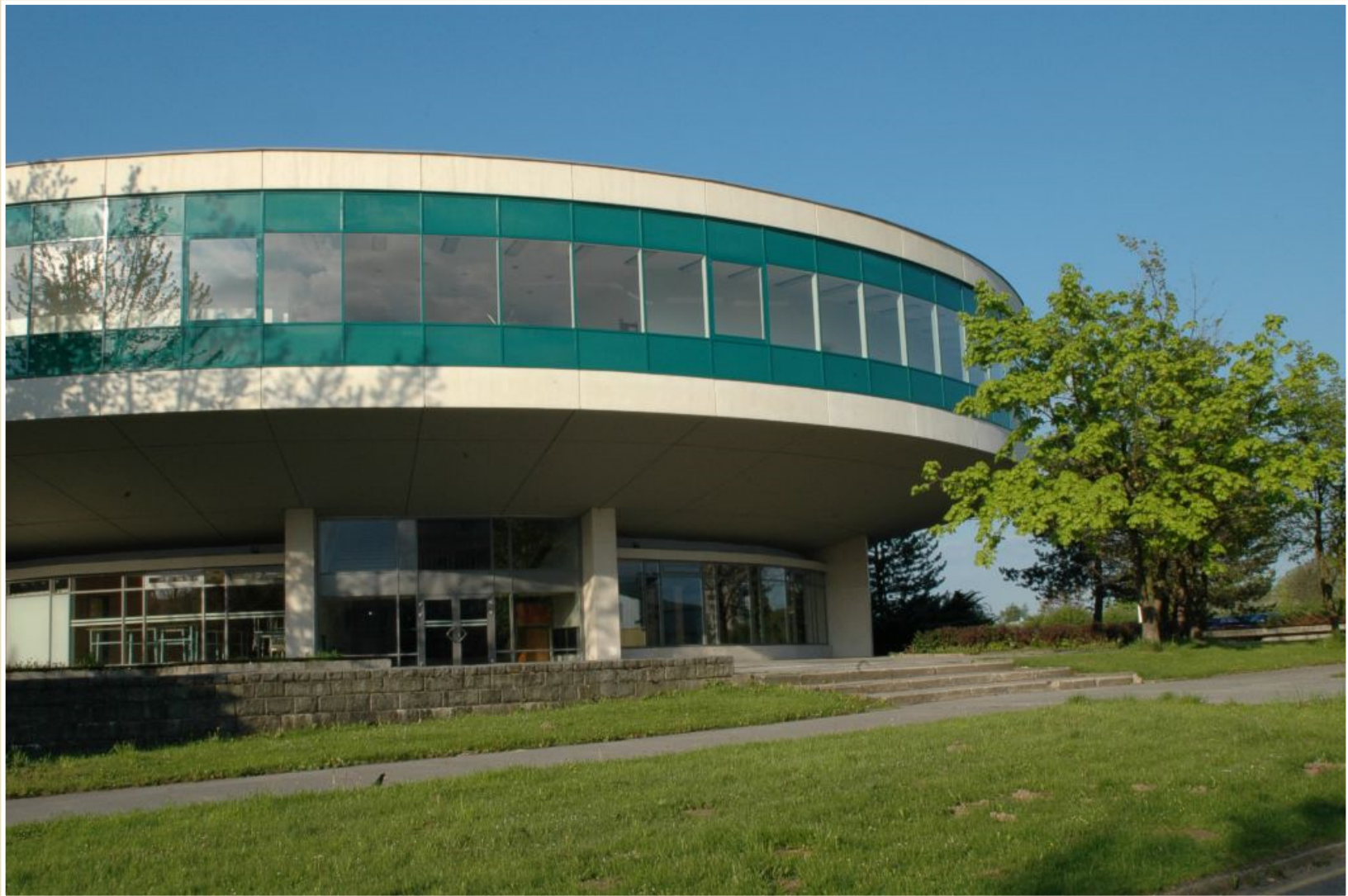
Posluchárny Vysoké školy báňské – Technická univerzita Ostrava
