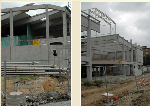
Prosté nosníky železobetonového skeletu, Interspar, Ostrava-Poruba
