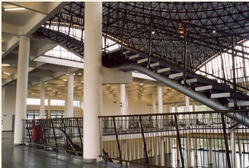
Konstrukce schodiště pavilonu C, Brněnské výstaviště
