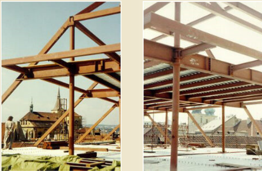
Nosná konstrukce střechy kostelu sv. Michala, Praha, projekt OKM
