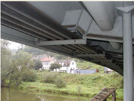
Chodníková konzola mostní konstrukce
