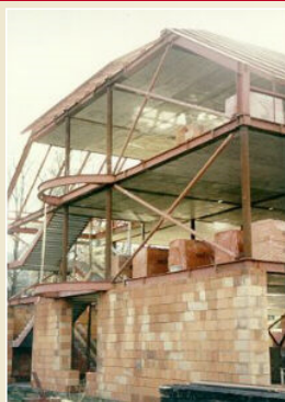
Nosná konstrukce střechy základní školy, Brumov – Bylnice, projekt OKM
