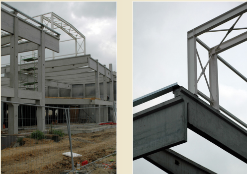
Převislé konce železobetonového skeletu, supermarket Albert, Ostrava-Poruba
