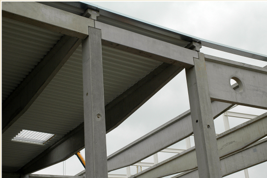
Prosté nosníky železobetonového skeletu, Albert, Ostrava-Poruba
