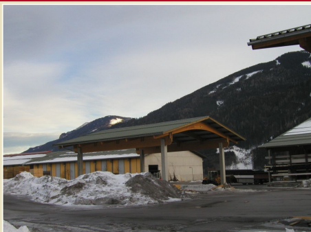
Nosná konstrukce střechy z lepeného lamelového dřeva, Stýrsko v Rakousku, foto: prof. Ing. Antonín Lokaj, Ph.D. Výpočet nosníku v příčné úloze (ve svislé hlavní rovině xz ) 74 / 110
