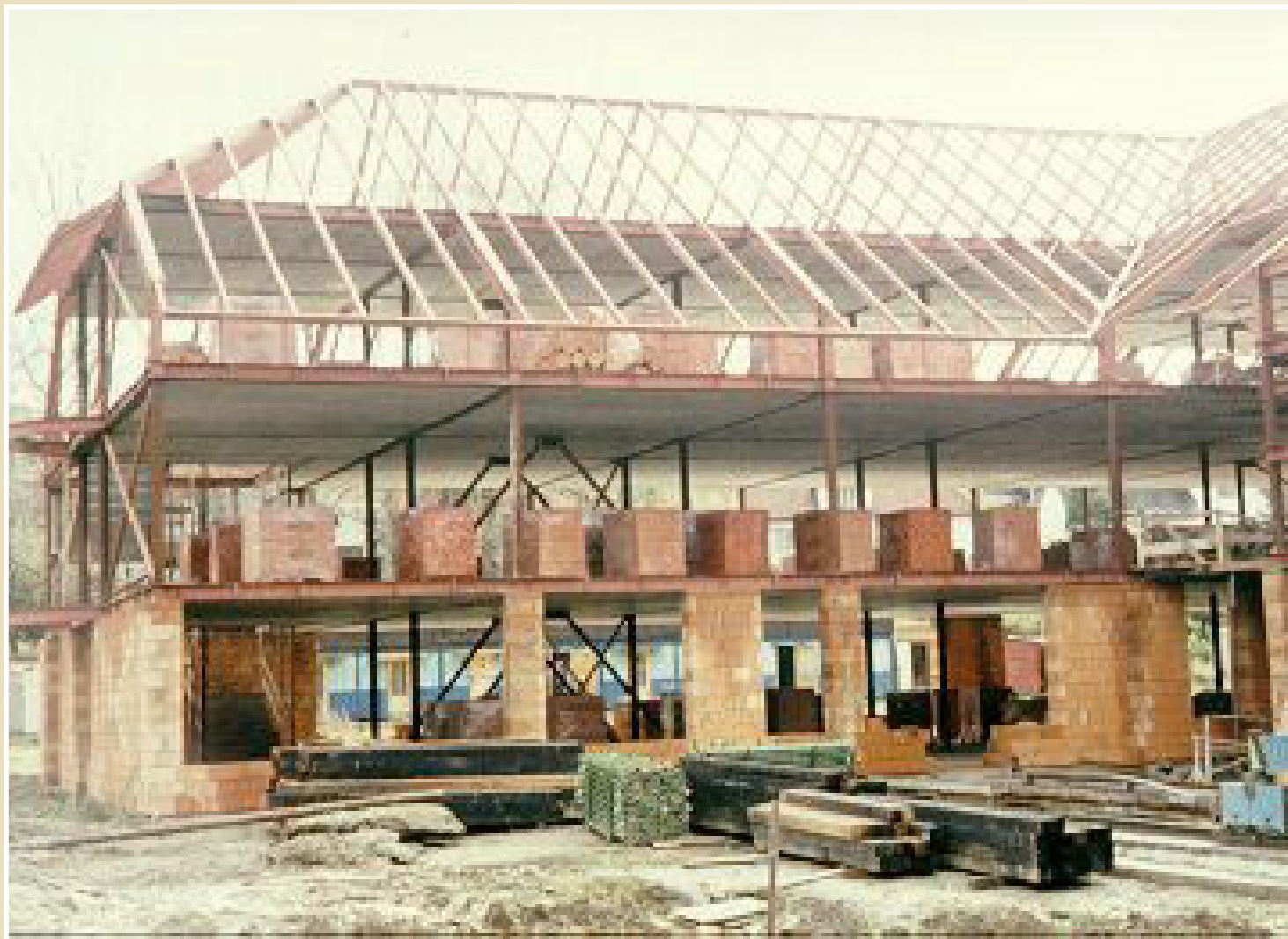
Nosná konstrukce střechy základní školy, Brumov – Bylnice, projekt OKM
