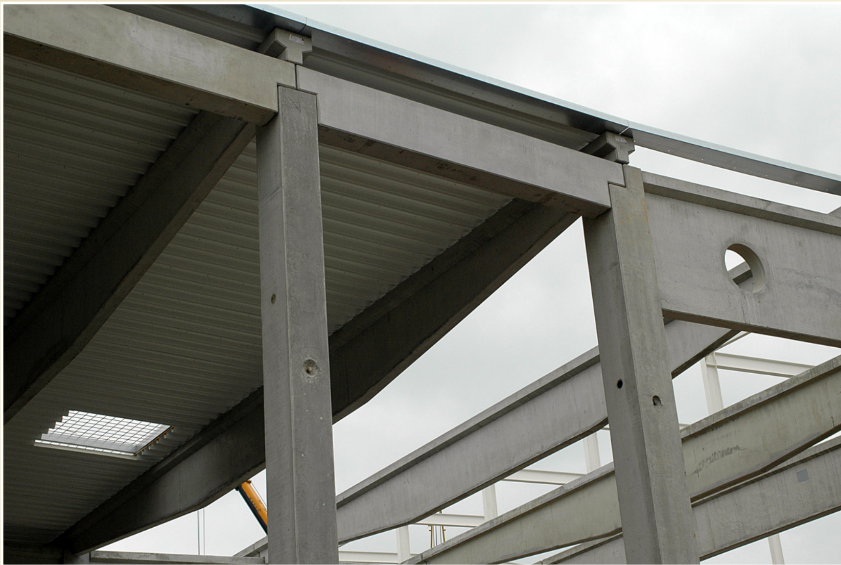
Prosté nosníky železobetonového skeletu, Albert, Ostrava-Poruba
