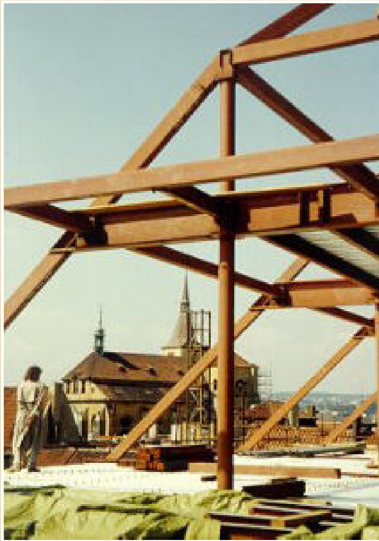
Nosná konstrukce střechy kostelu sv. Michala, Praha, projekt OKM
