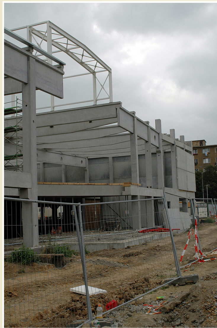
Prosté nosníky železobetonového skeletu, Interspar, Ostrava-Poruba
