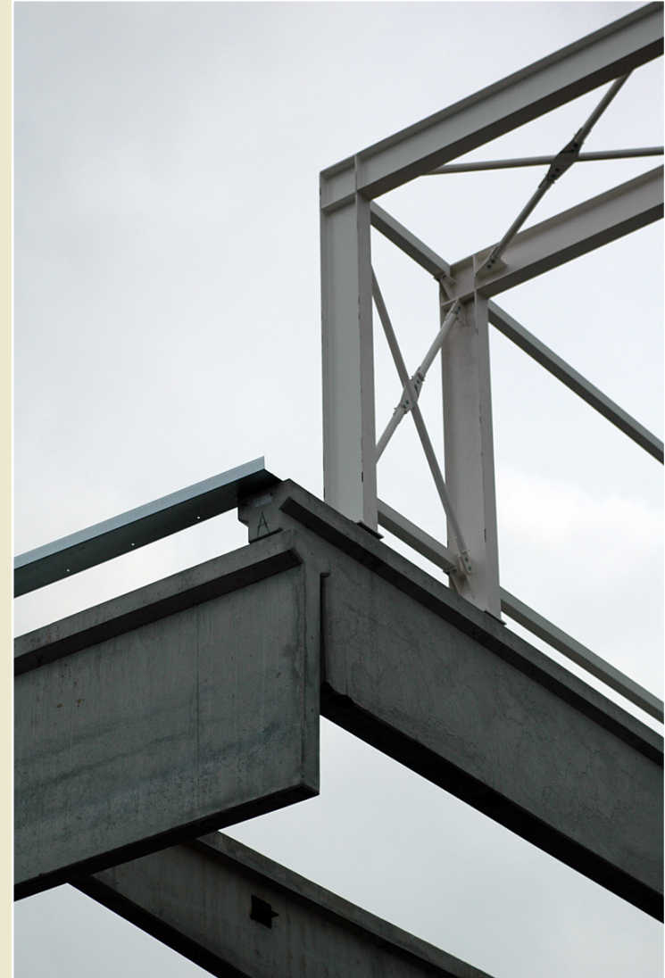
Převislé konce železobetonového skeletu, supermarket Albert, Ostrava-Poruba
