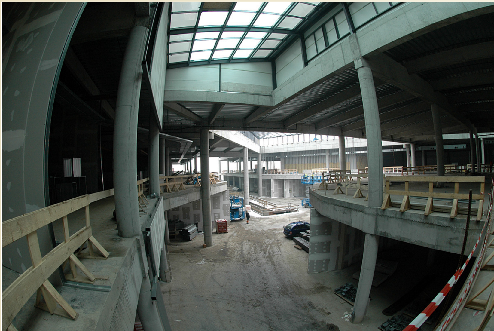
Konstrukce ocelových světlíků, Ikea-Avion Shopping Park, Ostrava-Zábřeh
