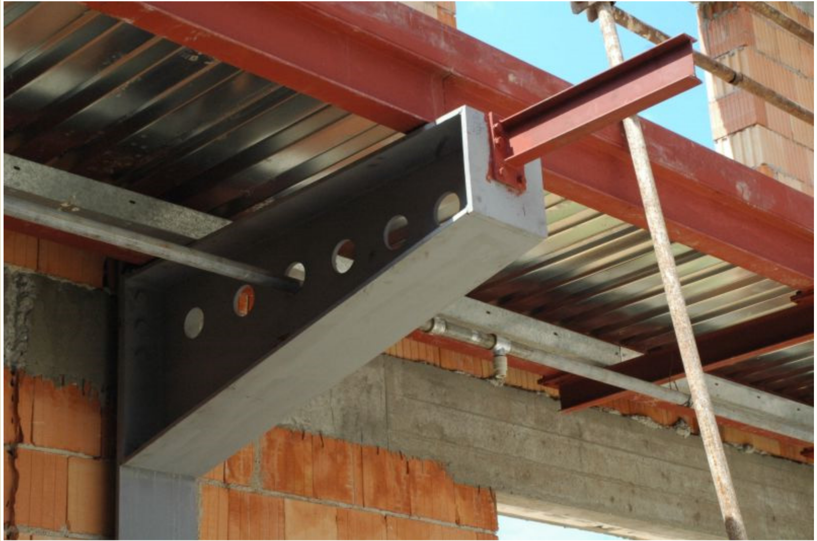
Nosná konstrukce plošiny, Výzkumné energetické centrum VŠB-TU Ostrava
