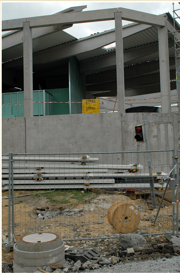
Prosté nosníky železobetonového skeletu, Interspar, Ostrava-Poruba
