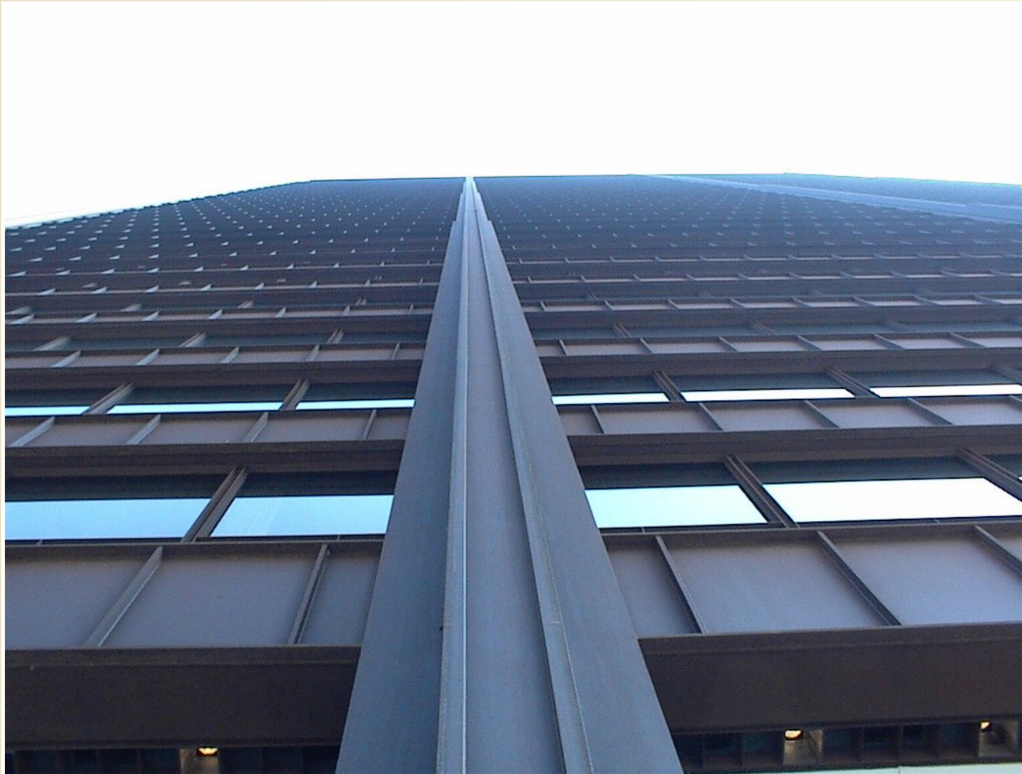
Odstupňovaný průřez sloupu Richard Daley Center v Chicagu z roku 1965
