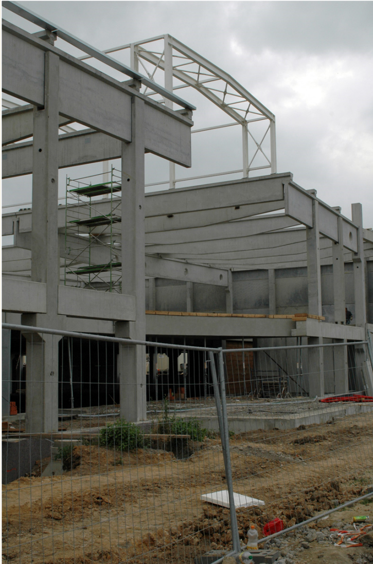
Převislé konce železobetonového skeletu, supermarket Albert, Ostrava-Poruba
