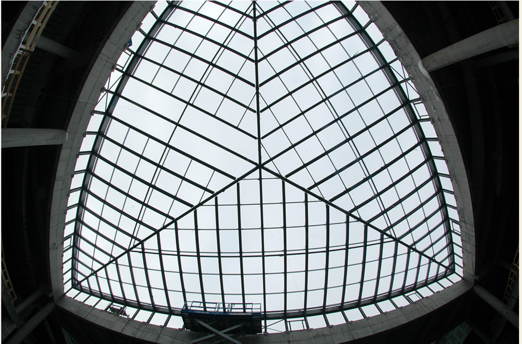
Konstrukce ocelových světlíků, Ikea-Avion Shopping Park, Ostrava-Zábřeh
