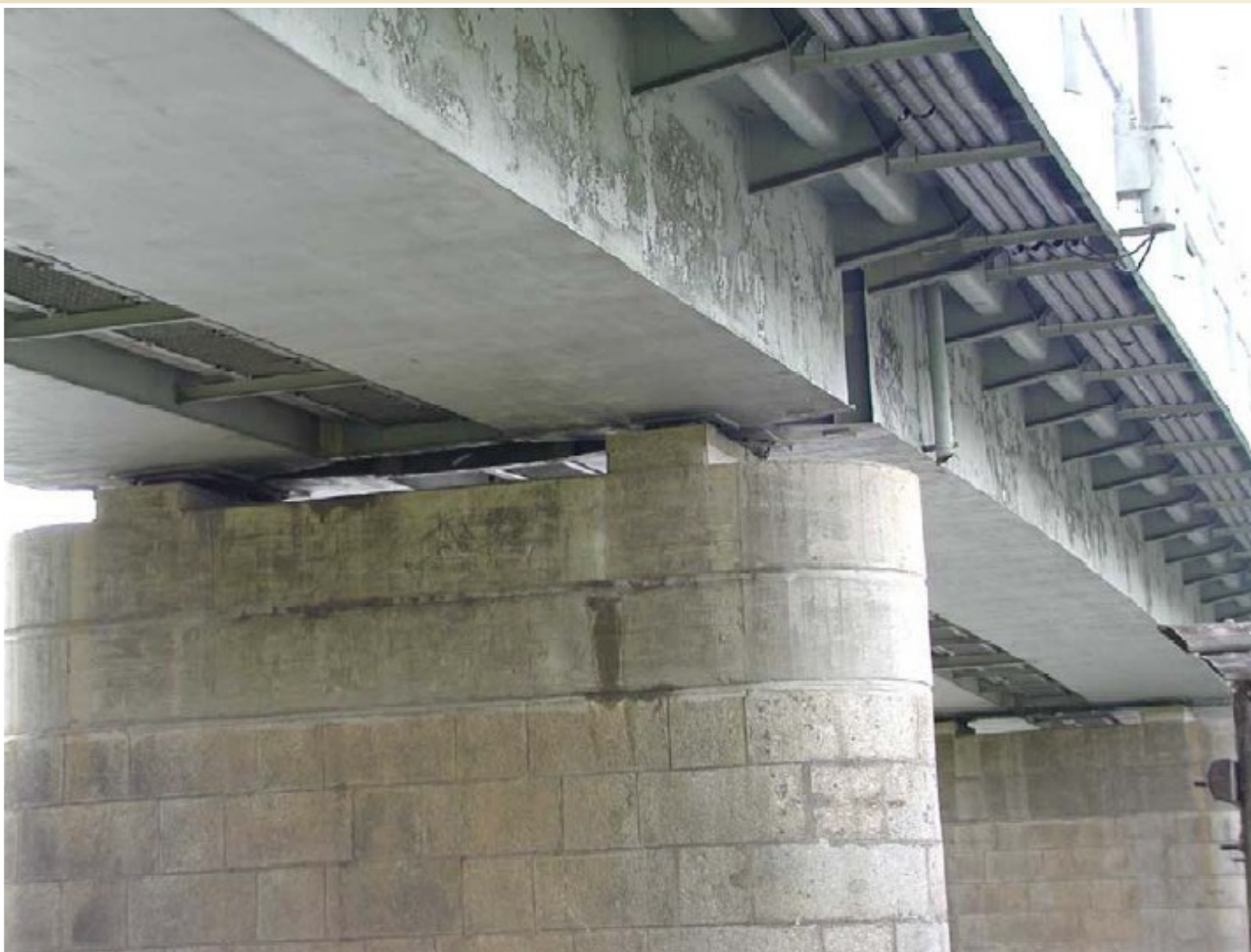
Chodníková konzola mostní konstrukce
