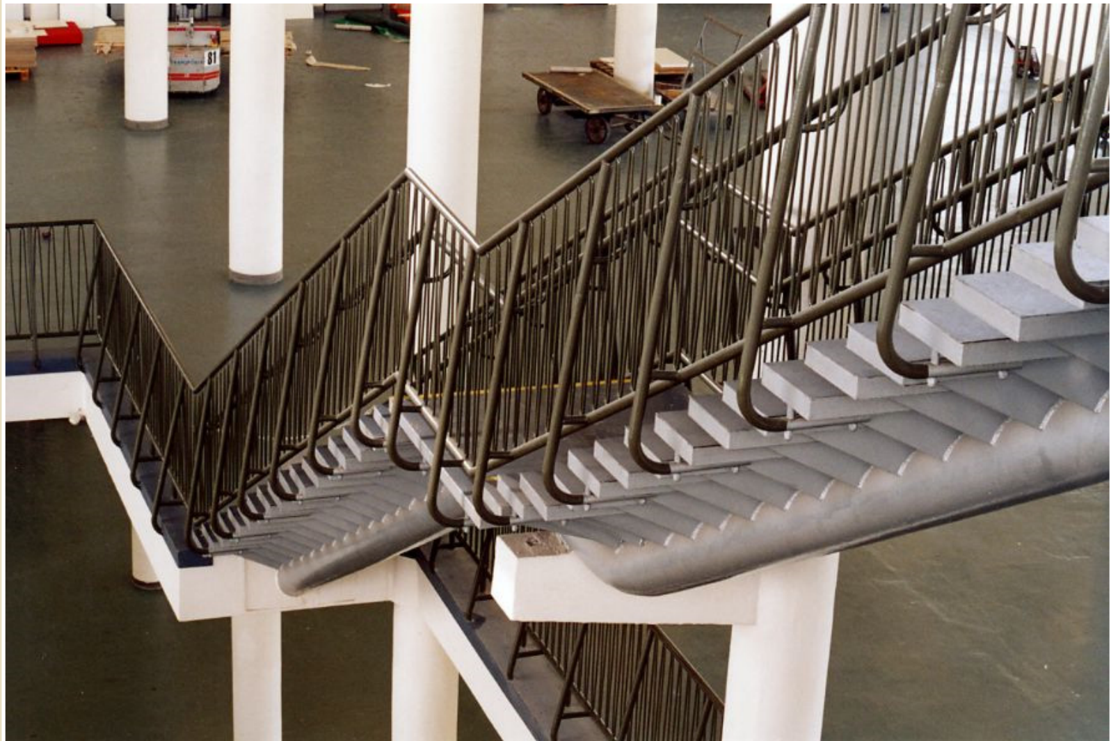
Konstrukce schodiště pavilonu C, Brněnské výstaviště
