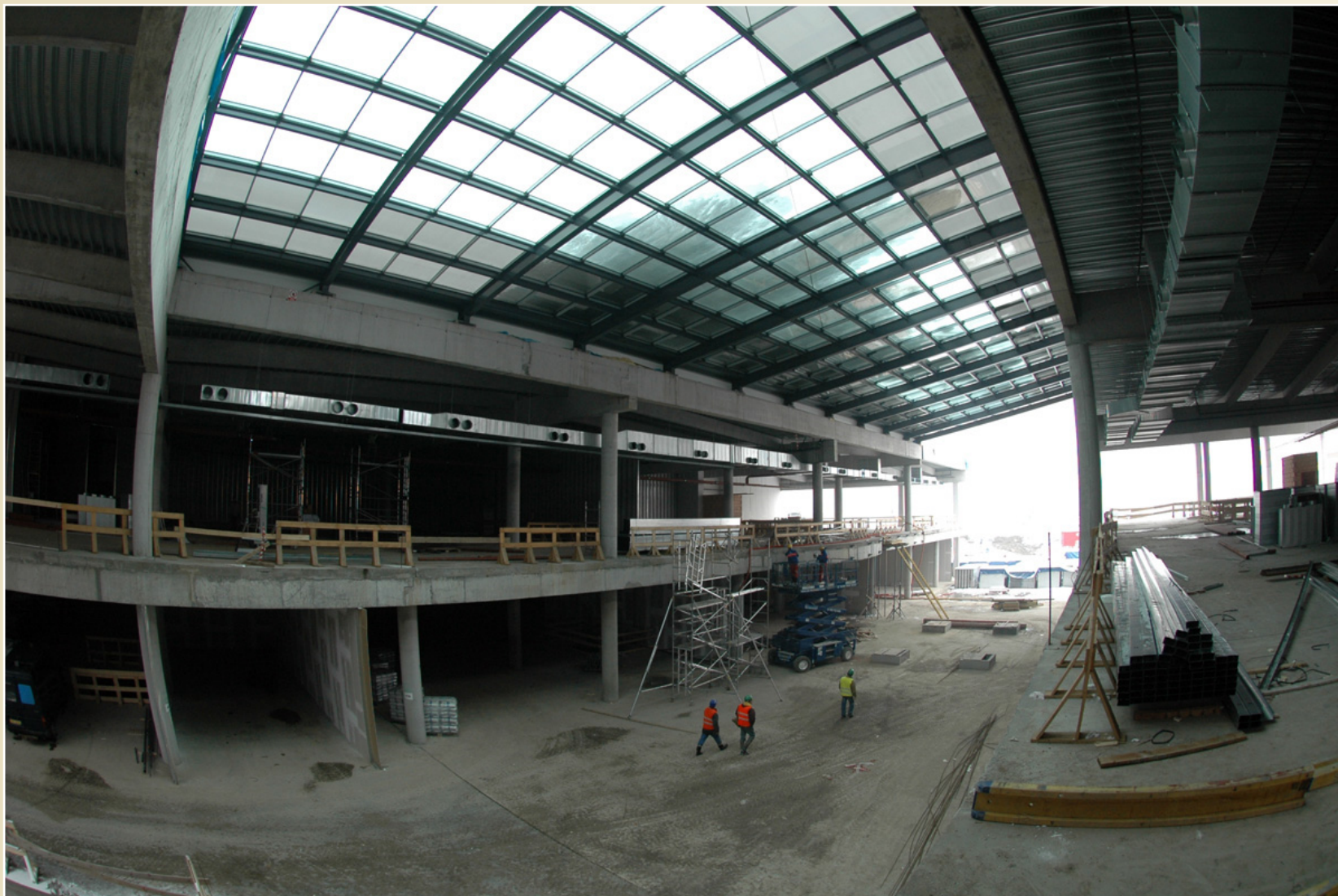
Konstrukce ocelových světlíků, Ikea-Avion Shopping Park, Ostrava-Zábřeh
