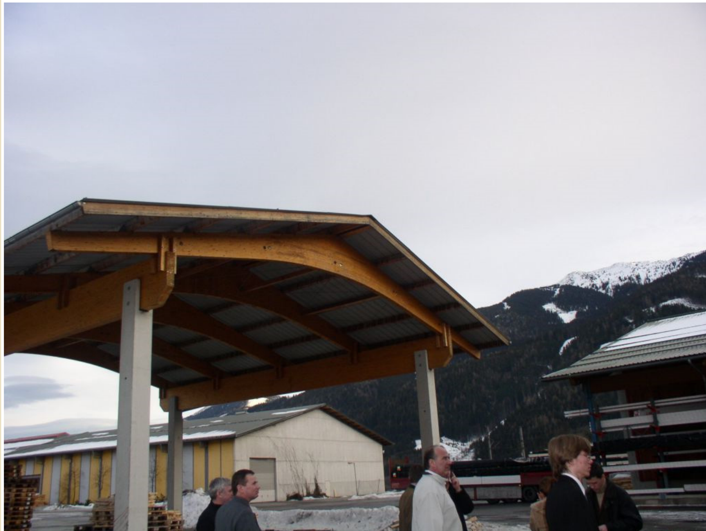
Nosná konstrukce střechy z lepeného lamelového dřeva, Štýrsko v Rakousku, foto: prof. Ing. Antonín Lokaj, Ph.D.
