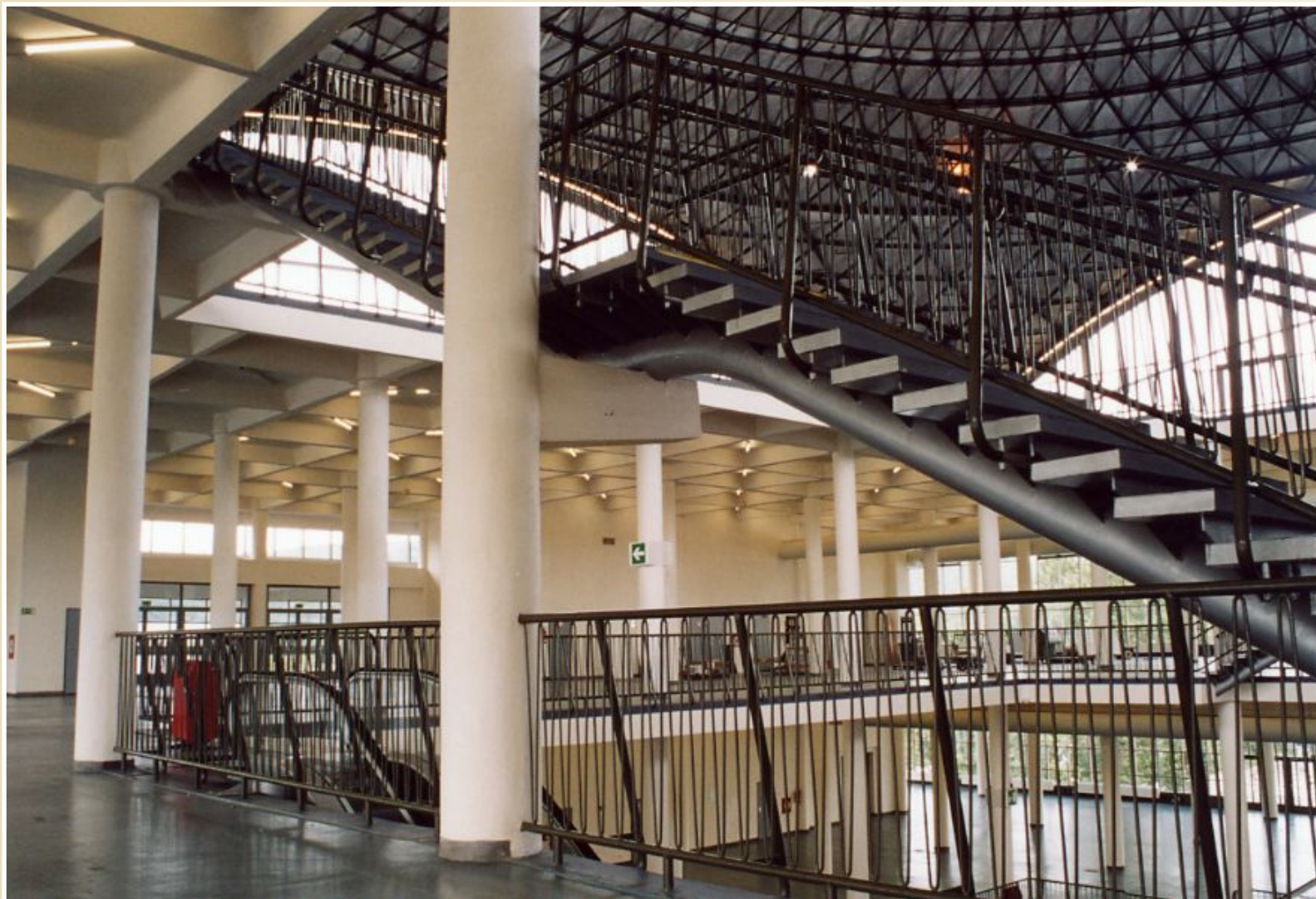
Konstrukce schodiště pavilonu C, Brněnské výstaviště
