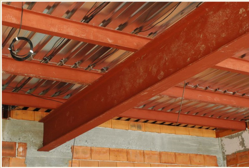
Stropní konstrukce výzkumného energetického centra VŠB-TU Ostrava
