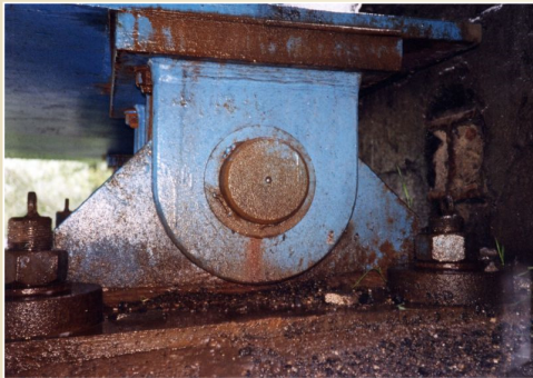
Havířov, železniční most přes silnici Rudná
