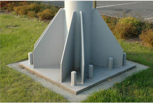
Sloup s podepřením vetknutím
