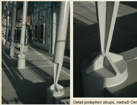
Detail podepření sloupu, nádraží Ostrava - Svinov
