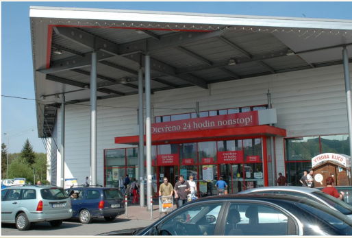
Podepření střešní konstrukce sloupy, Tesco, Ostrava - Třebovice
