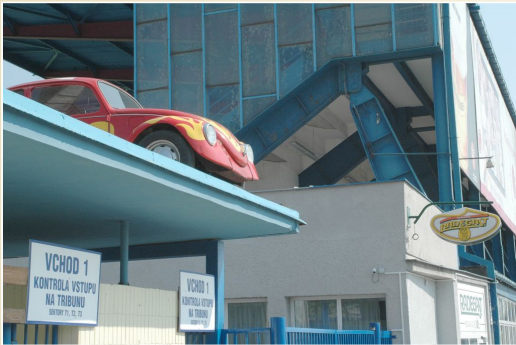
Tribuna fotbalového stadionu Baníku Ostrava, Ostrava - Bazaly
