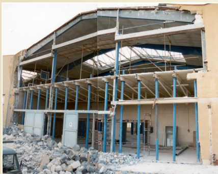
Provizorní podepření stropu stojkami
