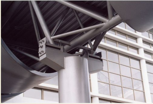
Krytý přechod mezi pavilony A a C, průměr kruhového válce 496 cm, Brněnské výstaviště
