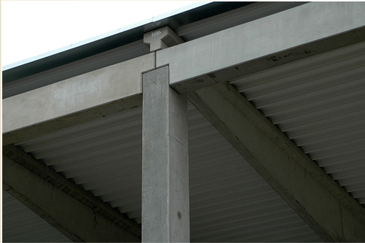
Kloubově uložené nosníky železobetonového skeletu, Albert, Ostrava-Poruba
