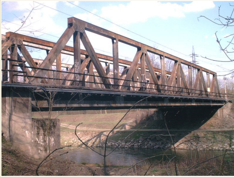
Most přes řeku Odru z roku 1964, Polanecká spojka, Ostrava – Zábřeh
