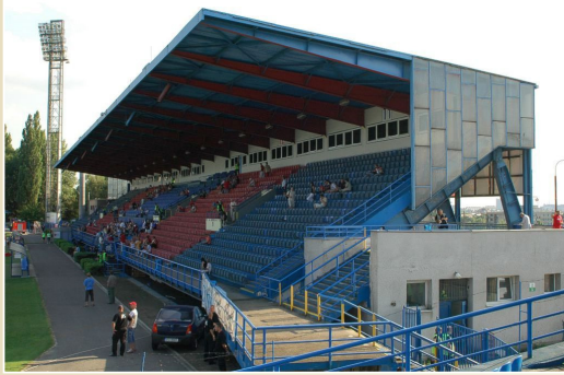
Tribuna fotbalového stadionu Baníku Ostrava, Ostrava - Bazaly
