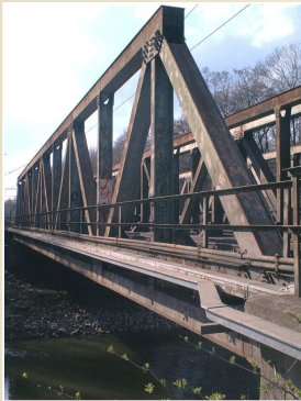
Most přes řeku Odru z roku 1964, Polanecká spojka, Ostrava – Zábřeh
