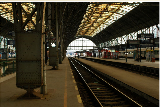
Podepření konstrukce nástupní haly, Hlavní nádraží, Praha
