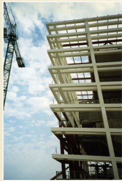
Konstrukce prostorového rámu Kursaal Convention Centre and Auditorium, San Sebastian, Španělsko
