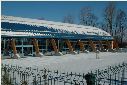
Nosný systém dřevěné konstrukce, Aquapark, Bohumín
