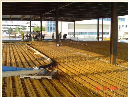
Deska – plošný nosný prvek, zatížený kolmo ke střednicové ploše
