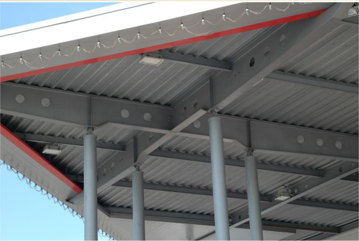
Podepření střešní konstrukce sloupy, Tesco, Ostrava - Třebovice
