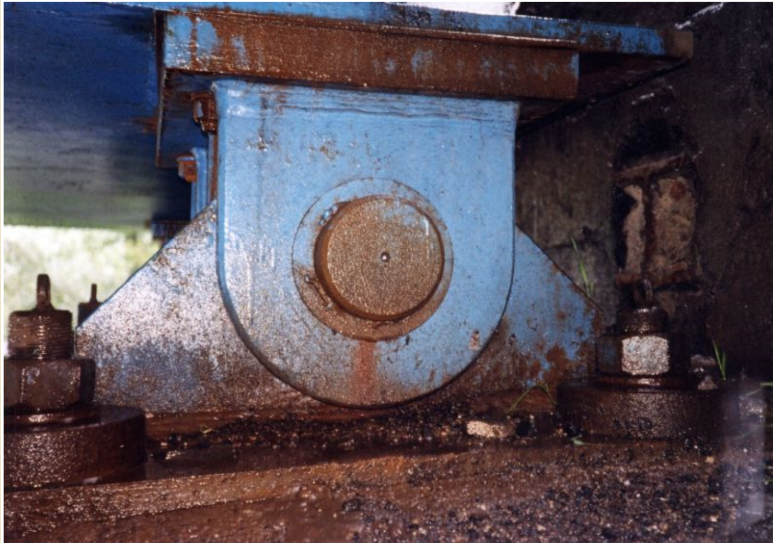
Havířov, železniční most přes silnici Rudná
