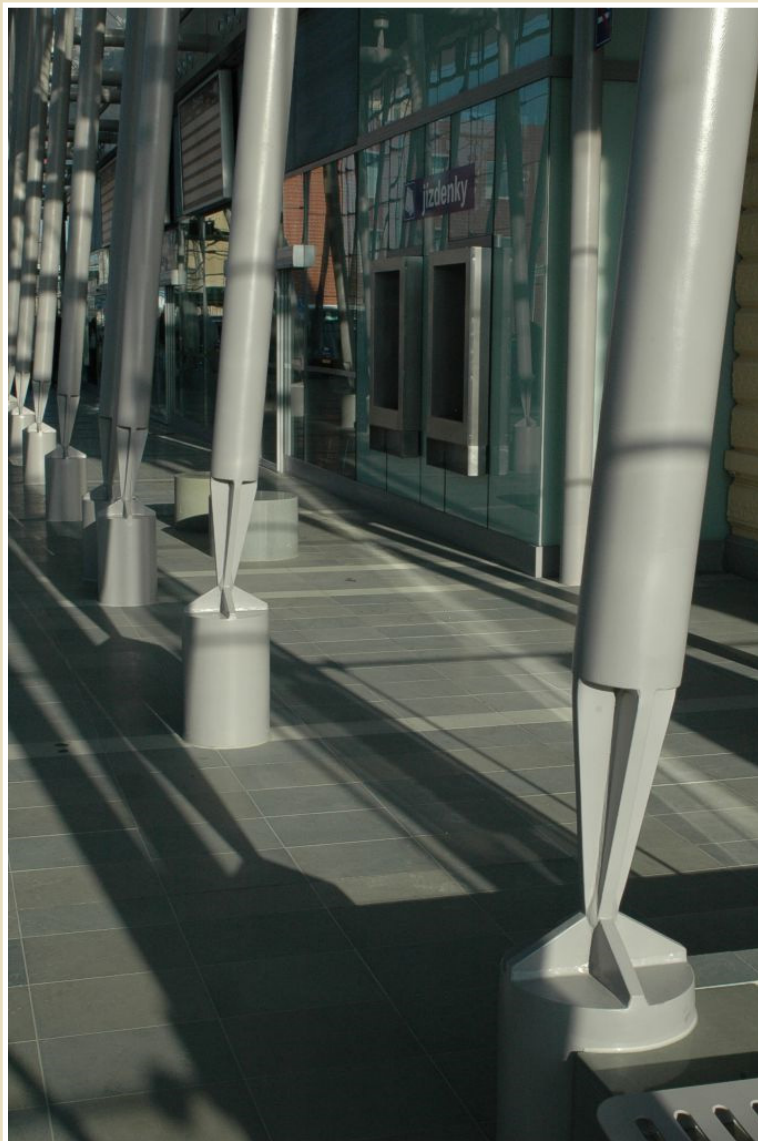
Detail podepření sloupu, nádraží Ostrava - Svinov
