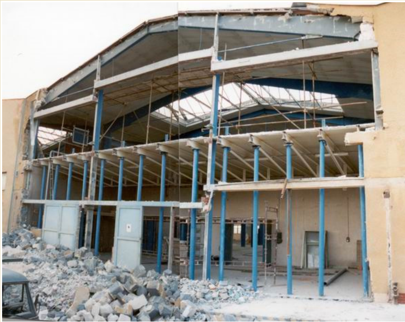
Provizorní podepření stropu stojkami
