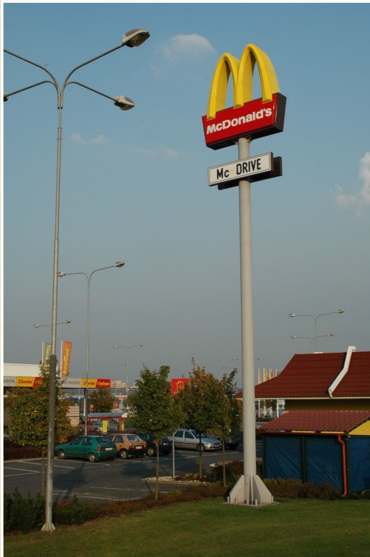
Sloup s podepřením vetknutím
