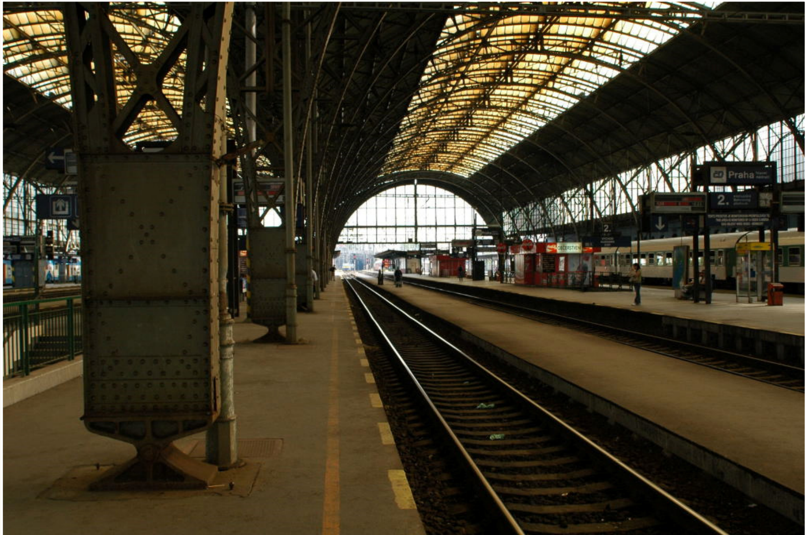
Podpěření konstrukce nástupní haly, Hlavní nádraží, Praha
