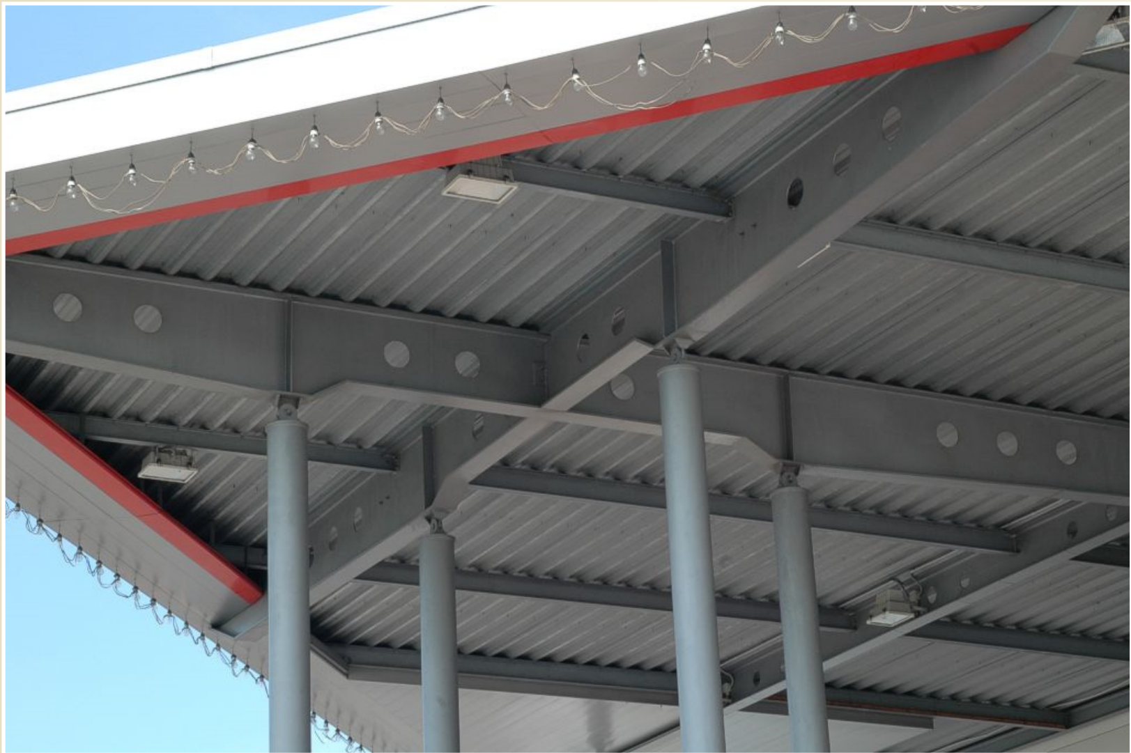
Podpření střešní konstrukce sloupy, Tesco, Ostrava - Třebovice
