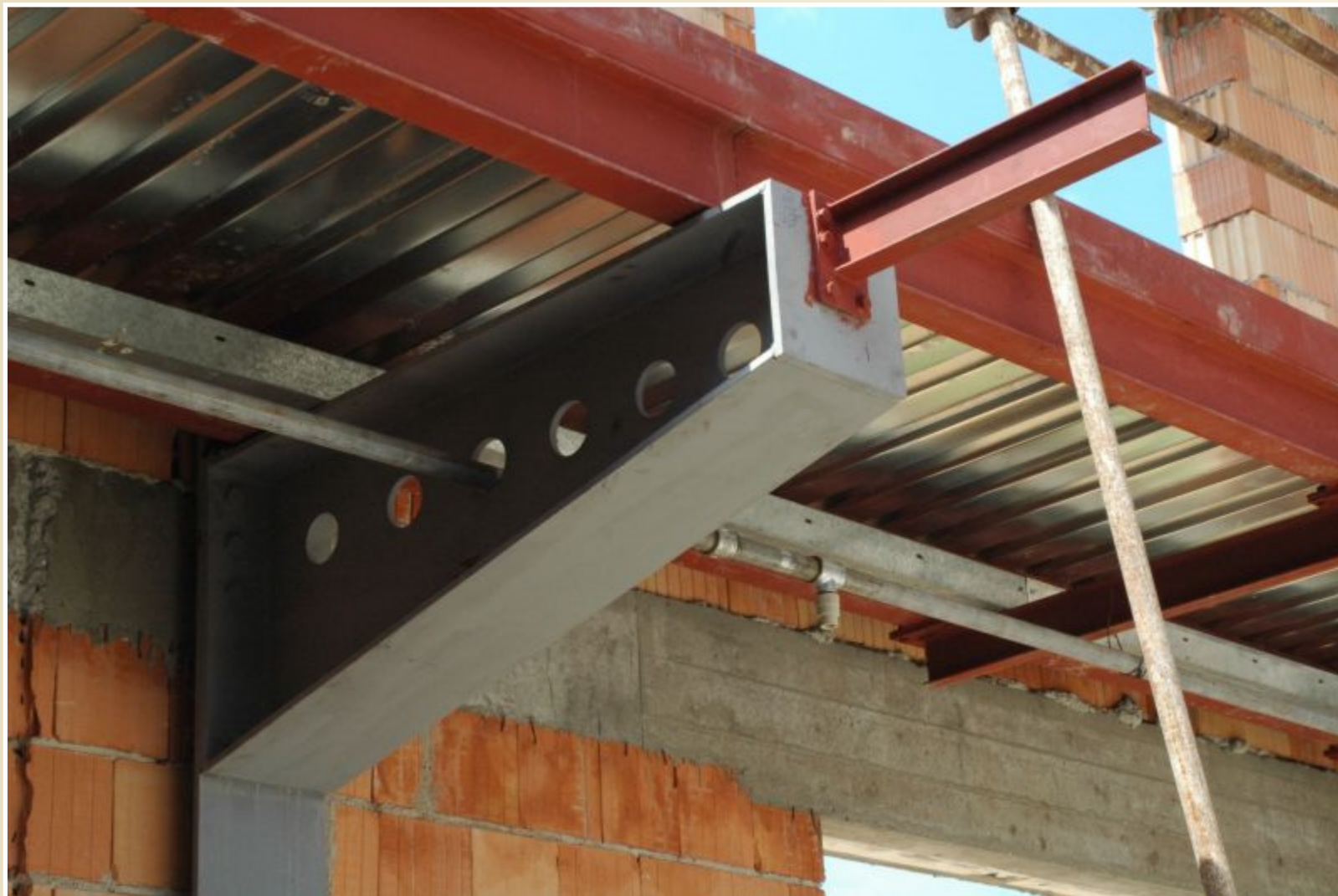
Konzolový nosník, výzkumné energetické centrum VŠB-TU Ostrava
