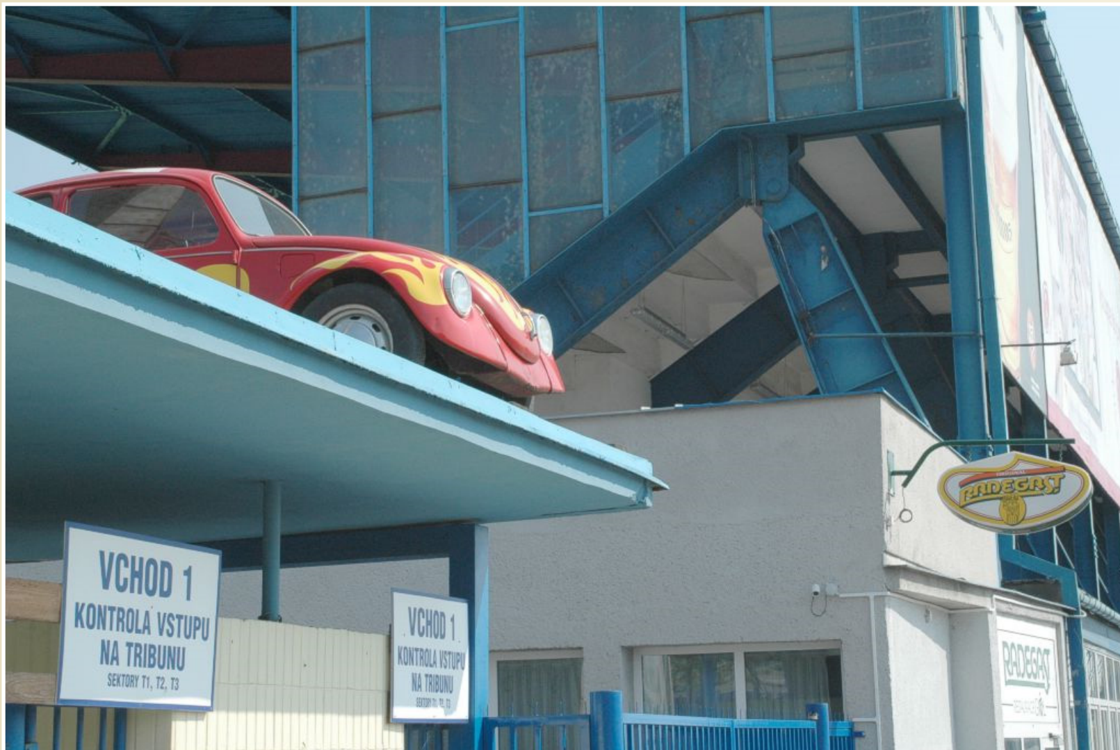
Tribuna fotbalového stadionu Baníku Ostrava, Ostrava - Bazaly
