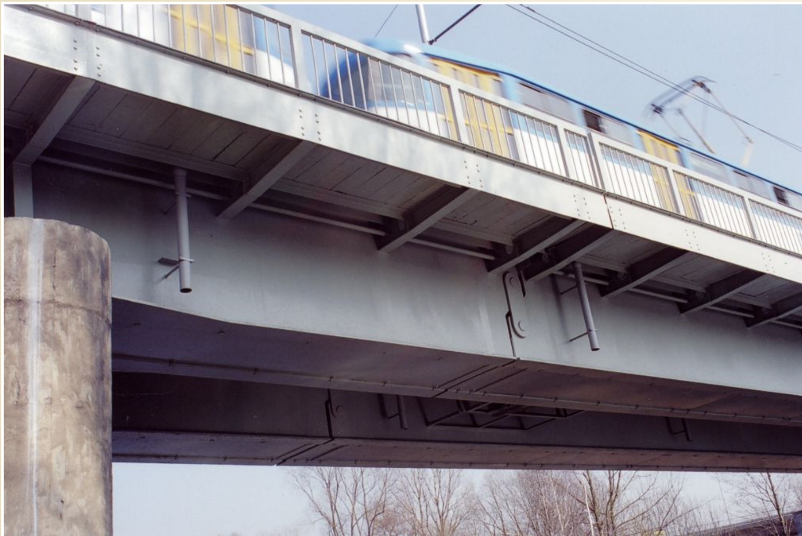
Most přes řeku Ostravici u Výstaviště, Ostrava
