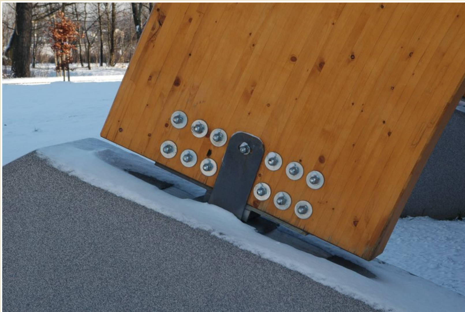
Detail podepření dřevěné konstrukce, Aquapark, Bohumín
