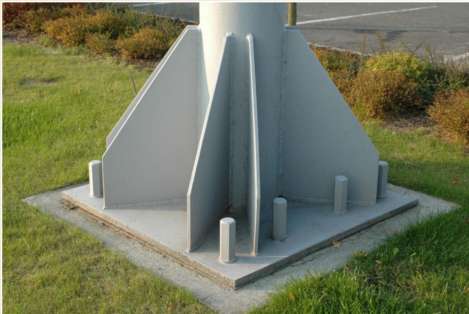
Sloup s podepřením vetknutím
