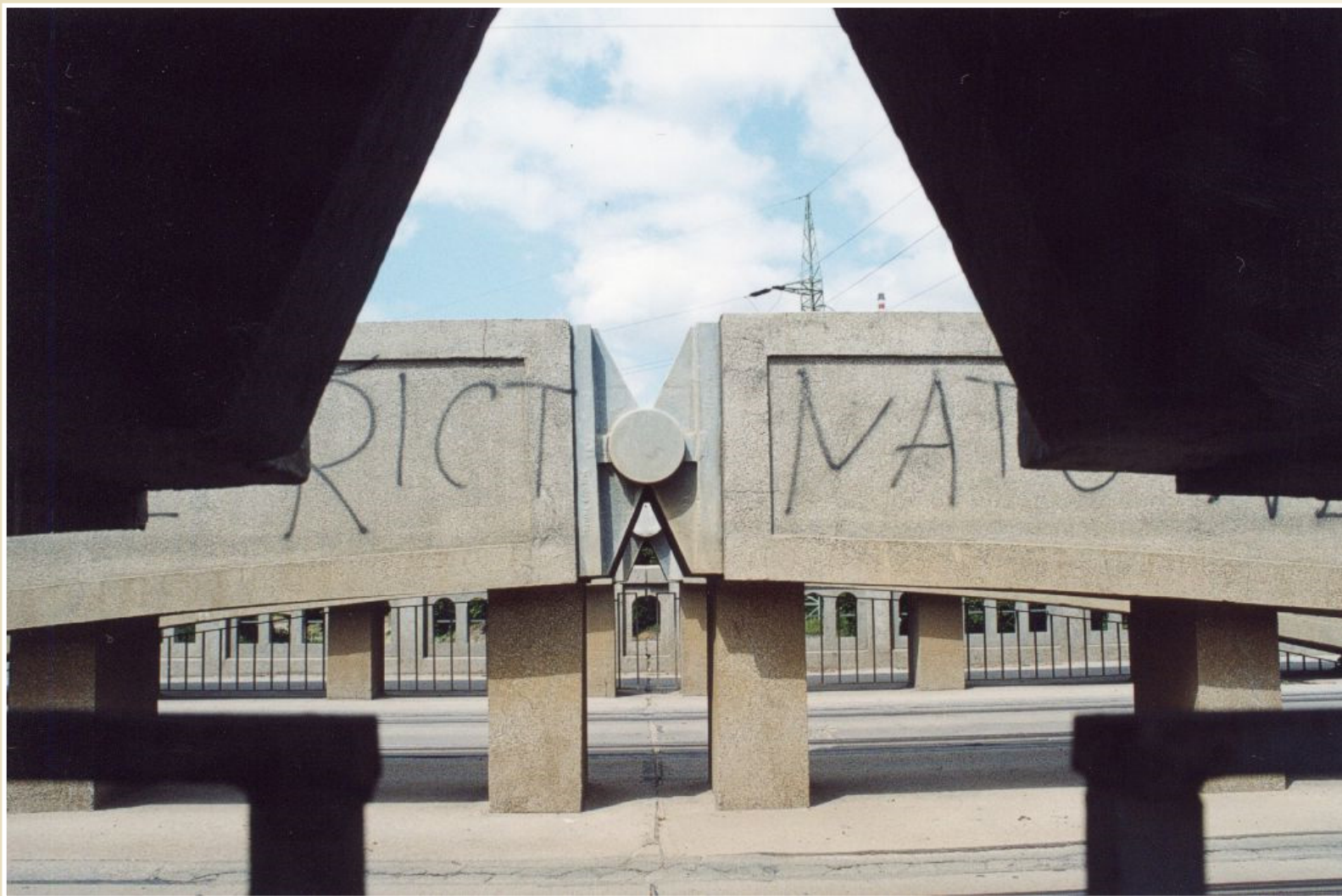
Maloměřický most z roku 1928, 3 oblouky o rozpětí 33 m s průřezem 1 m 2 , mezilehlá mostovka, Brno
