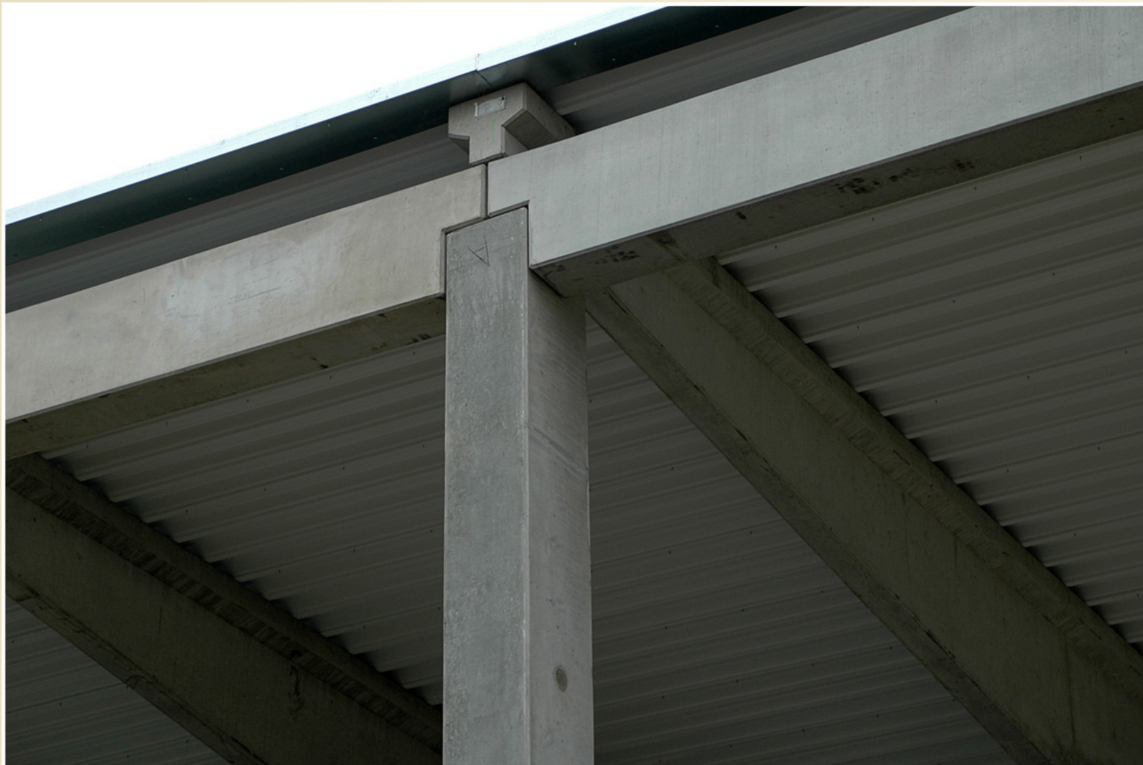
Kloubově uložené nosníky železobetonového skeletu, Albert, Ostrava-Poruba
