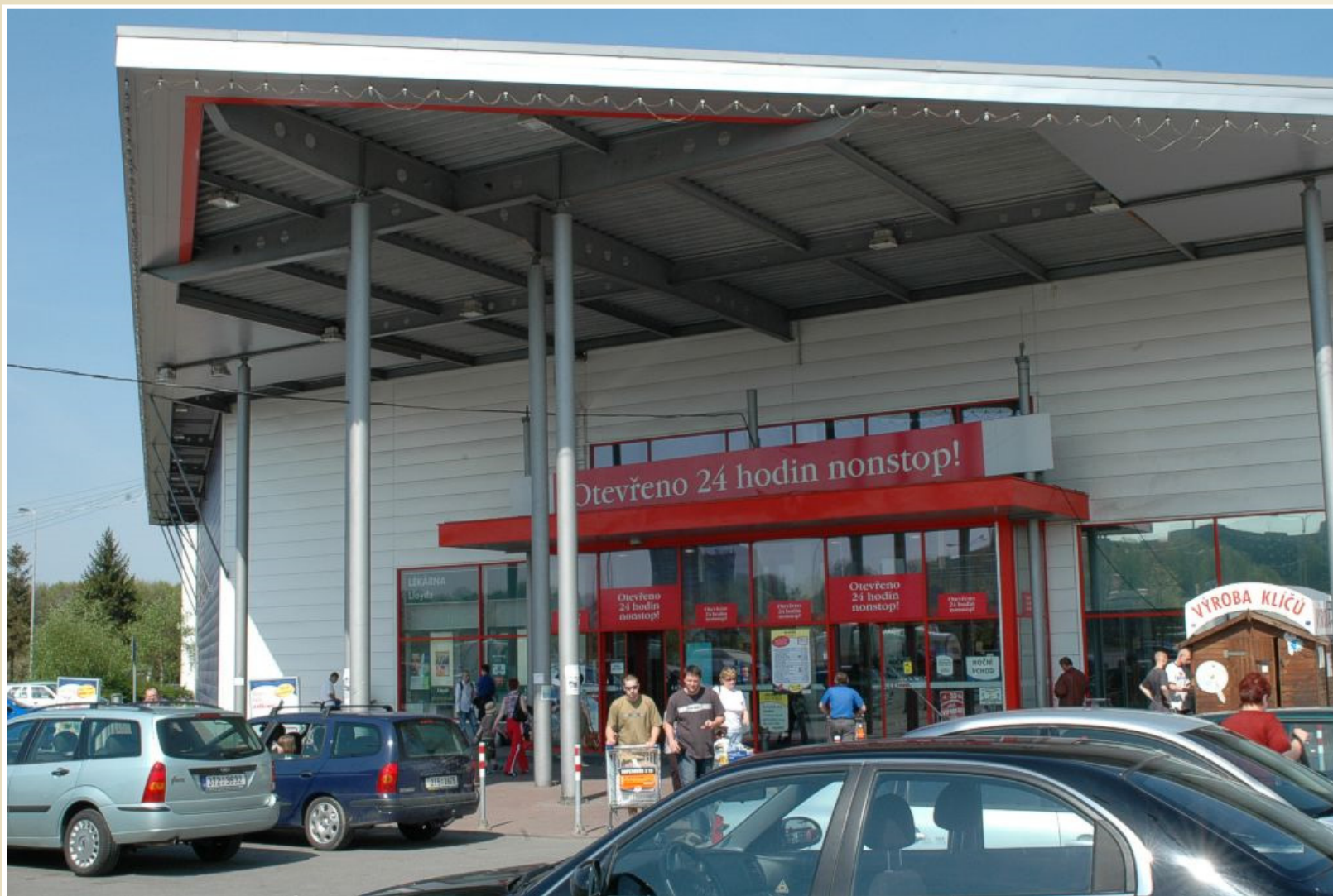
Podpření střešní konstrukce sloupy, Tesco, Ostrava - Třebovice
