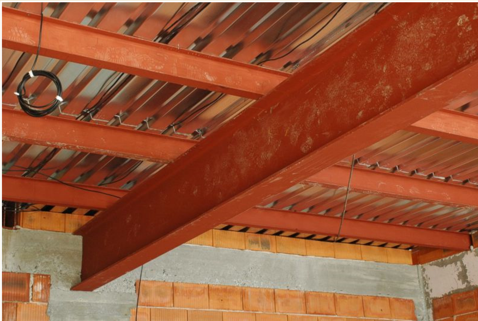
Stropní konstrukce výzkumného energetického centra VŠB-TU Ostrava
