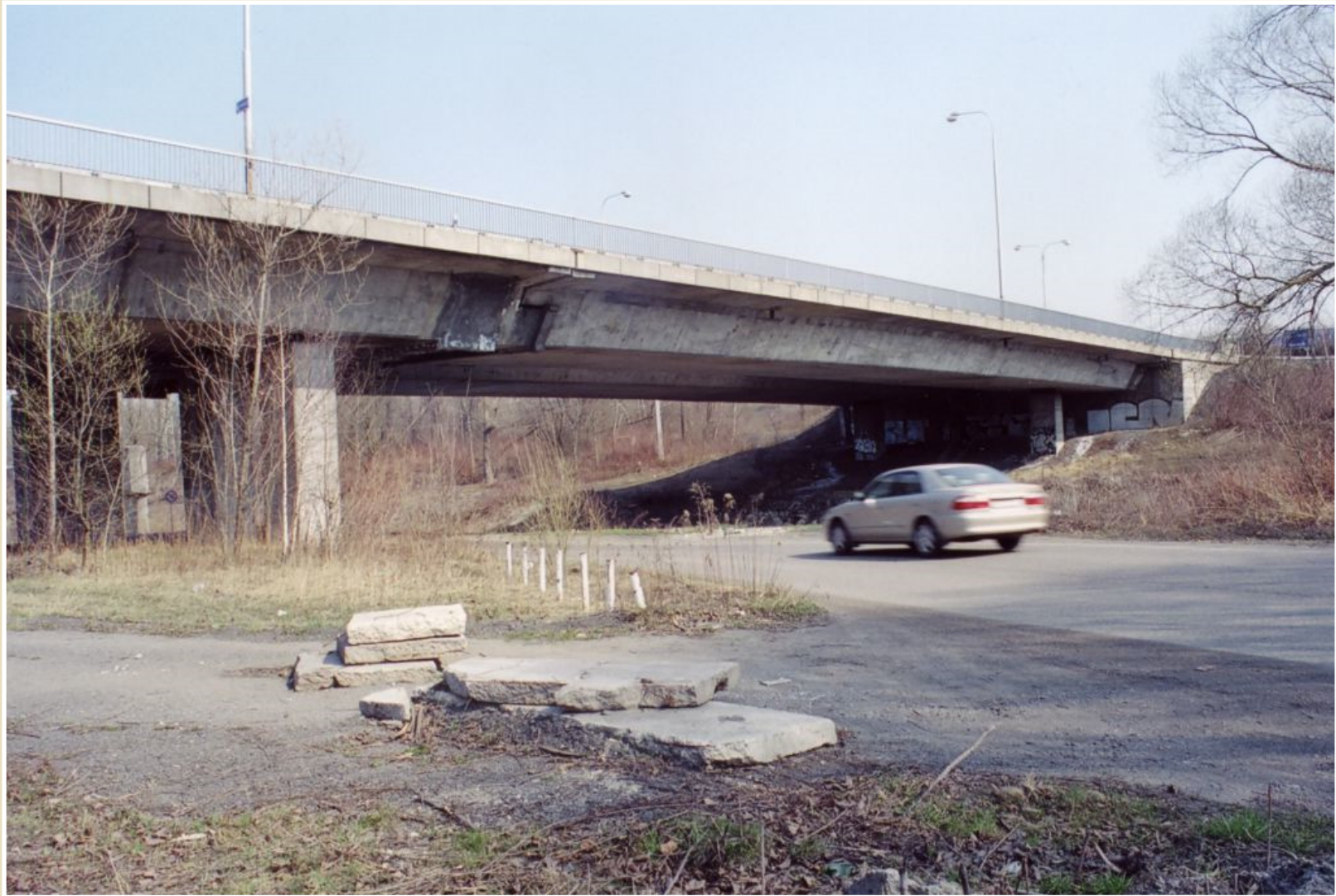
Most přes řeku Ostravici u Výstaviště, Ostrava
