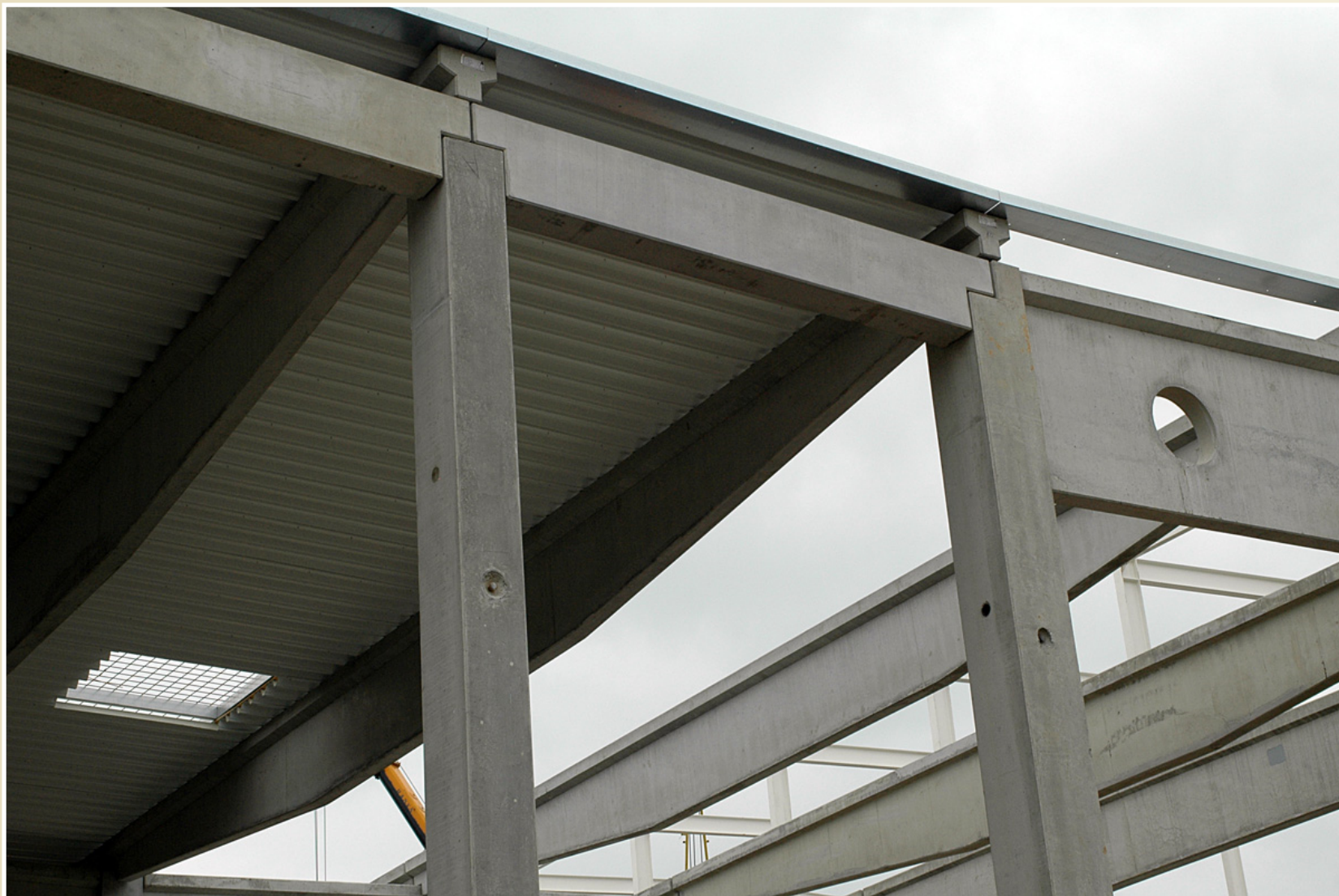
Kloubově uložené nosníky železobetonového skeletu, Albert, Ostrava-Poruba
