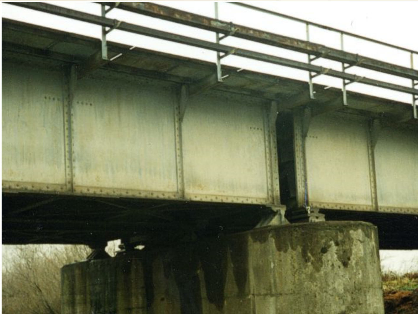
Most přes místní komunikaci na železniční trati Dětmarovice – Petrovice: km 286.258
