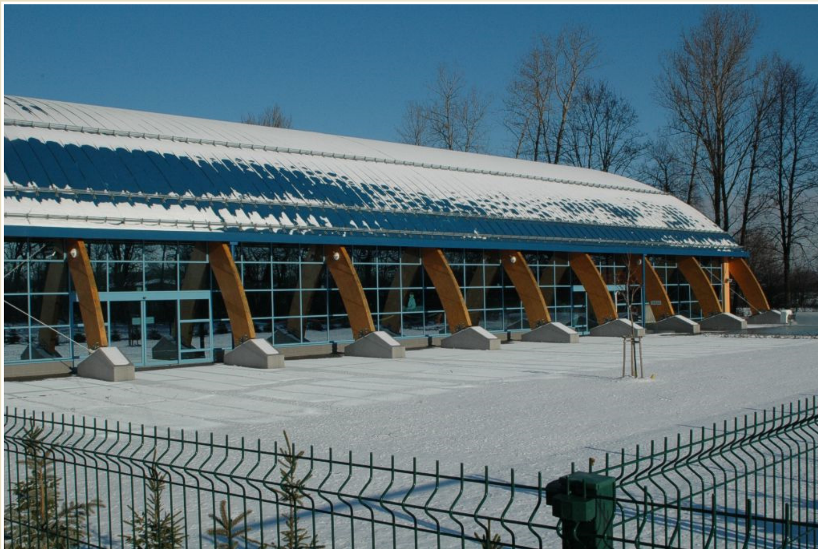
Nosný systém dřevěné konstrukce, Aquapark, Bohumín
