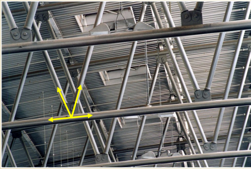
Příhradová konstrukce, Pavilon V z roku 2000, Brněnské výstaviště
