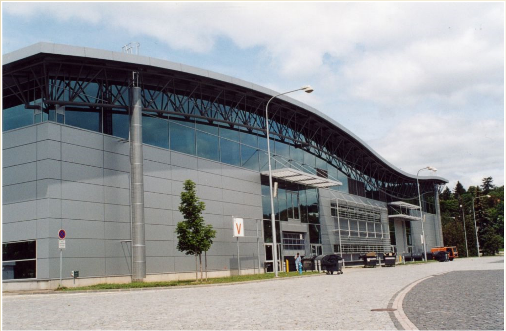
Příhradová konstrukce, Pavilon V z roku 2000, Brněnské výstaviště
