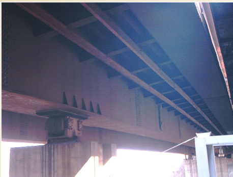
Most přes železniční trať z roku 1980, Ostrava – Svinov, délka 130 m, hmotnost 2.840 t
