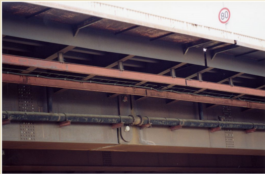
Most přes železniční trať z r. 1980, Ostrava – Svinov, délka 130 m, hmotnost 2.840 t
