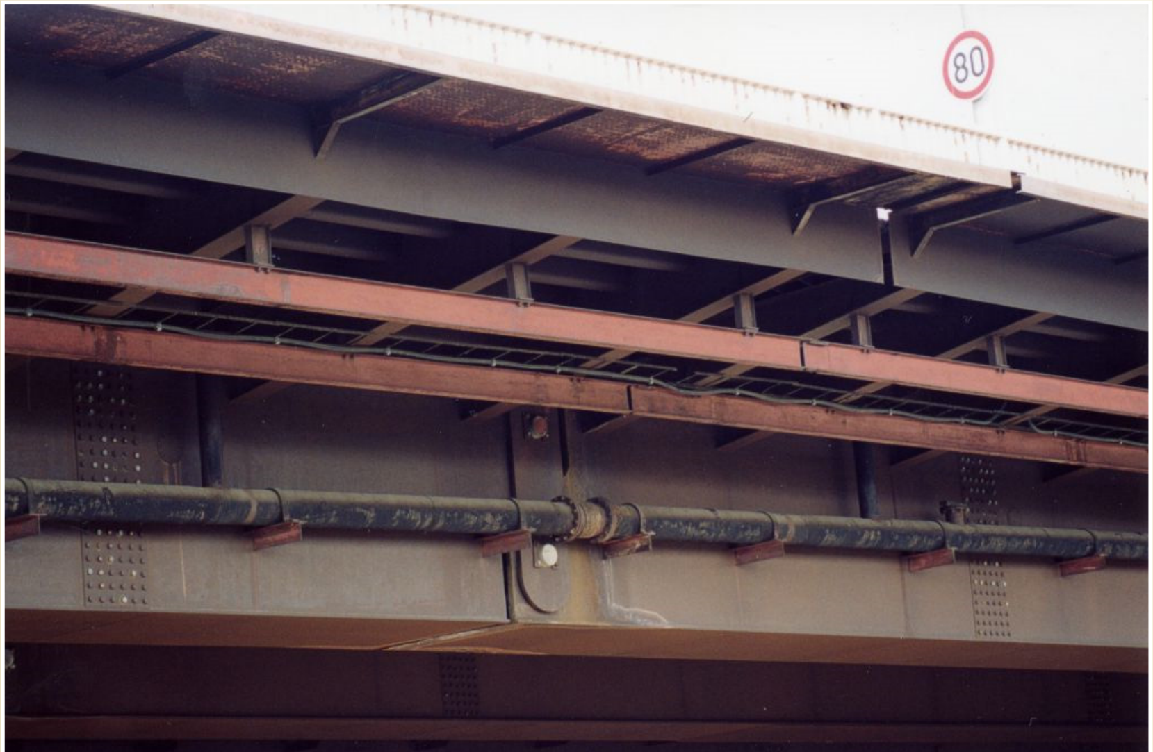
Most přes železniční trať z r. 1980, Ostrava – Svinov, délka 130 m, hmotnost 2.840 t
