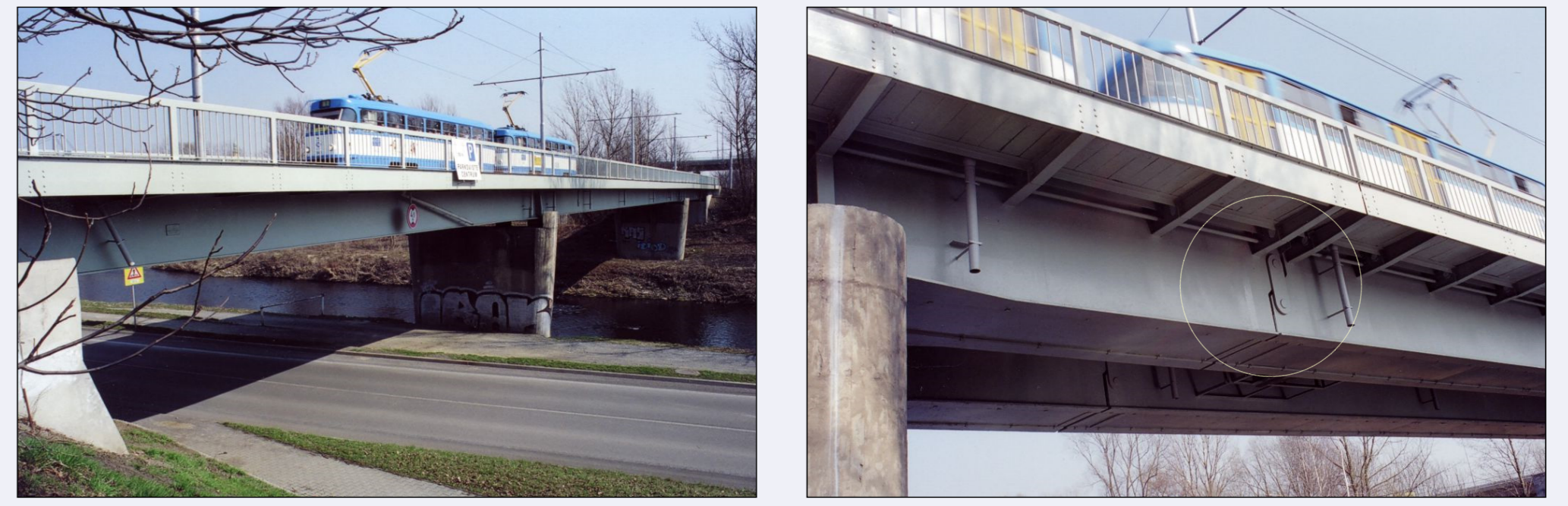
Tramvajový ocelový most přes řeku Ostravici u Vystaviště Černá louka. Detail vnitřní vazby – momentového kloubu
