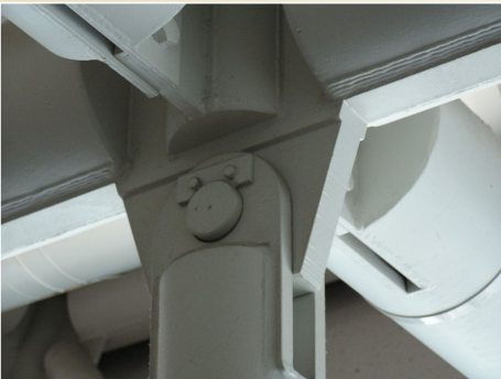
Prostorová příhradová konstrukce letištní haly v Římě, foto: prof. Ing. Alois Materna, CSc., MBA Prostorový svazek sil 18 / 56
