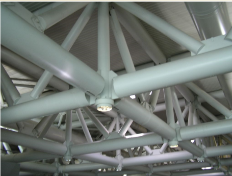
Prostorová příhradová konstrukce letištní haly v Římě, foto: prof. Ing. Alois Materna, CSc., MBA Prostorový svazek sil 14 / 56
