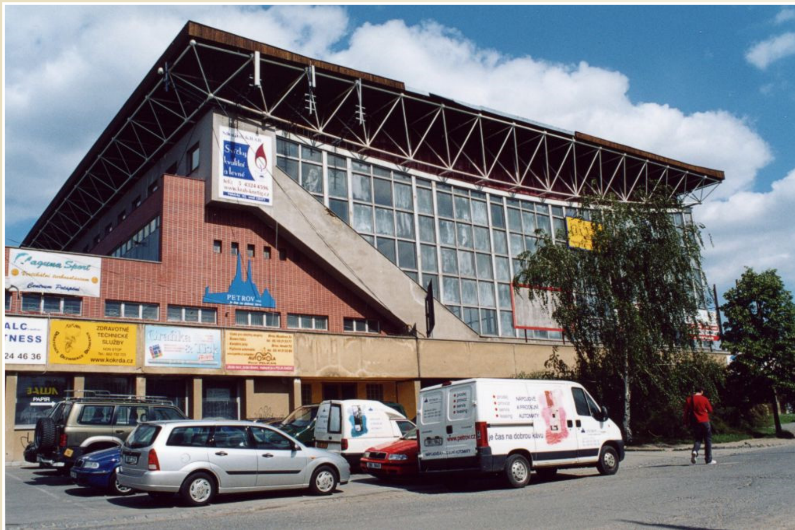
Prostorová příhradová ocelová konstrukce plaveckého stadiónu v Brně, autor nosné konstrukce: Ing. Dr. Ferdinand Lederer
