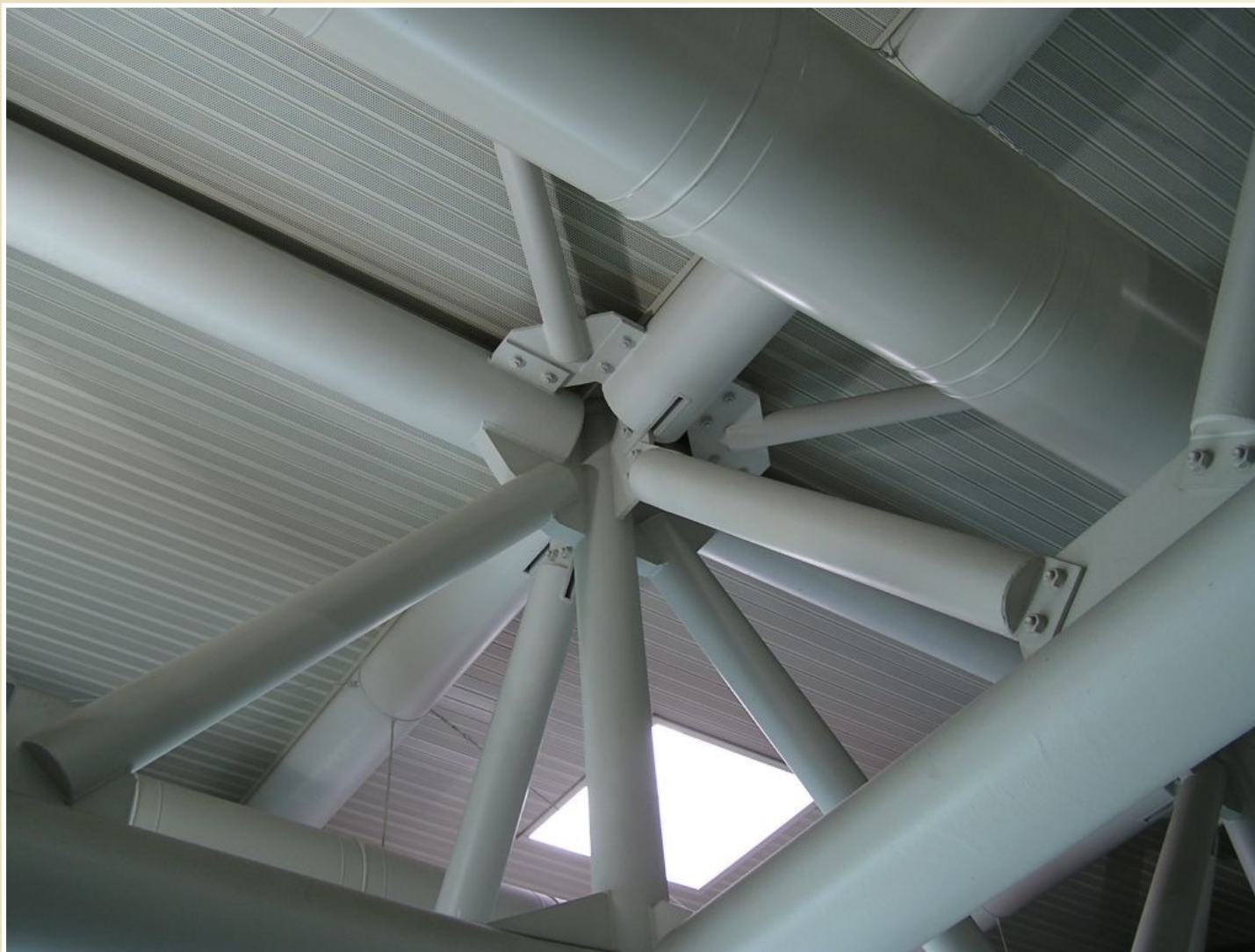
Prostorová příhradová konstrukce letištní haly v Římě, foto: prof. Ing. Alois Materna, CSc., MBA
