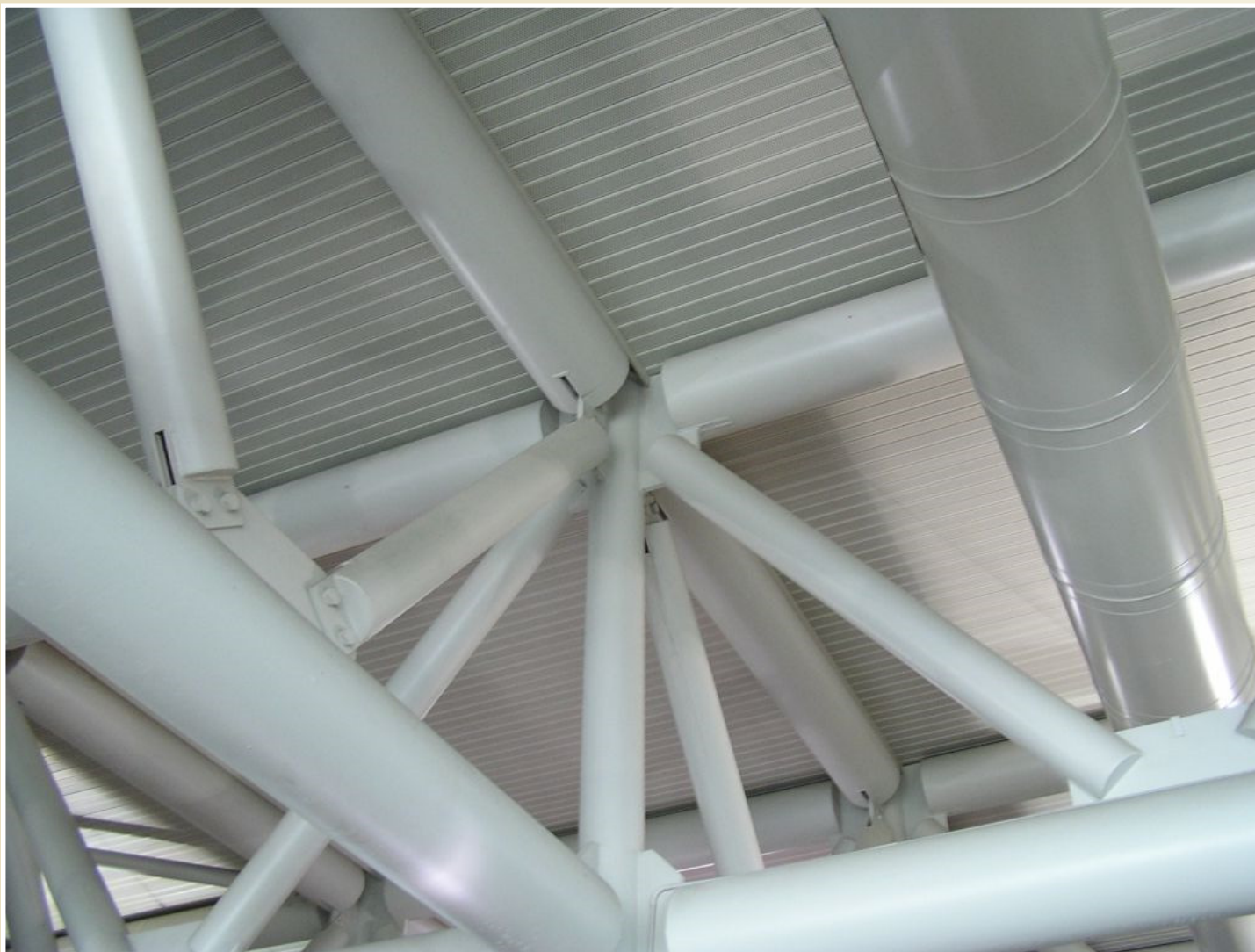
Prostorová příhradová konstrukce letištní haly v Římě, foto: prof. Ing. Alois Materna, CSc., MBA
