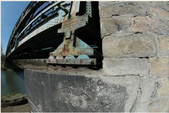
Ukázky kloubových příhradových konstrukcí
