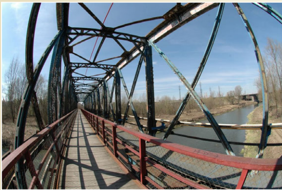
Ukázky kloubových příhradových konstrukcí
