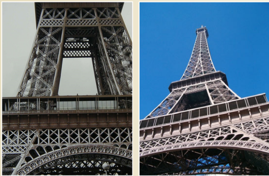
Ocelová výšková konstrukce z roku 1889, výška 324 m, projekt a stavba inženýr Gustav Eiffel
