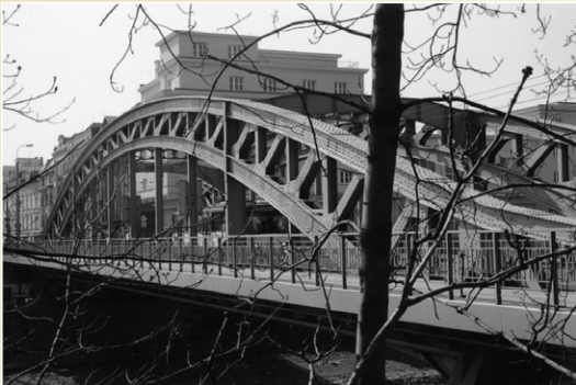
Ocelový příhradový oblouk o rozpětí 60 m a vzepětí 7 m, celková délka 92 m, šířka 16 m, vyrobeno 1913.
