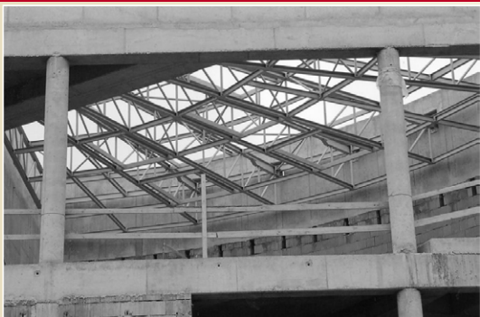
Příhradová konstrukce zastřešení přednáškového sálu
