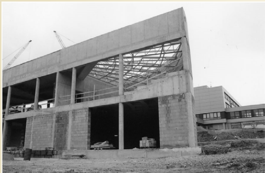
Příhradová konstrukce zastřešení přednáškového sálu
