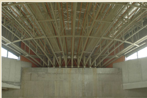
Příhradová konstrukce zastřešení přednáškového sálu
