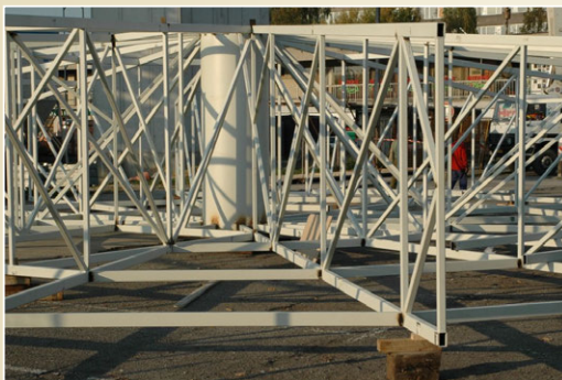
Detail rotačně symetrické příhradové konstrukce střechy
