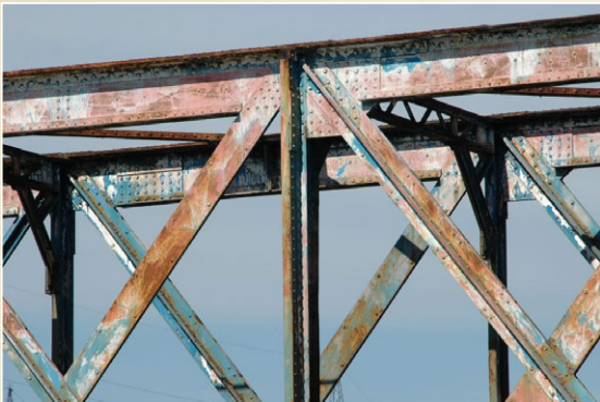
Ukázky kloubových příhradových konstrukcí
