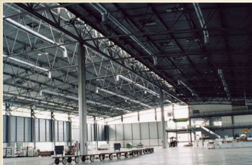
Příhradová konstrukce, Pávilon V z roku 2000, Brněnské výstaviště
