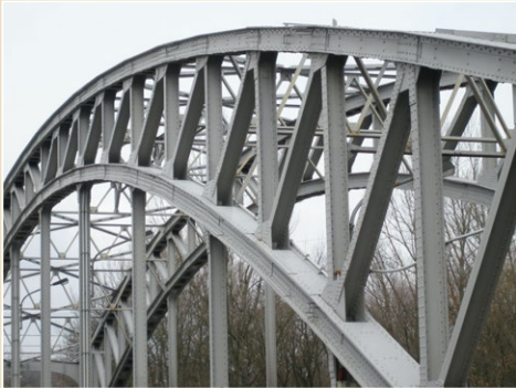
Ocelový příhradový oblouk o rozpětí 50 m, vyrobeno 1929.
