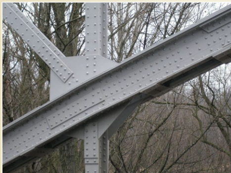
Ocelový příhradový oblouk o rozpětí 50 m, vyrobeno 1929.
