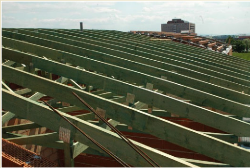
Soustava dřevěných příhradových vazníků konstrukce střechy
