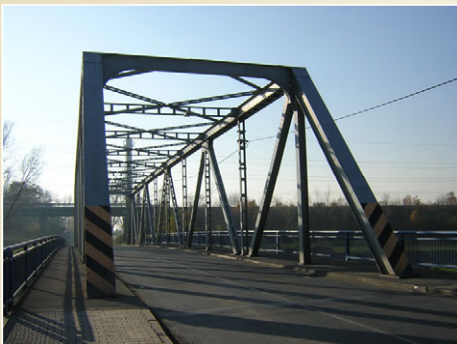
Přihradový most přes řeku Ostravici
