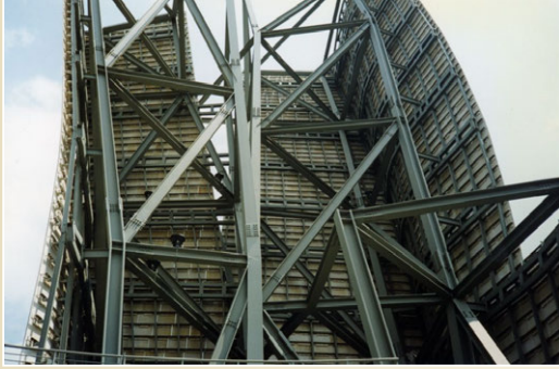
Futurologická ocelová konstrukce z roku 1997, titanové opláštění, výška 50 m, 32 000 m 2 plochy, architekt Frank Gehry
