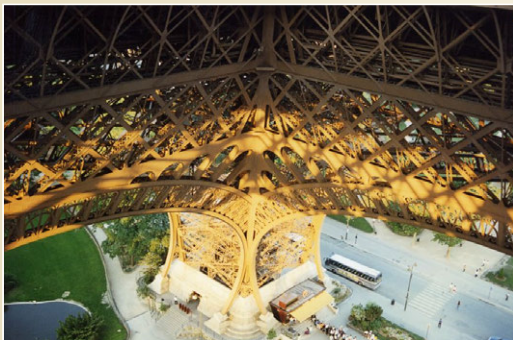
Ocelová výšková konstrukce z roku 1889, výška 324 m, projekt a stavba inženýr Gustav Eiffel
