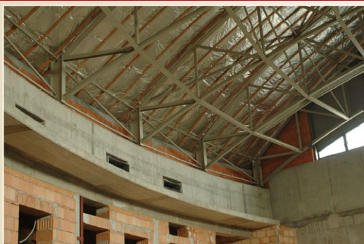
Příhradová konstrukce zastřešení přednáškového sálu
