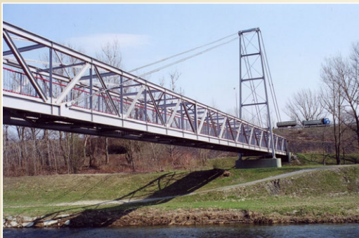
Přihradová lávka přes řeku Ostravici
