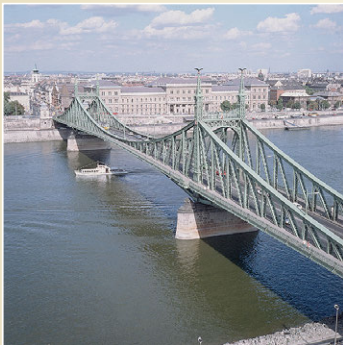
Ocelový příhradový most
