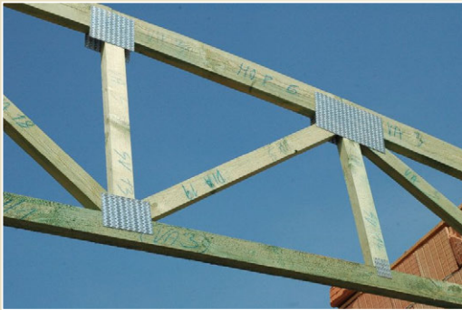
Dřevěný příhradový vazník konstrukce střechy
