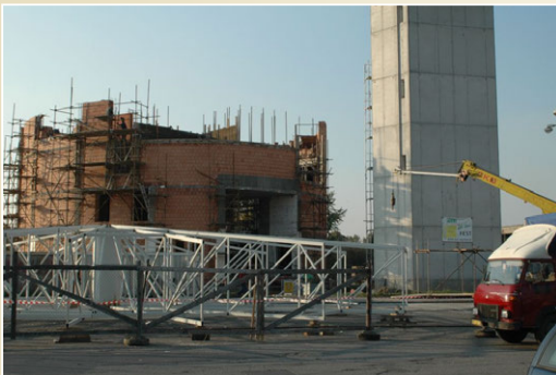
Rotačně symetrická příhradová konstrukce střechy
