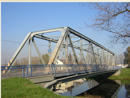
Přihradový most přes řeku Ostravici
