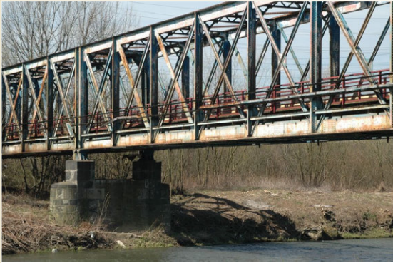
Ukázky kloubových příhradových konstrukcí
