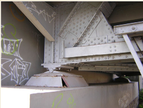
Příhradový most přes řeku Ostravici
