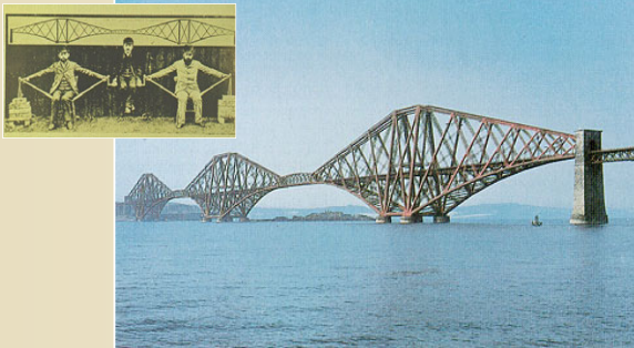
2 466 m dlouhý most z roku 1890, rozpětí nejdelšího pole 521 m. Patent německého inženýra H. Gerbera (průkopník výstavby ocelových mostů druhé poloviny 19. století), projekt a stavba inženýři John Fowler a Benjamin Baker
