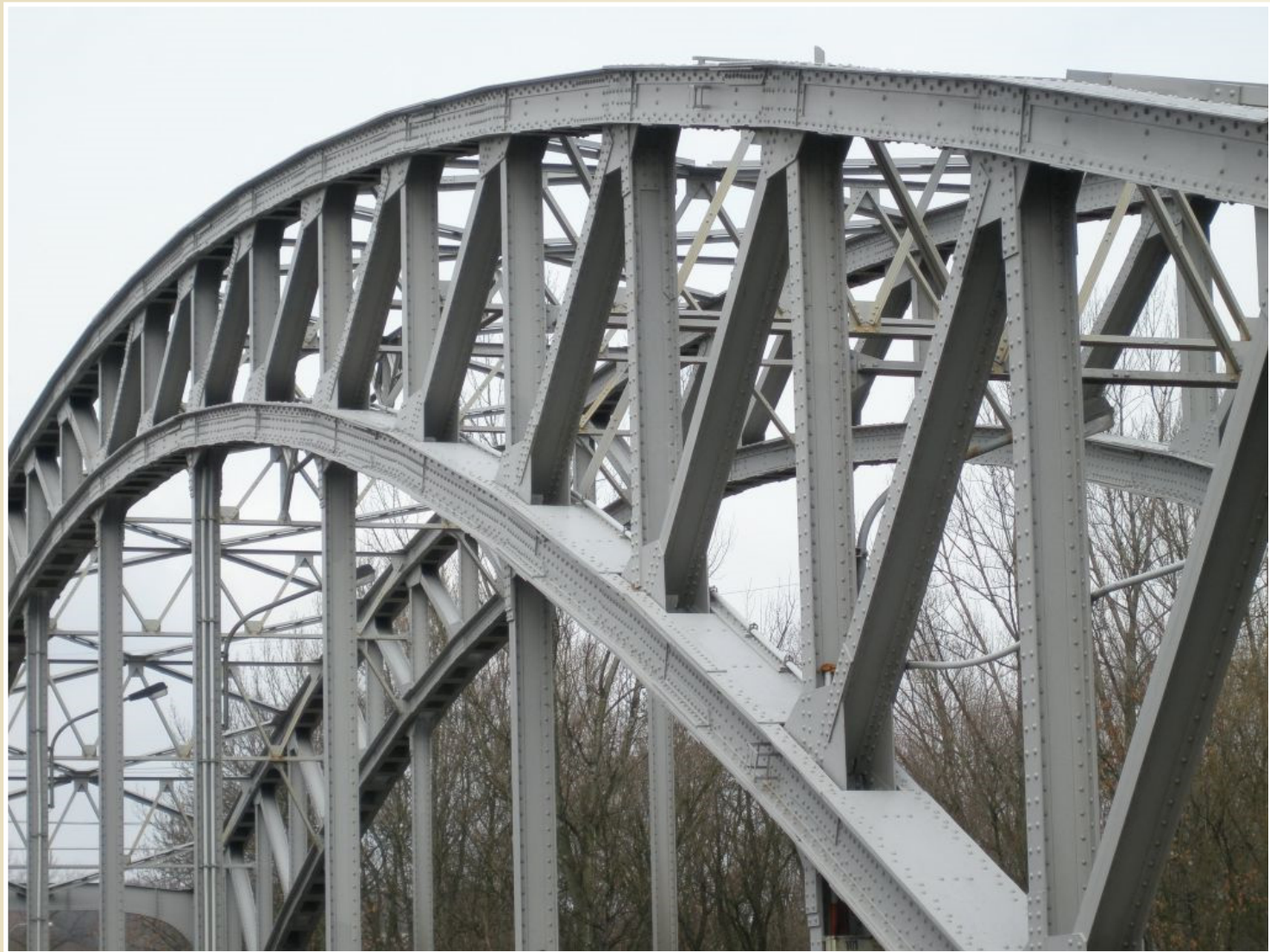
Ocelový příhradový oblouk o rozpětí 50 m, vyrobeno 1929.
