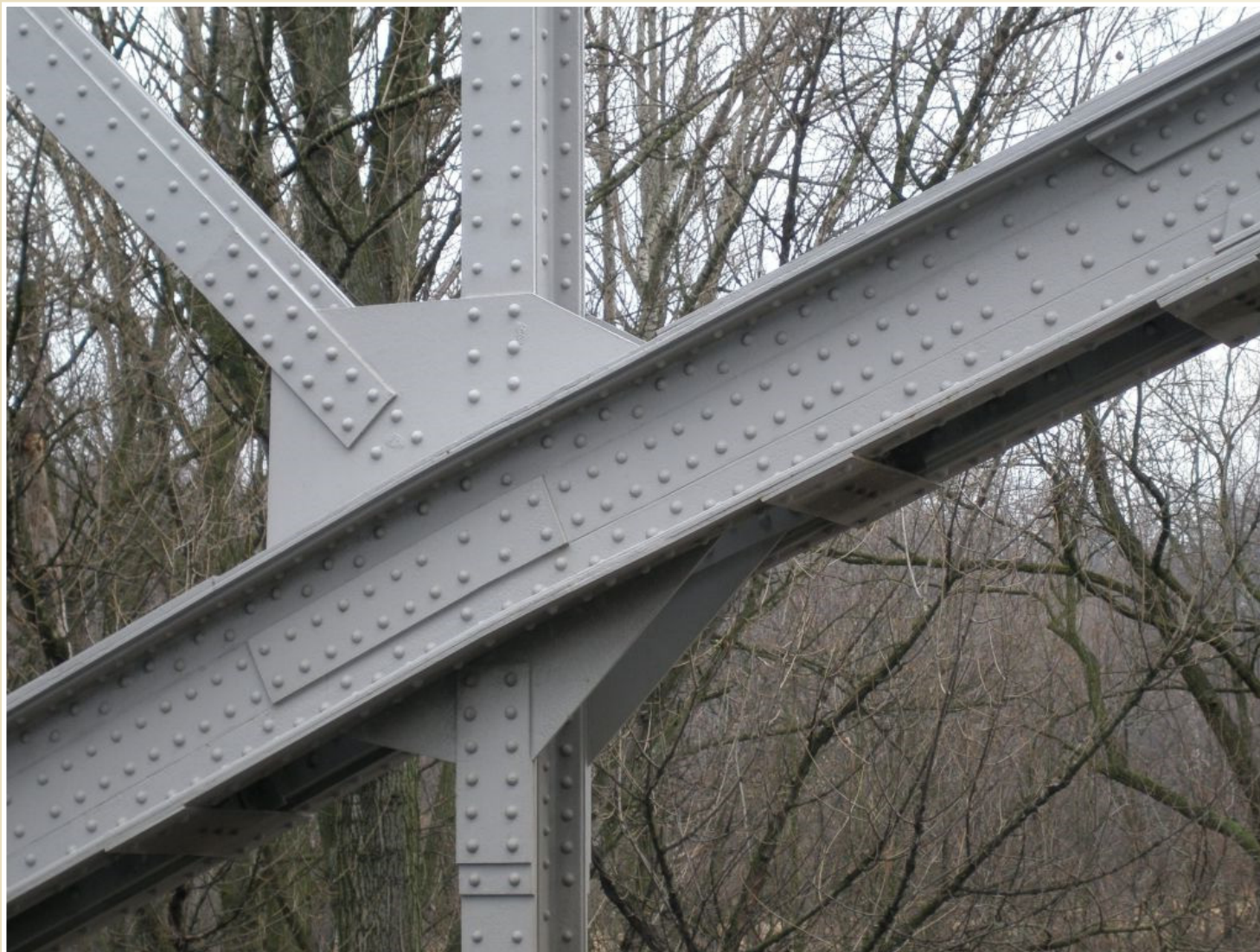
Ocelový příhradový oblouk o rozpětí 50 m, vyrobeno 1929.
