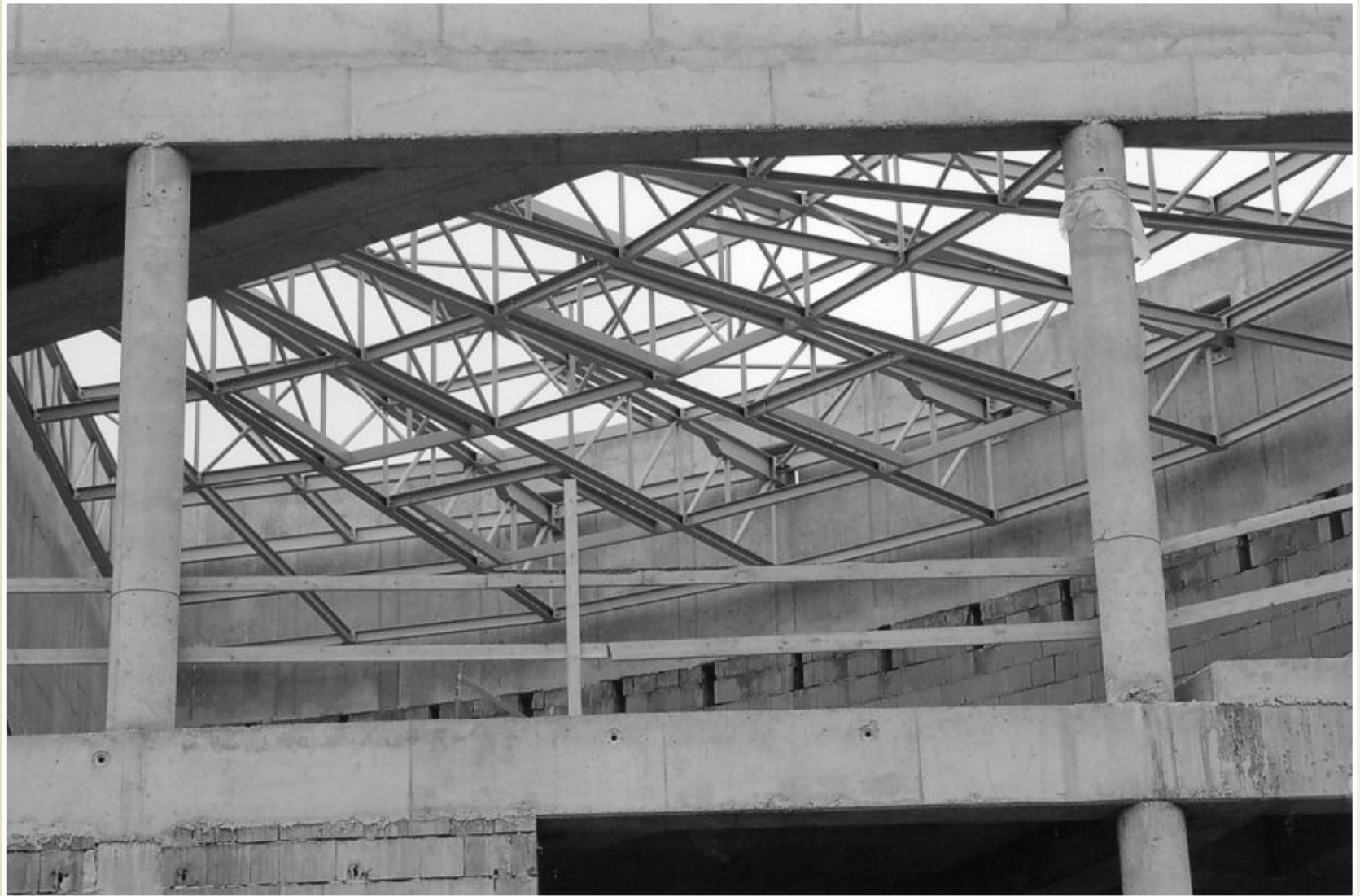
Příhradová konstrukce zastřešení přednáškového sálu
