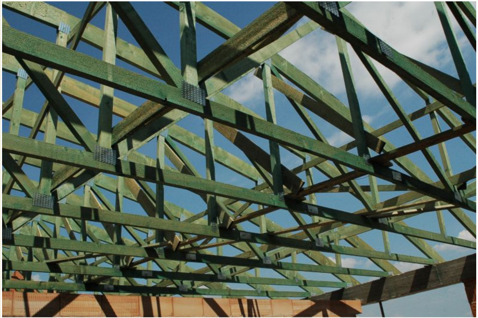
Soustava dřevěných příhradových vazníků konstrukce střechy
