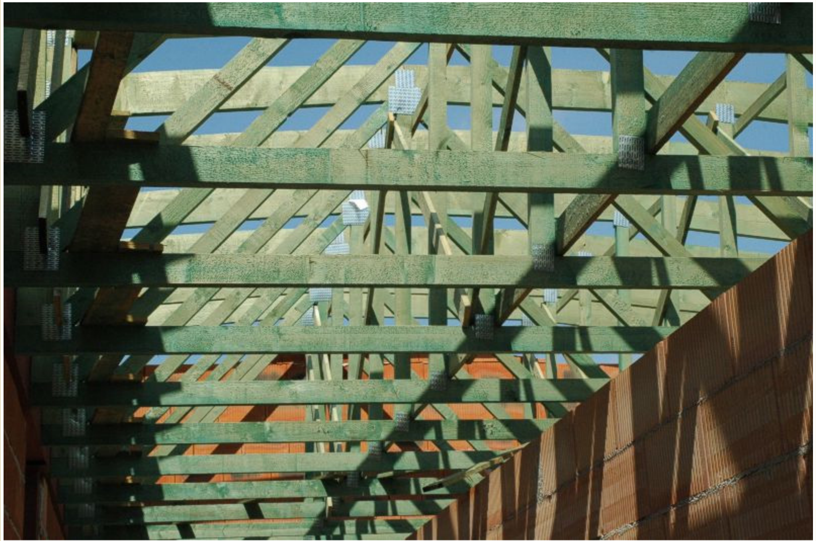
Soustava dřevěných příhradových vazníků konstrukce střechy
