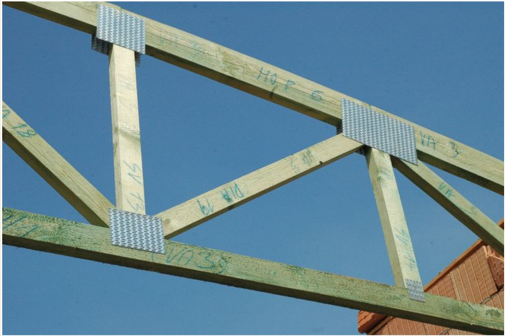
Dřevěný příhradový vazník konstrukce střechy
