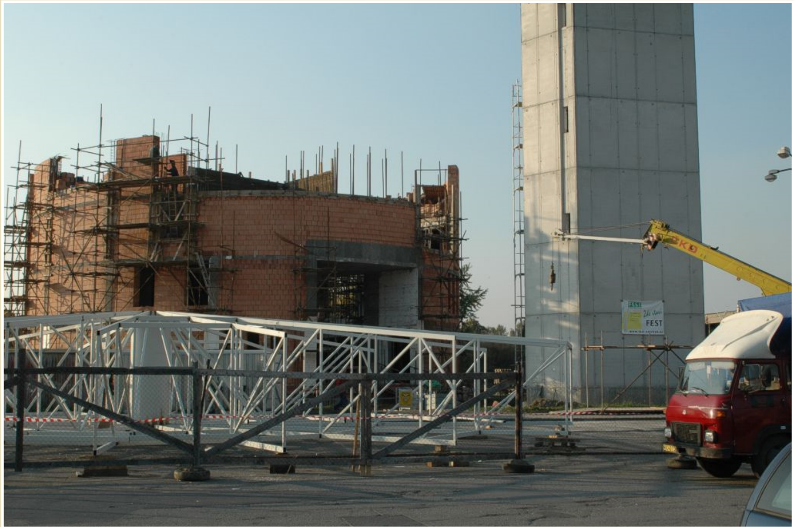
Rotačně symetrická příhradová konstrukce střechy
