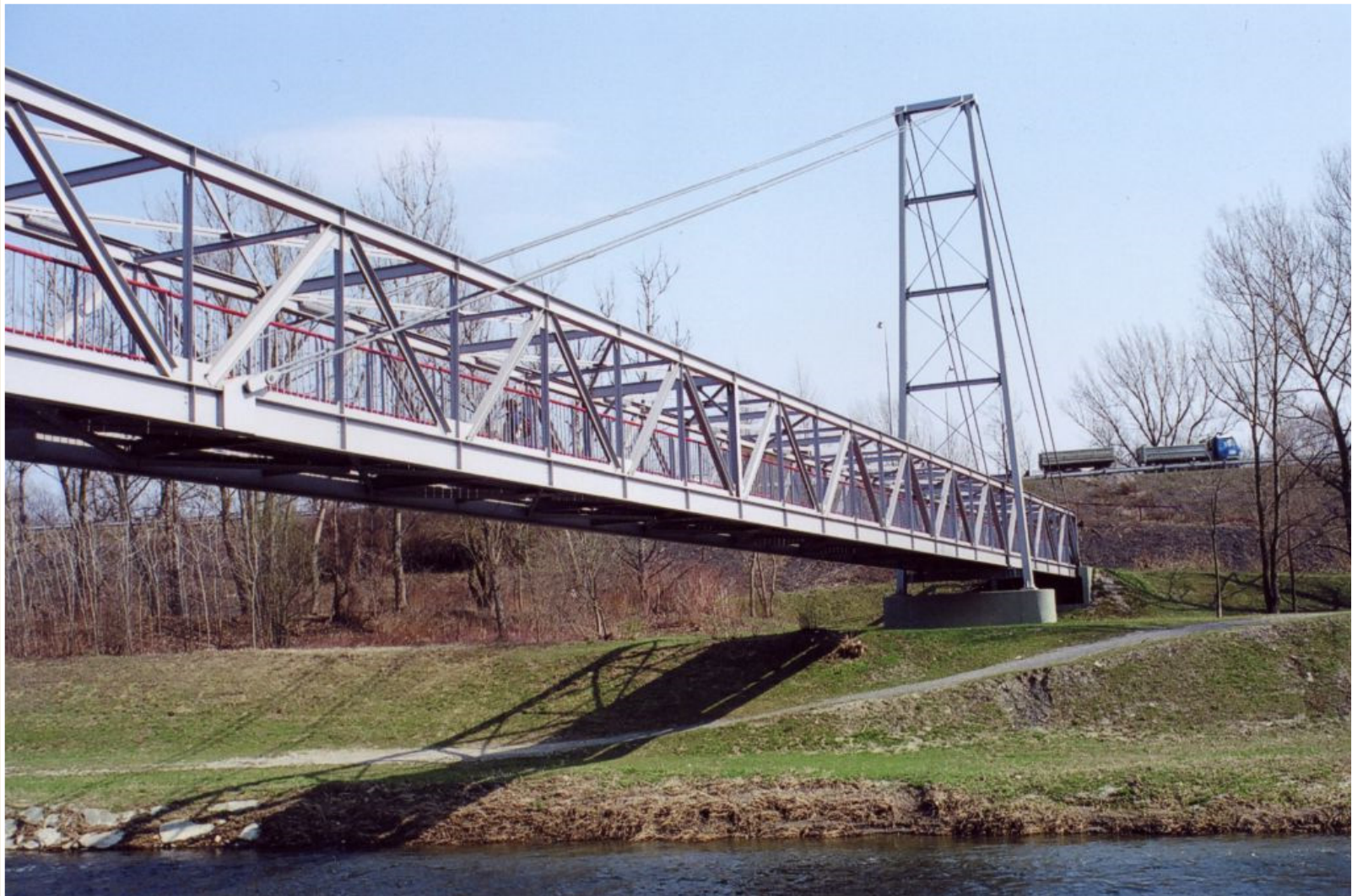
Příhradová lávka přes řeku Ostravici
