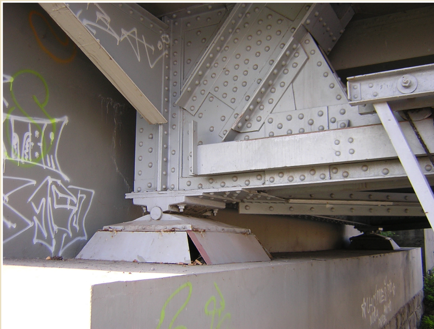
Příhradový most přes řeku Ostravici
