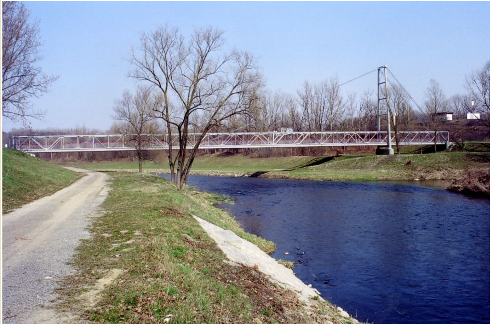
Příhradová lávka přes řeku Ostravici
