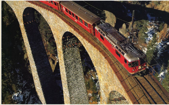
Viadukt u Filisur, výstavba 1901–2, délka 142 m, rozpětí klenby 20 m, výška 65 m, Švýcarsko
