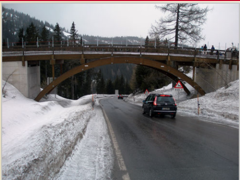
Most z lepeného lamelového dřeva, Katschberg, Rakousko
