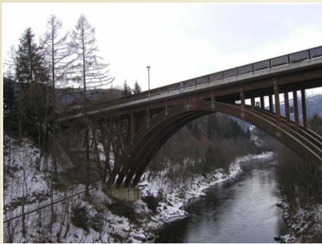
Most z lepeného lamelového dřeva Wennerbruecke přes řeku Mur, St. Georgen, Murau, Rakousko, 4 parabolické trojkloubové oblouky o rozpětí 45 m a vzezpečí 12,5 m, foto: prof. Ing. Antonín Lokaj, Ph.D. Trojkloubový rám a oblouk 86 / 129
