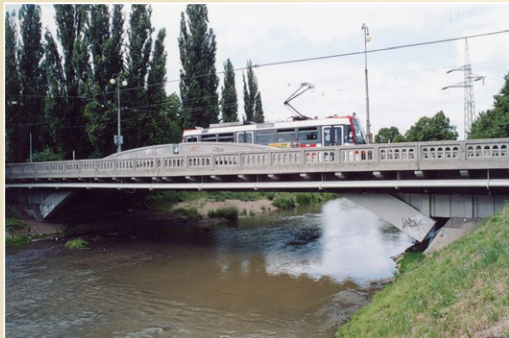
Maloměřický most z roku 1928, 3 oblouky o rozpětí 33 m s průřezem 1 m², mezipřelá mostovka, Brno
