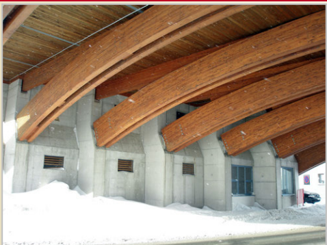
Most z lepeného lamelového dřeva, Obertauern, Rakousko
