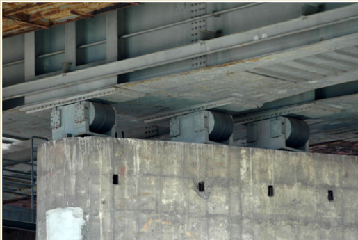
Ocelový most přes řeku Odru z roku 1980, délka 130 m, hmotnost 2.840 t, Ostrava - Svinov Spojitý nosník s vloženými klouby 44 / 129
