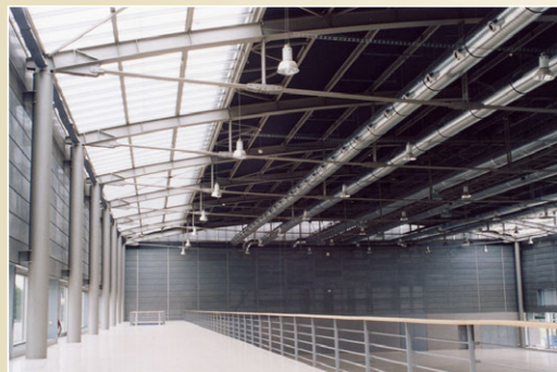
Konstrukce obloukové nosné konstrukce s táhlem, Pavilon G1, Brněnské výstaviště Trojkloubový rám a oblouk s táhlem 117 / 129
