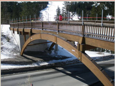
Most z lepeného lamelového dřeva, Katschberg, Rakousko
