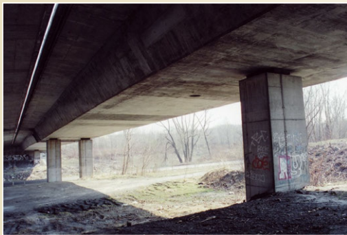
Most přes řeku Ostravici, 2 pole, 1 vnitřní kloub, oboustranný převislý konec, Černá louka, Ostrava
