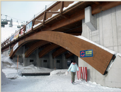
Most z lepeného lamelového dřeva, Obertauern, Rakousko Trojkloubový rám a oblouk
