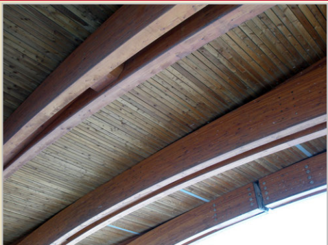
Most z lepeného lamelového dřeva, Obertauern, Rakousko
