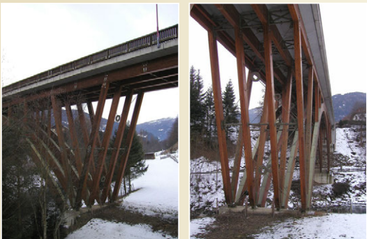
Most z lepeného lamelového dřeva Wennerbruecke přes řeku Mur, St. Georgen, Murau, Rakousko, 4 parabolické trojkloubové oblouky o rozpětí 45 m a vzezpečí 12,5 m, foto: prof. Ing. Antonín Lokaj, Ph.D. Trojkloubový rám a oblouk 87 / 129
