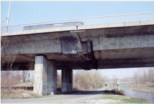
Most přes řeku Ostravici, 2 pole, 1 vnitřní kloub, oboustranný převislý konec, Černá louka, Ostrava Spojitý nosník s vloženými klouby 47 / 129
