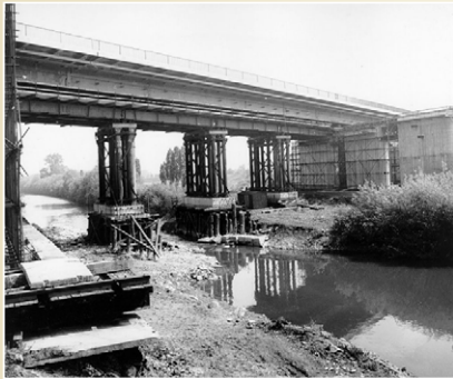
Ocelový most přes řeku Odru z roku 1980, délka 130 m, hmotnost 2.840 t, Ostrava - Svinov
