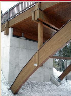
Most z lepeného lamelového dřeva, Katschberg, Rakousko
