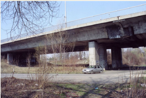
Most přes řeku Ostravici, 2 pole, 1 vnitřní kloub, oboustranný převislý konec, Černá louka, Ostrava Spojitý nosník s vloženými klouby 48 / 129
