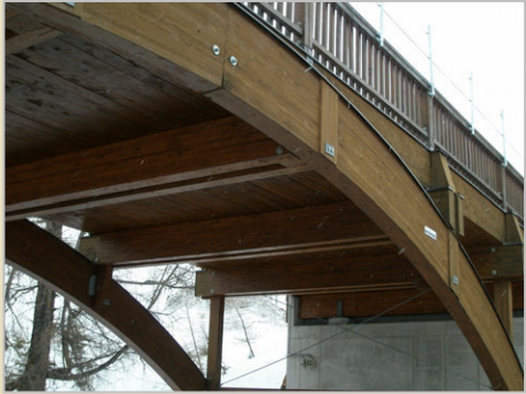
Most z lepeného lamelového dřeva, Katschberg, Rakousko
