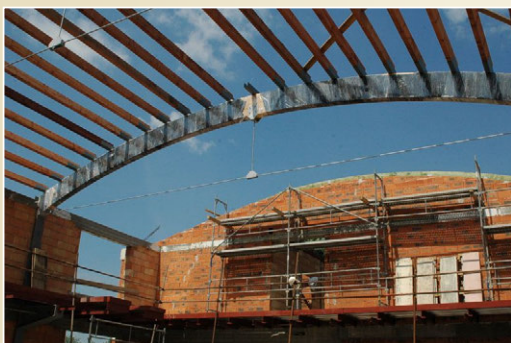
Konstrukce obloukové nosné konstrukce s táklem, výzkumné energetické centrum VŠB-TU Ostrava
