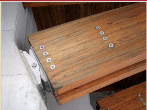
Most z lepeného lamelového dřeva, Obertauern, Rakousko
