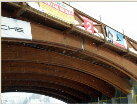
Most z lepeného lamelového dřeva, Obertauern, Rakousko Trojkloubový rám a oblouk
