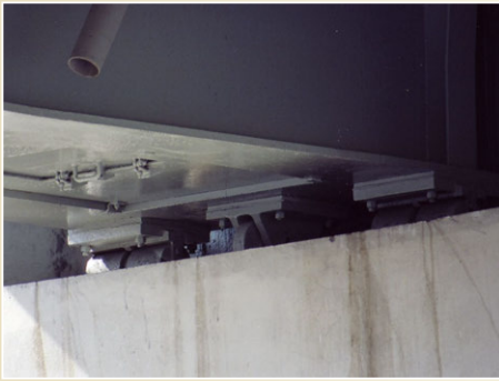
Most přes řeku Ostravici, detail uložení, Černá louka, Ostrava
