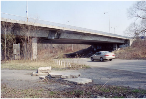
Most přes řeku Ostravici, 2 pole, 1 vnitřní kloub, oboustranný převislý konec, Černá louka, Ostrava Spojitý nosník s vloženými klouby 46 / 129
