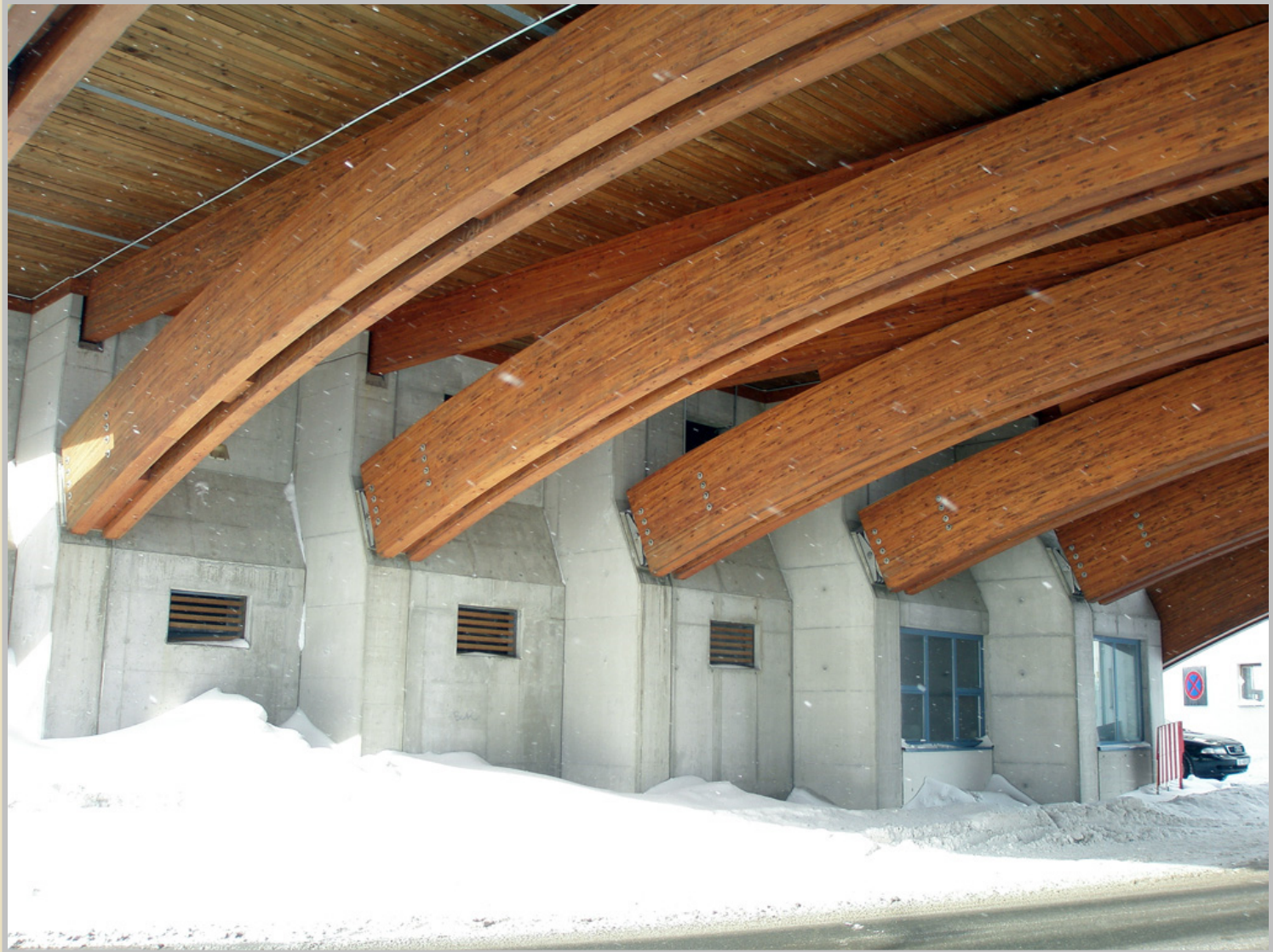
Most z lepeného lamelového dřeva, Obertauern, Rakousko
