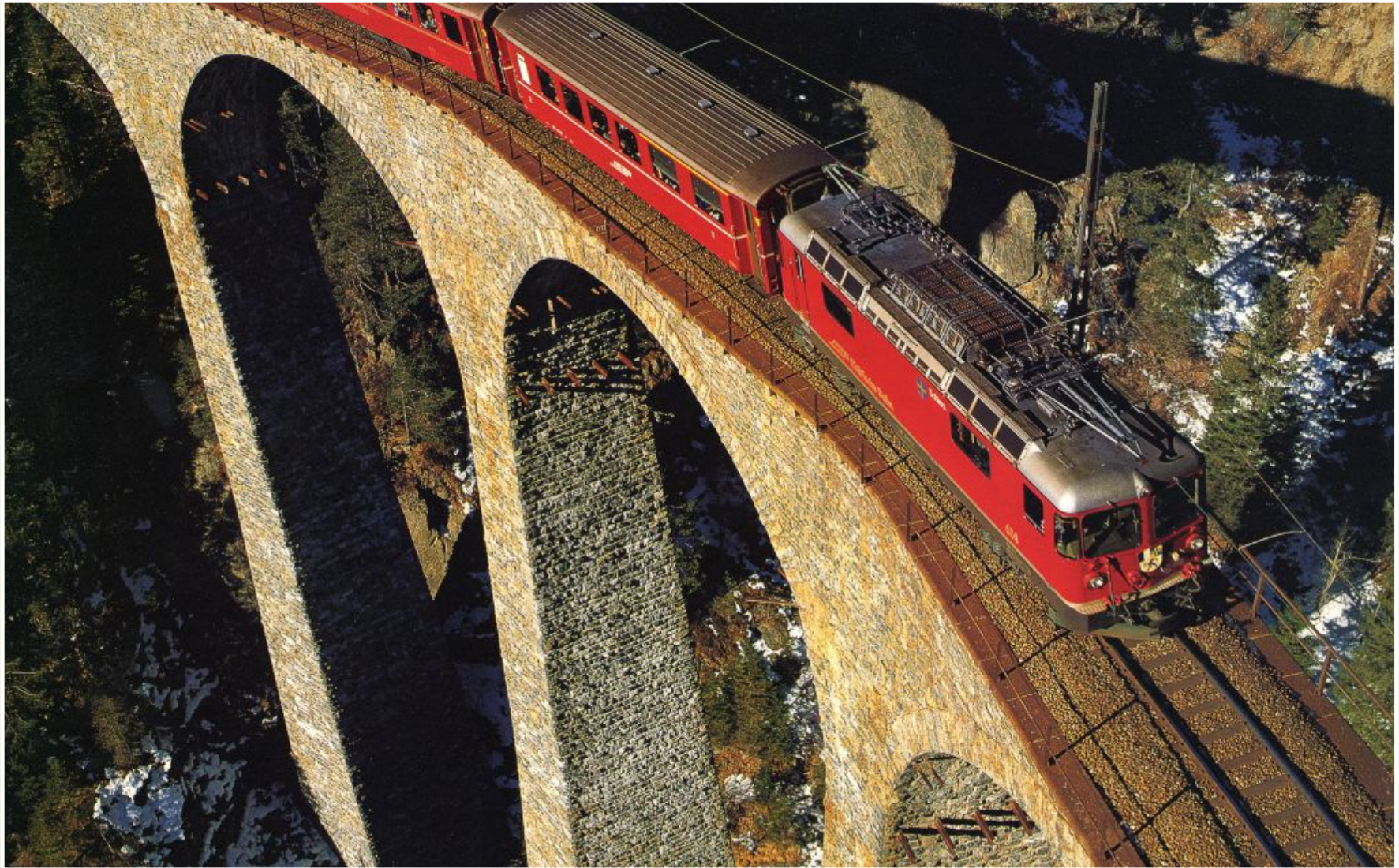
Viadukt u Filisur, výstavba 1901–2, délka 142 m, rozpětí klenby 20 m, výška 65 m, Švýcarsko
