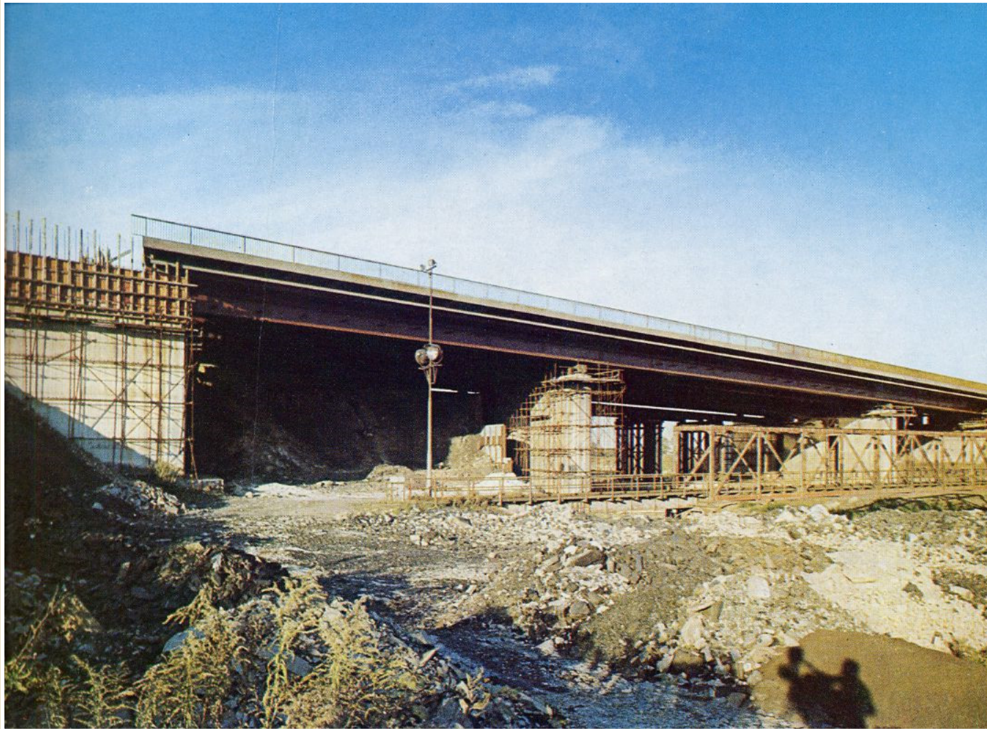
Ocelový most přes řeku Odru z roku 1980, délka 130 m, hmotnost 2.840 t, Ostrava - Svinov
