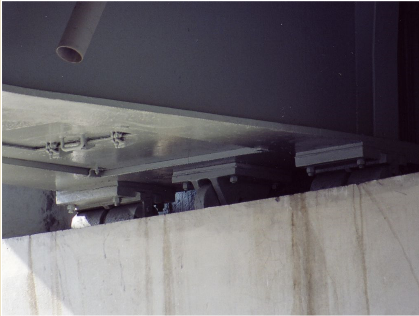
Most přes řeku Ostravici, detail uložení, Černá louka, Ostrava
