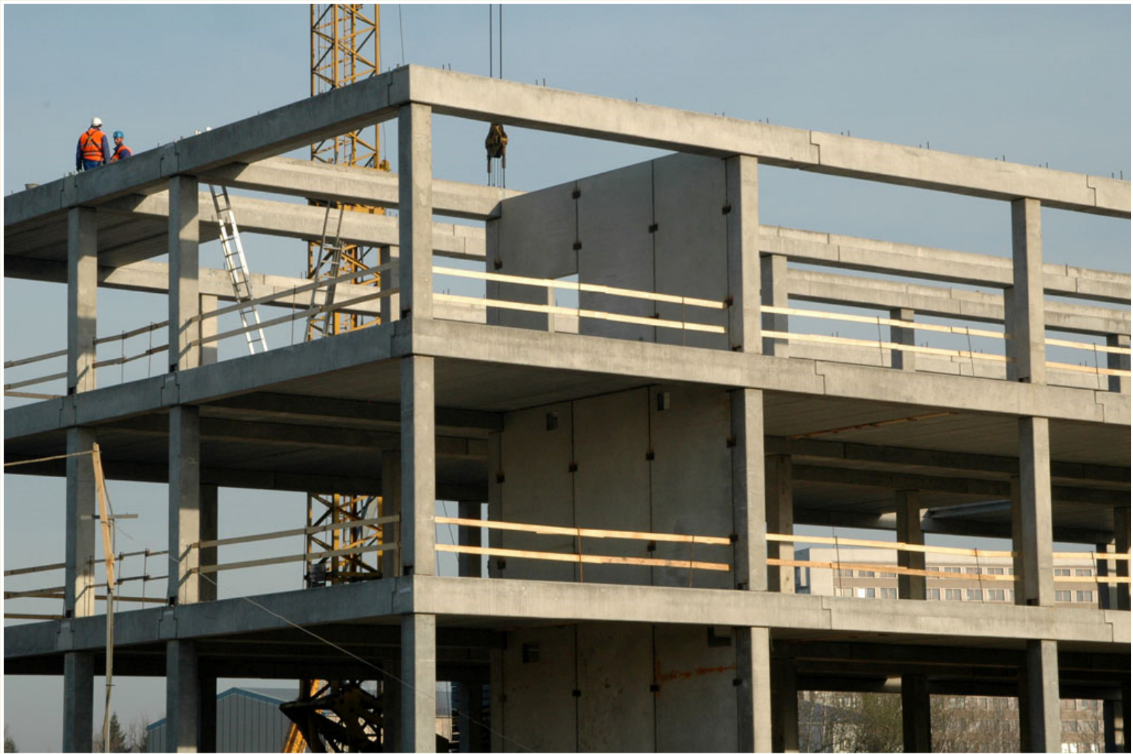
Centrum pokročilých technologií, VŠB-TU Ostrava, realizace 2007
