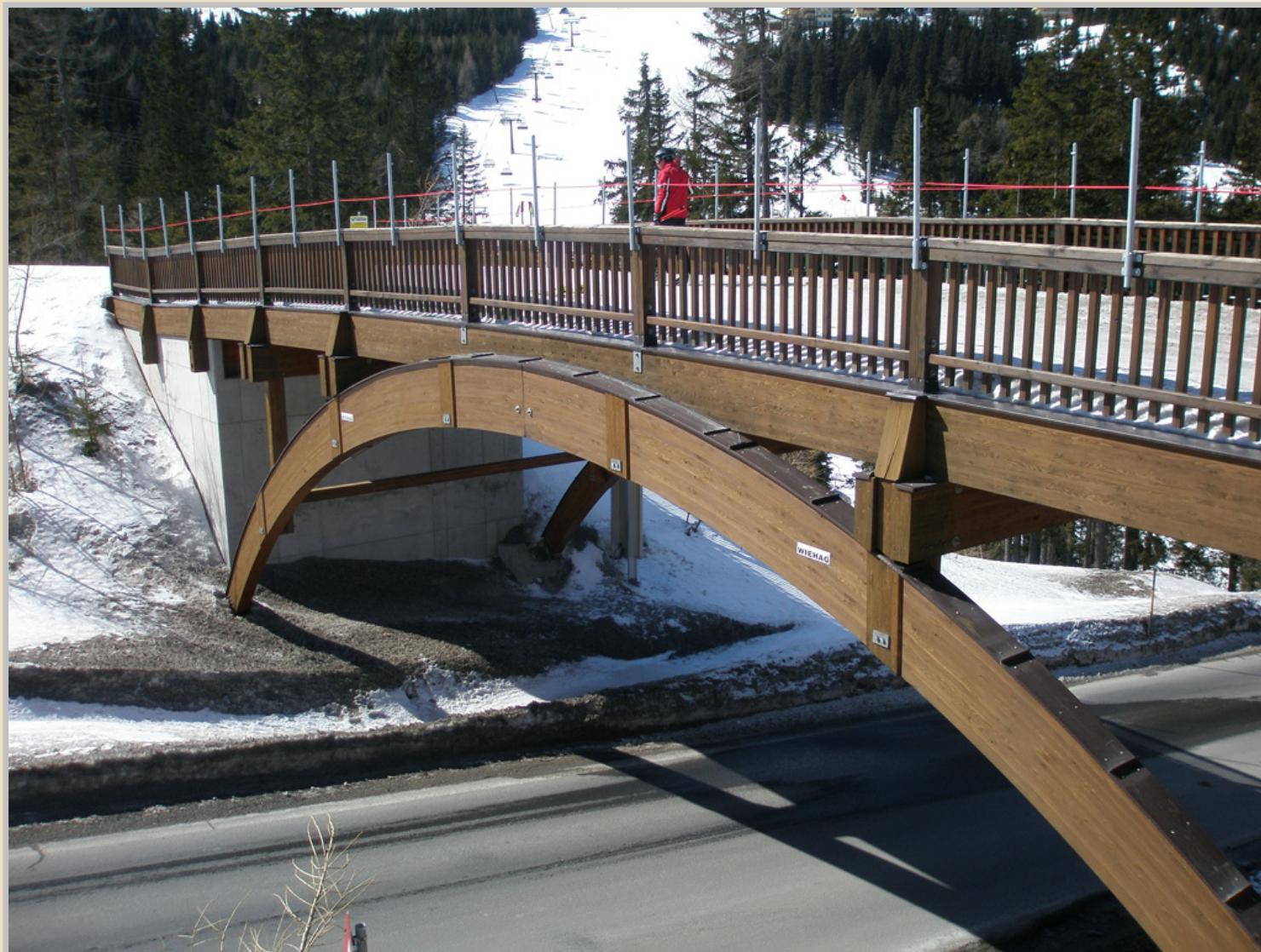
Most z lepeného lamelového dřeva, Katschberg, Rakousko
