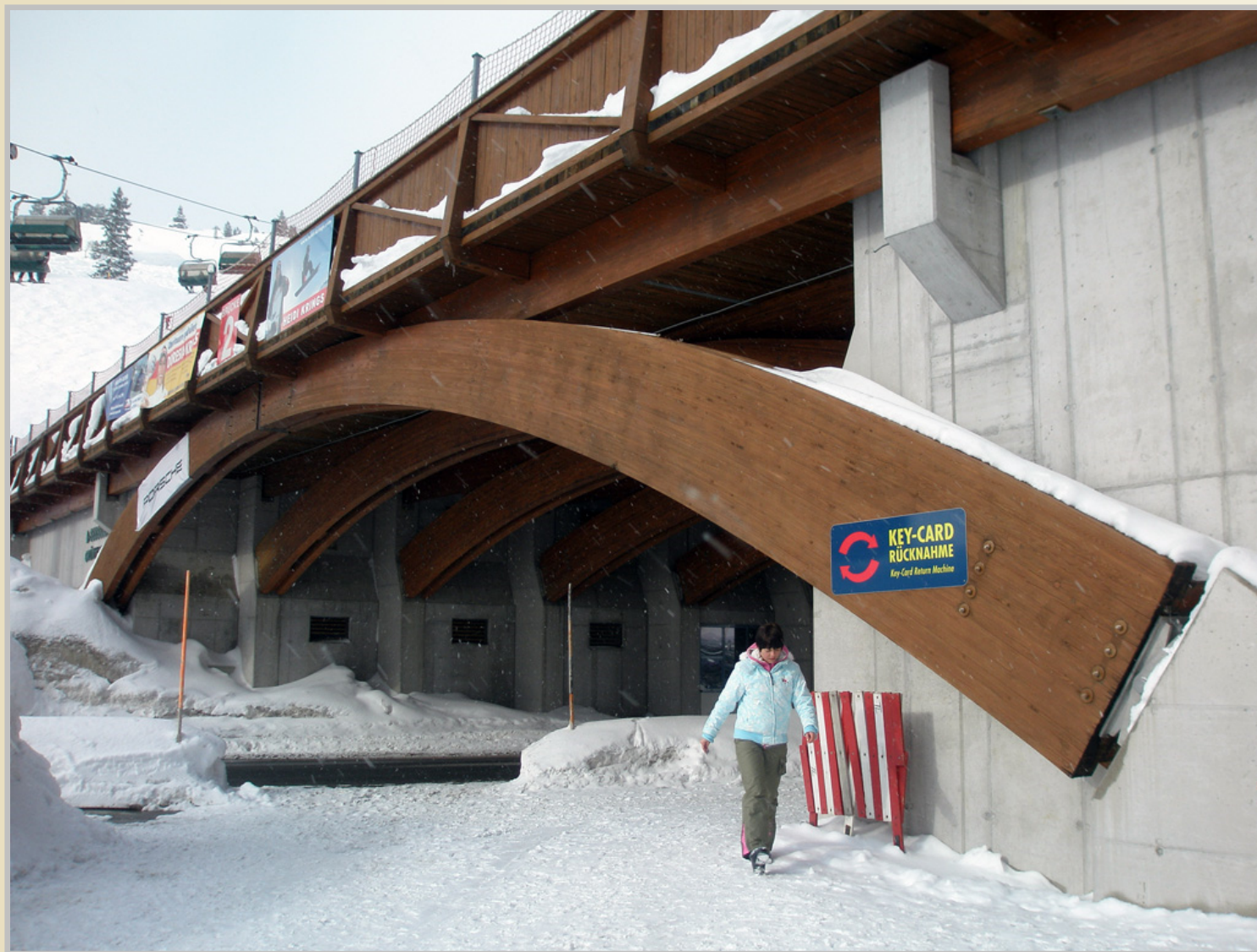
Most z lepeného lamelového dřeva, Obertauern, Rakousko
