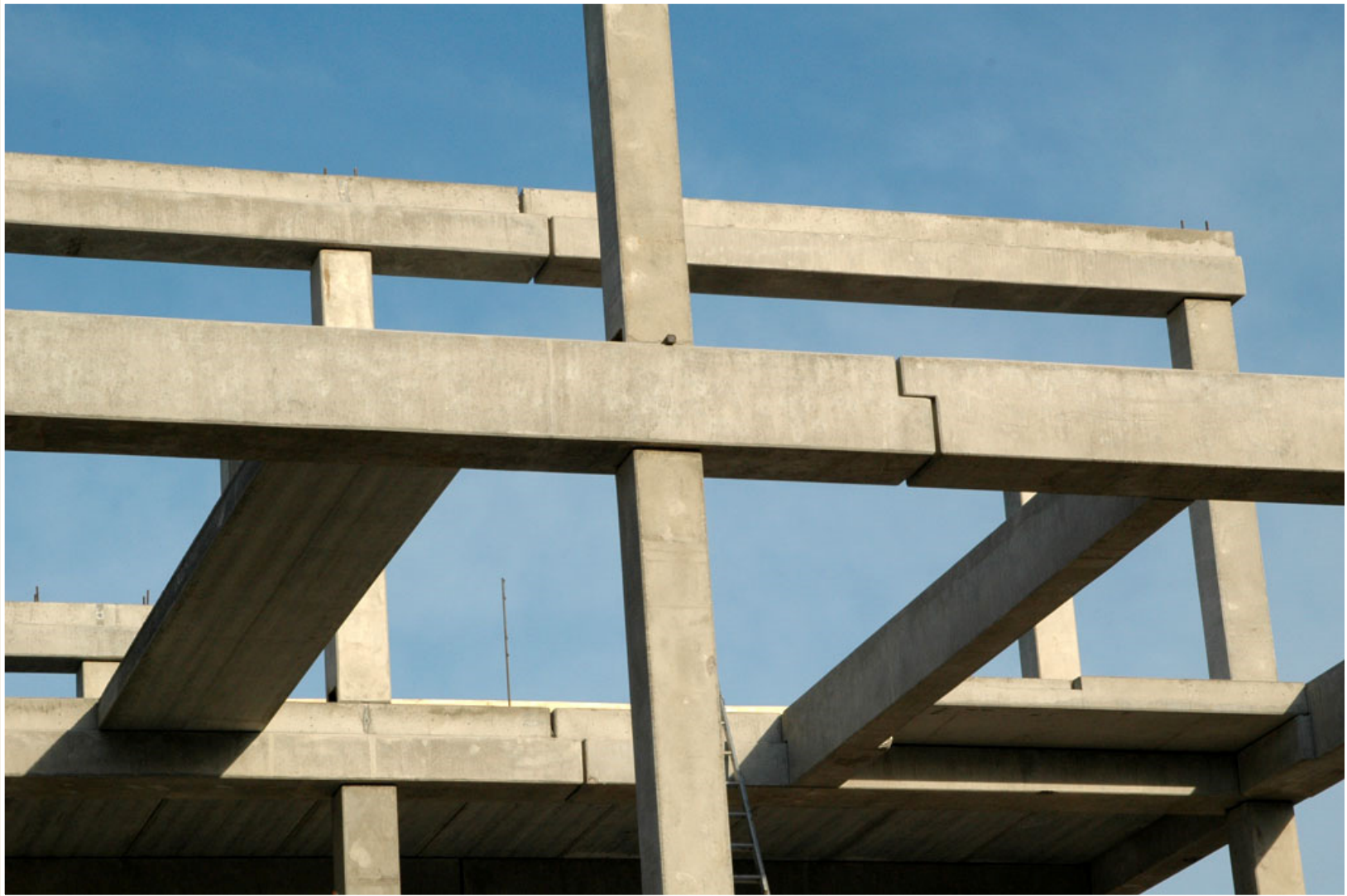
Centrum pokročilých technologií, VŠB-TU Ostrava, realizace 2007
