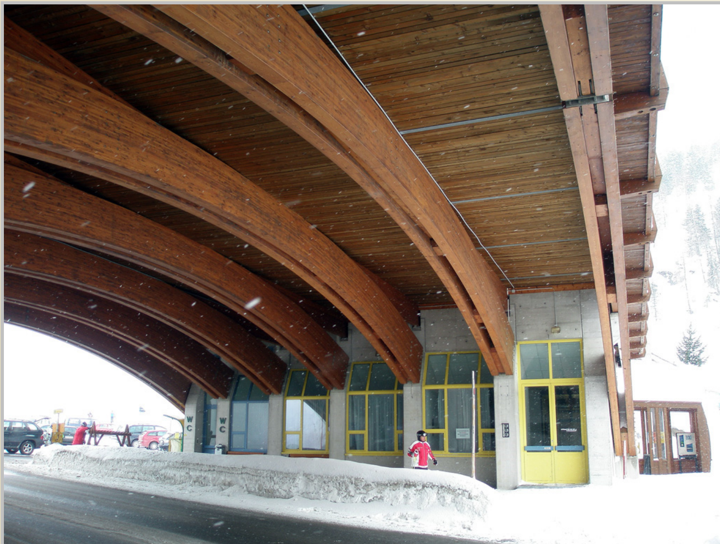
Most z lepeného lamelového dřeva, Obertauern, Rakousko
