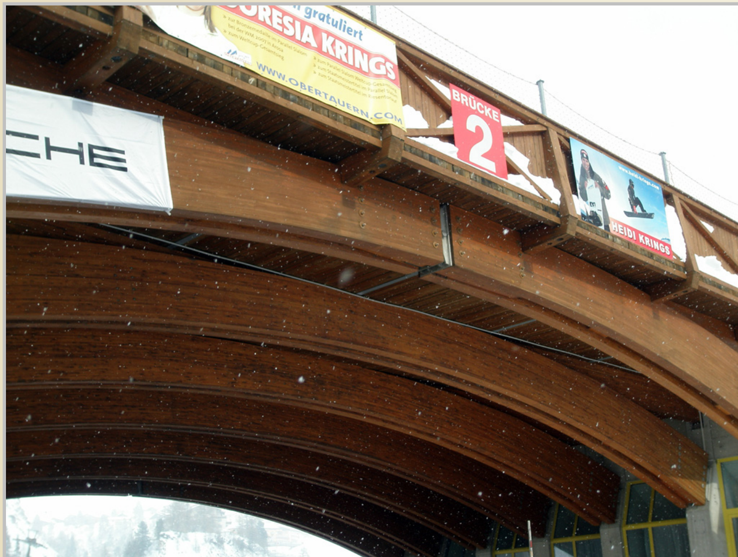
Most z lepeného lamelového dřeva, Obertauern, Rakousko
