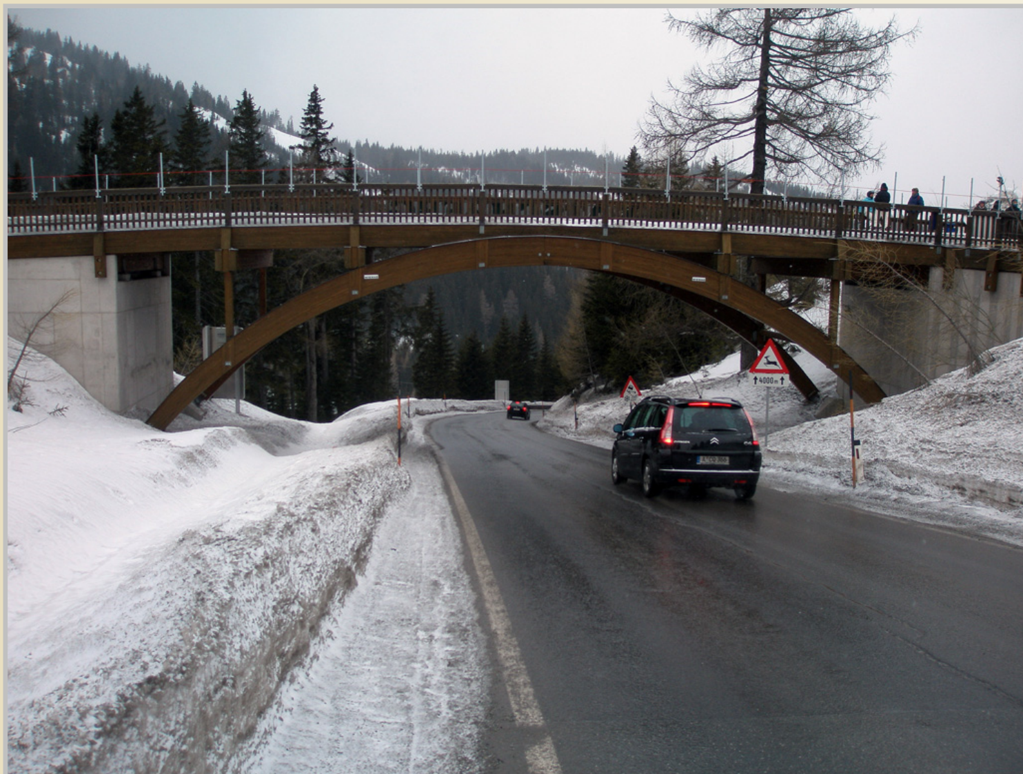
Most z lepeného lamelového dřeva, Katschberg, Rakousko
