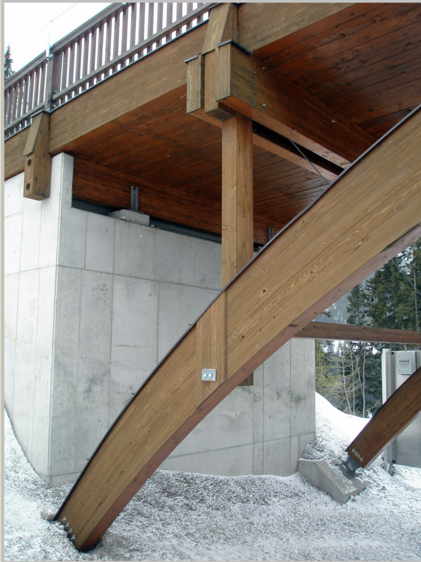
Most z lepeného lamelového dřeva, Katschberg, Rakousko
