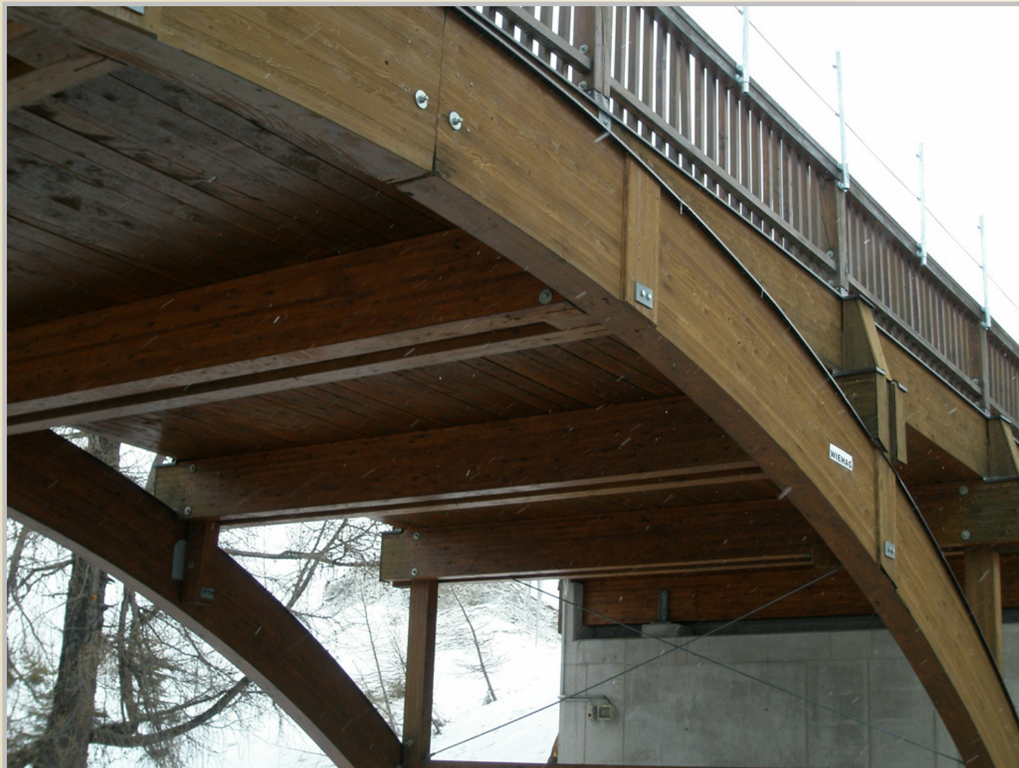
Most z lepeného lamelového dřeva, Katschberg, Rakousko
