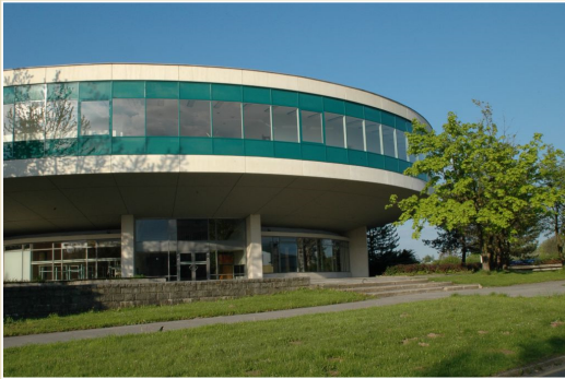
Posluchárny Vysoké školy báňské – Technická univerzita Ostrava
