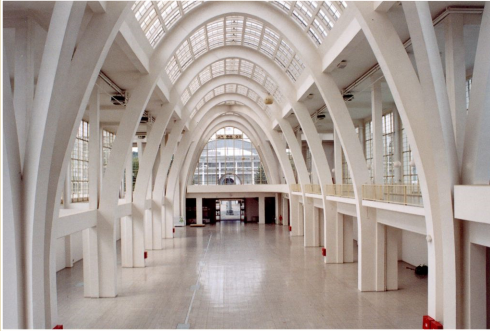
Výstavní pavilon A ve funkcionalistickém stylu z roku 1928 o ploše 12 500 m 2 , autor projektu železobetonové konstrukce arch. Emil Králík, výstaviště, Brno.
