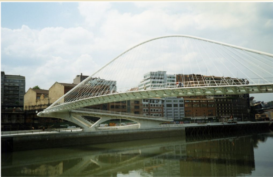
Prostorově zakřivený nosník mostu Zubizuri Bridge, Bilbao, Španělsko
