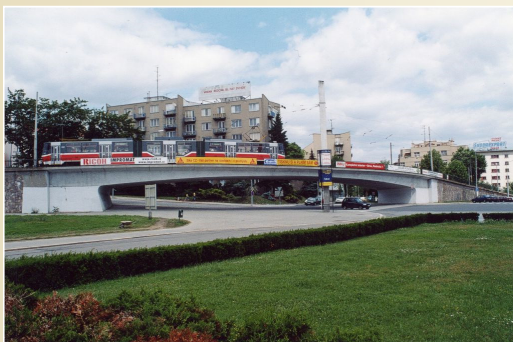
Železobetonový předpjatý tramvajový most Brno – Pisárky, specifický svým zakřivením, stoupáním a nestějnou tloušťkou, šířky 9 m.
