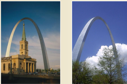
Gateway Arch, rozpětí a vzepětí ocelového oblouku z roku 1966 192,5 m, Saint Louis, Missouri. Rovinně zakřivený nosník v rovinné úloze 26 / 55
