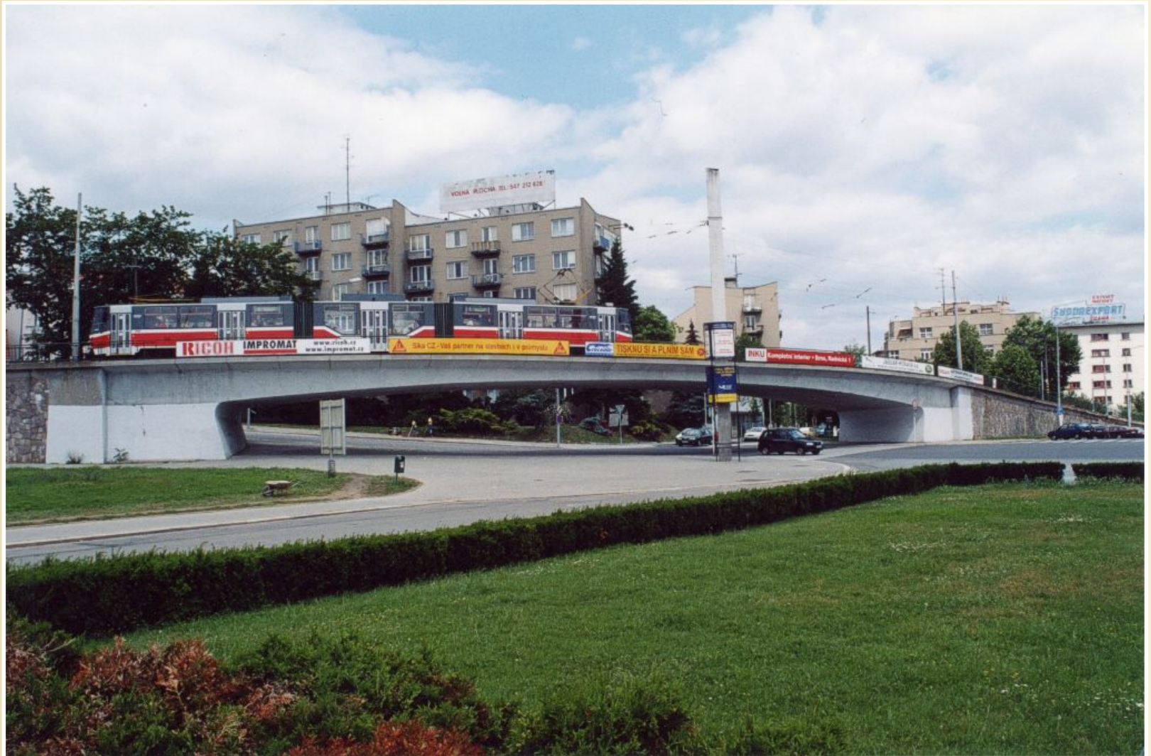
Železobetonový předpjatý tramvajový most Brno – Pisárky, specifický svým zakřivením, stoupáním a nestejnou tloušťkou, šířky 9 m.
