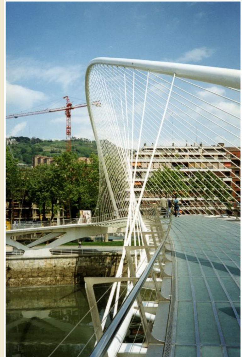
Detail prostorově zakřiveného nosníku mostu Zubizuri Bridge, Bilbao, Španělsko
