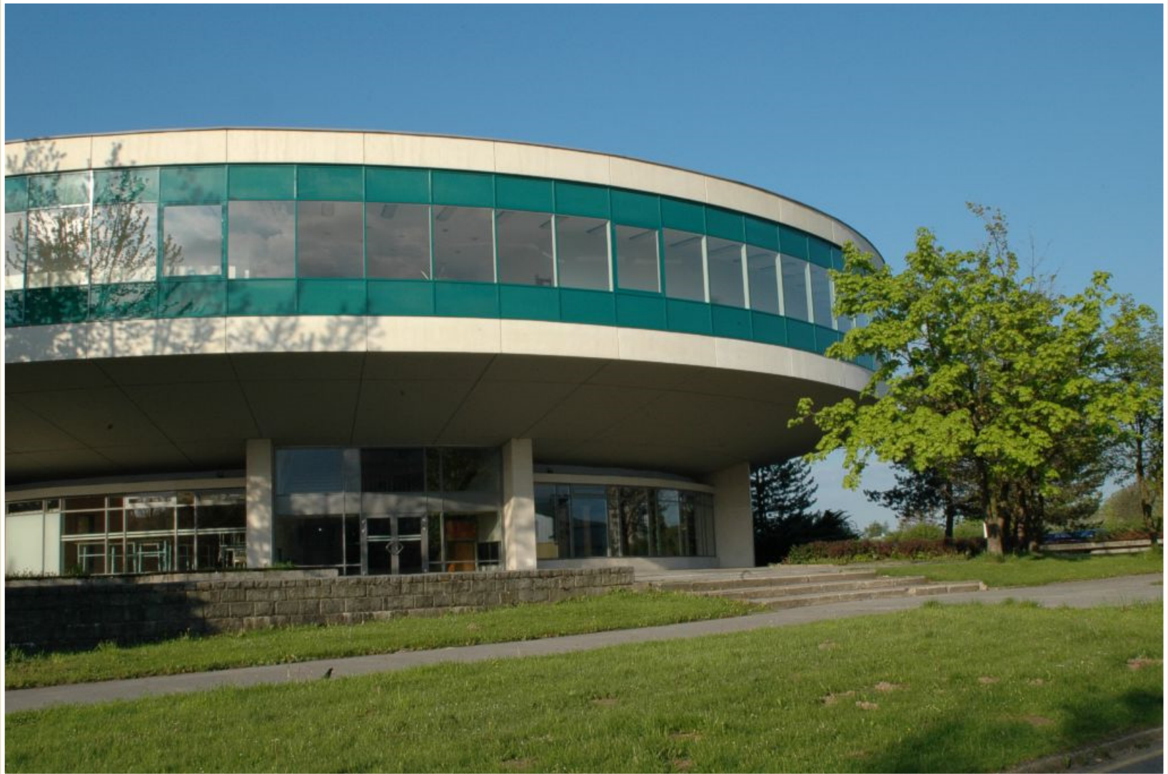
Posluchárny Vysoké školy báňské – Technická univerzita Ostrava
