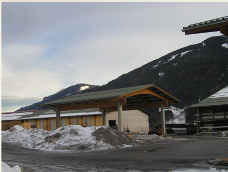
Nosná konstrukce střechy z lepeného lamelového dřeva, Štýrsko v Rakousku, foto: prof. Ing. Antonín Lokaj, Ph.D. Výpočet nosníku v příčné úloze (ve svislé hlavní rovině xz ) 74 / 110
