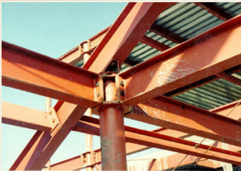
Nosná konstrukce radnice Ostrava – Krásné pole, projekt OKM
