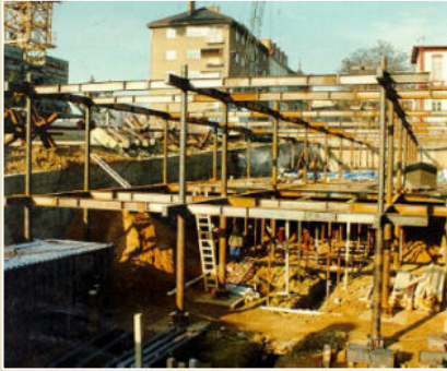
Nosná konstrukce střechy Fakultní dětské nemocnice v Černých Polích, Brno, projekt OKM Výpočet nosníku v příčné úloze (ve svislé hlavní rovině xz ) 73 / 110
