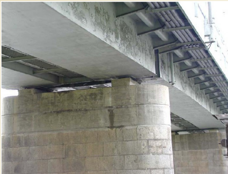
Chodníková konzola mostní konstrukce
