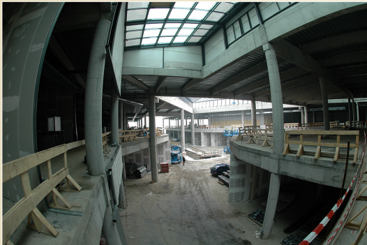
Konstrukce ocelových svétlíkú, Ikea-Avion Shopping Park, Ostrava-Zábfeh
