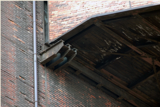
Konzolový nosník podepření technologického mostu dolu ČSA v Karviné
