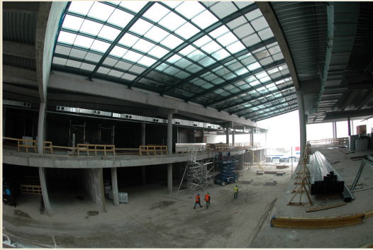
Konstrukce ocelových svétlíkú, Ikea-Avion Shopping Park, Ostrava-Zábfeh
