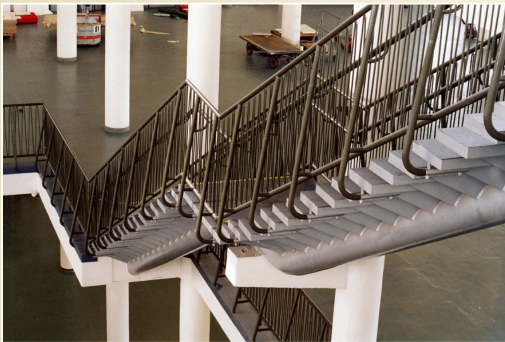
Konstrukce schodiště pavilonu C, Brněnské výstaviště
