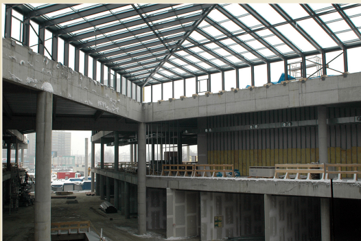
Konstrukce ocelových svétlíkú, Ikea-Avion Shopping Park, Ostrava-Zábfeh
