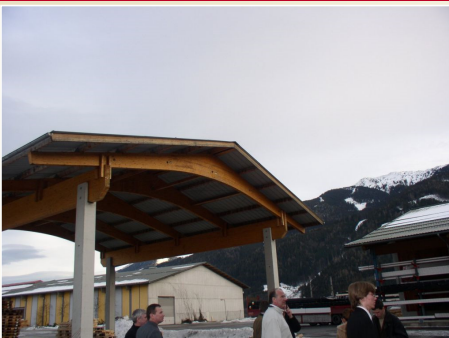
Nosná konstrukce střechy z lepeného lamelového dřeva, Štýrsko v Rakousku, foto: prof. Ing. Antonín Lokaj, Ph.D. Výpočet nosníku v příčné úloze (ve svislé hlavní rovině xz ) 75 / 110
