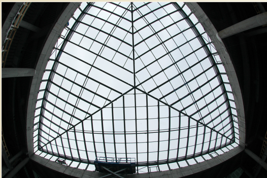
Konstrukce ocelových světlíků, Ikea-Avion Shopping Park, Ostrava-Zábřeh
