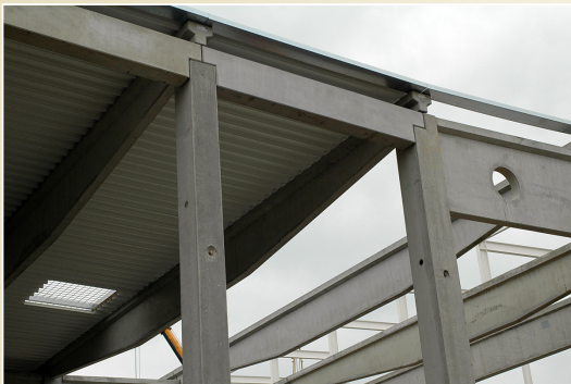
Prosté nosníky železobetonového skeletu, Albert, Ostrava-Poruba
