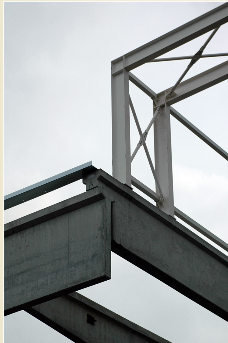
Převislé konce železobetonového skeletu, supermarket Albert, Ostrava-Poruba
