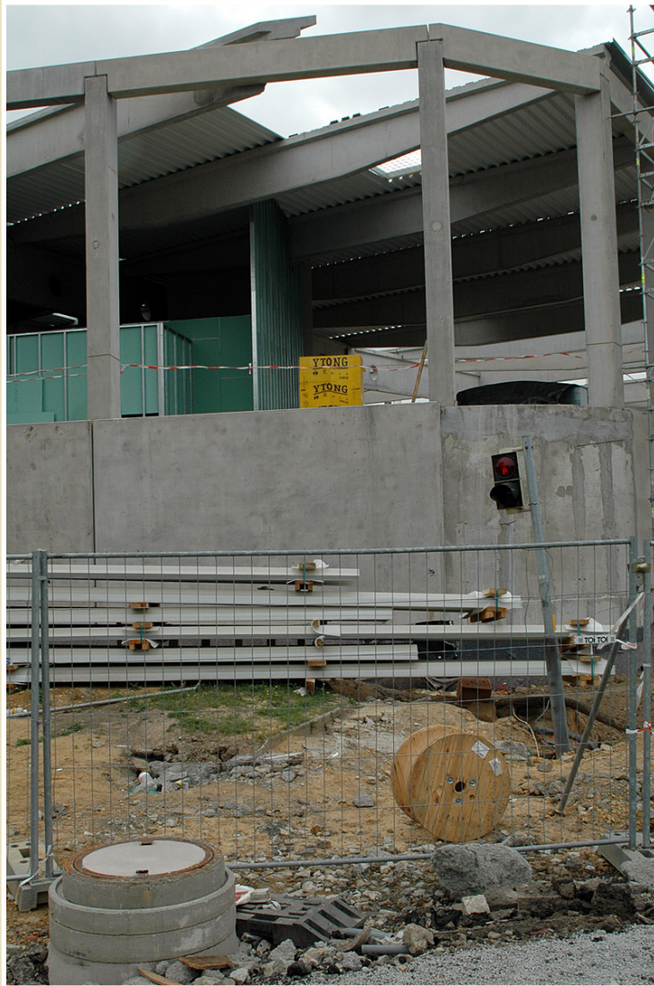
Prosté nosníky železobetonového skeletu, Interspar, Ostrava-Poruba
