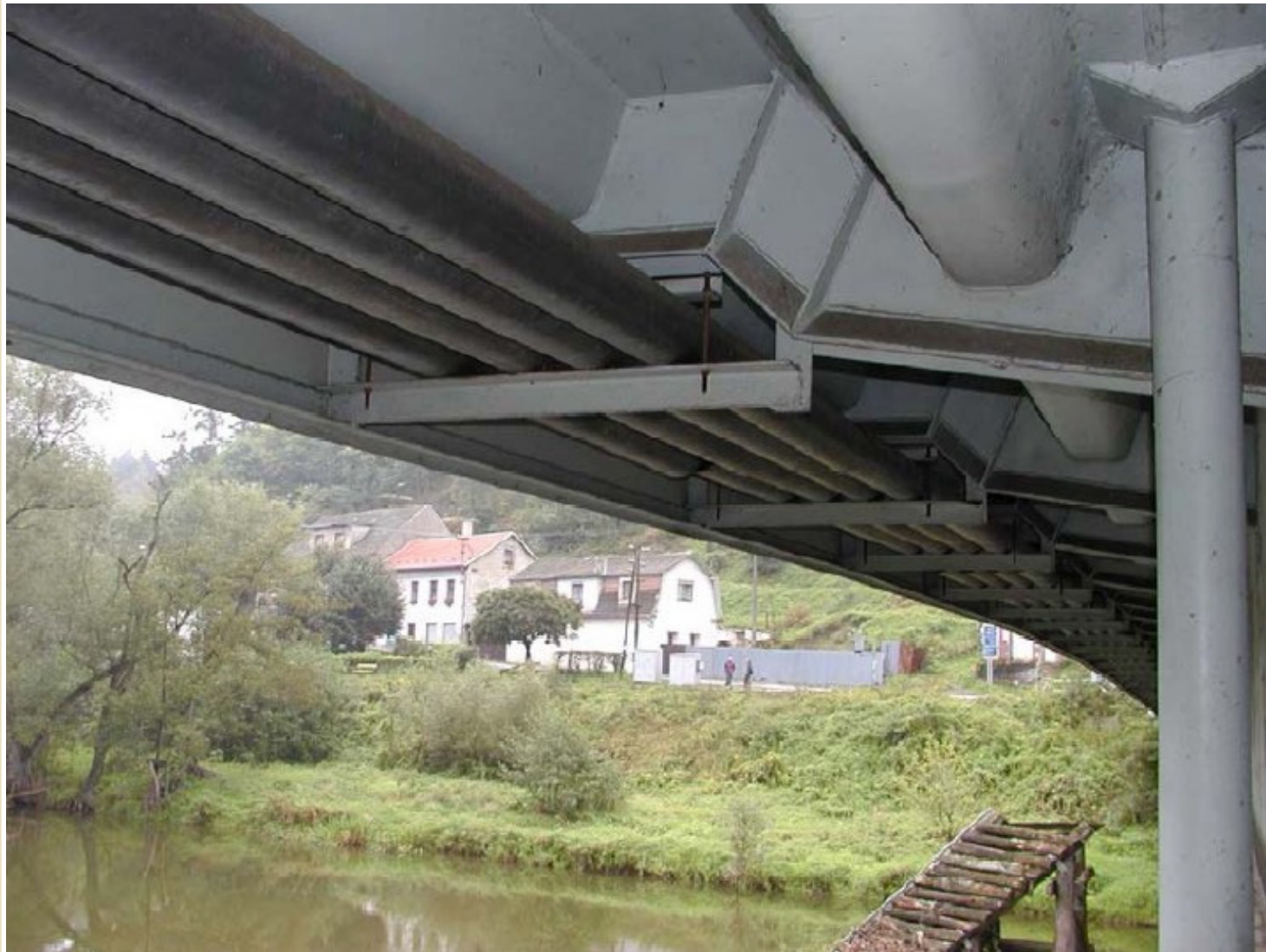
Chodníková konzola mostní konstrukce
