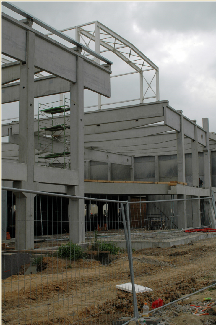
Převislé konce železobetonového skeletu, supermarket Albert, Ostrava-Poruba
