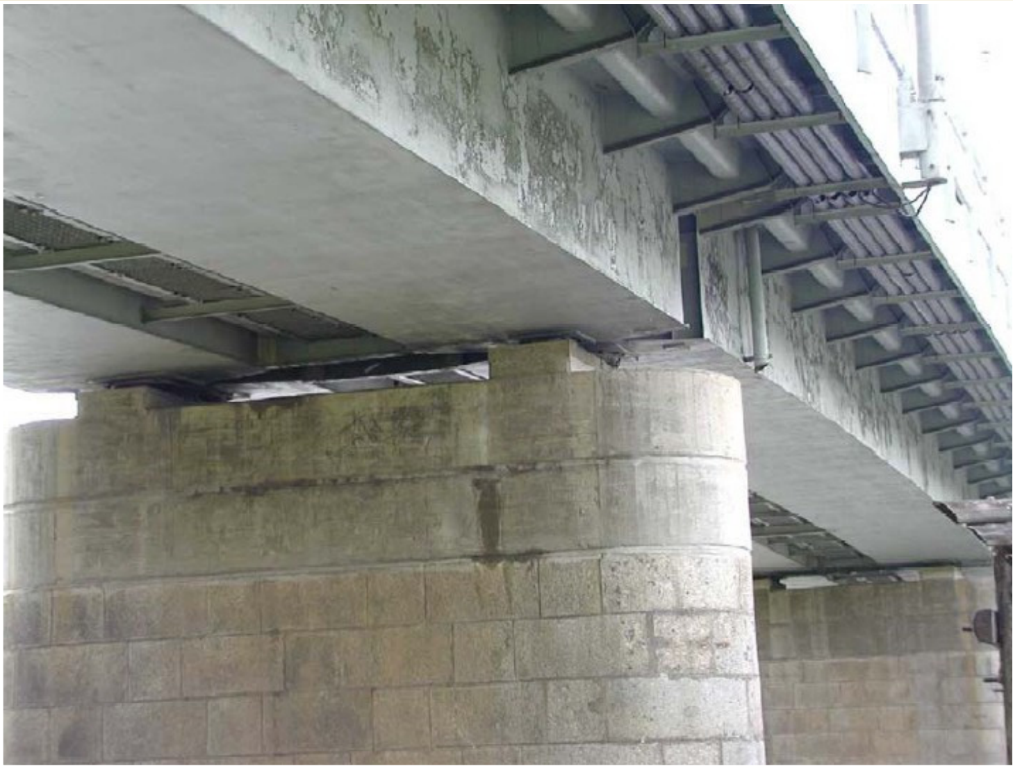
Chodníková konzola mostní konstrukce
