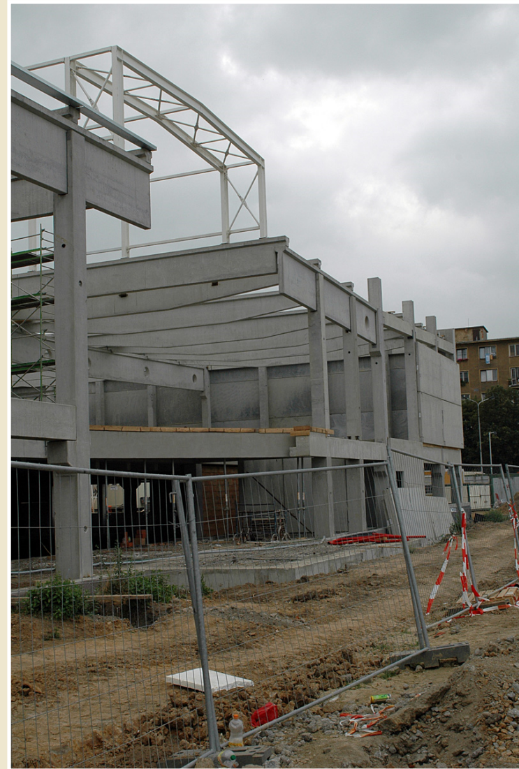
Prosté nosníky železobetonového skeletu, Interspar, Ostrava-Poruba
