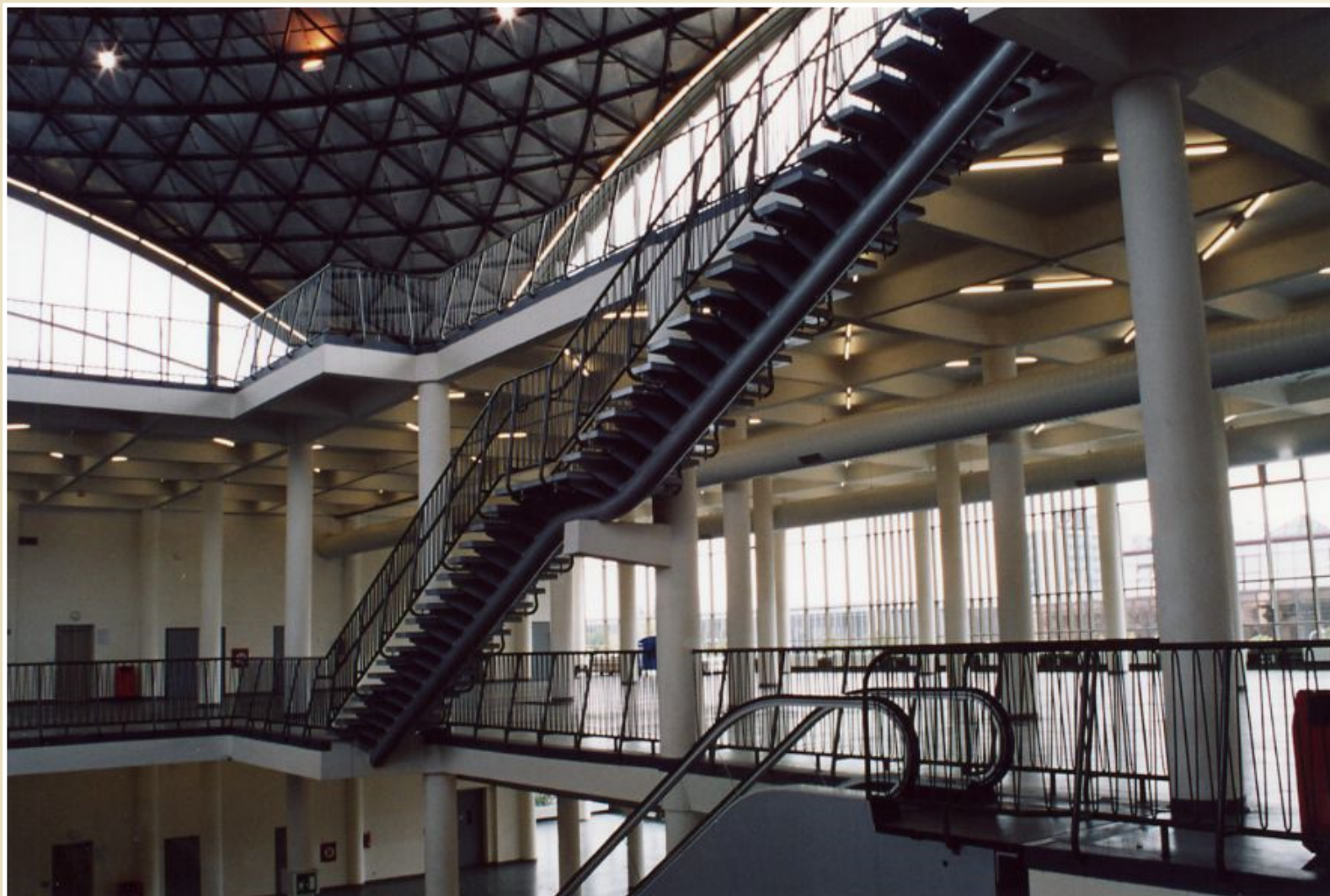
Betonový skelet a ocelová kopule pavilonu C, Brněnské výstaviště
