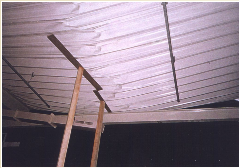
Deska – plošný nosný prvek, zatížený kolmo ke střednicové ploše, nadměrné přetvoření střechy vlivem extrémního zatížení sněhem, foto: Prof. Ing. Radim Čajka, CSc.
