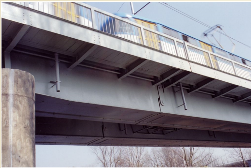
Most přes řeku Ostravici u Výstaviště, Ostrava
