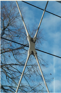
Kloubové spojení prutů ztužidel vstupní haly nádraží Ostrava - Svinov
