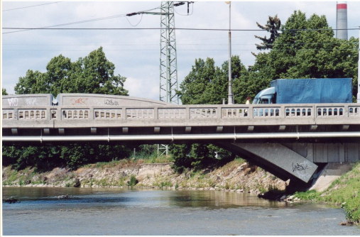
Maloměřický most z roku 1928, 3 oblouky o rozpětí 33 m s průřezem 1 m 2 , mezilehlá mostovka, Brno Prutová soustava 118 / 128
