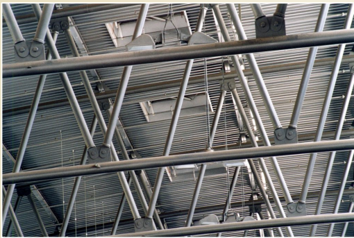
Pruty - příhradová konstrukce, Pavilon V z roku 2000, Brněnské výstaviště
