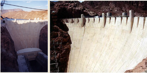
Kombinace klenbové a tížné přehrady z roku 1935, výška 221,3 m, délka oblouku 379,2 m, šířka hráze nahoře 13,7 m a 201,2 m dole, 3,5 mil. m 3 betonu
