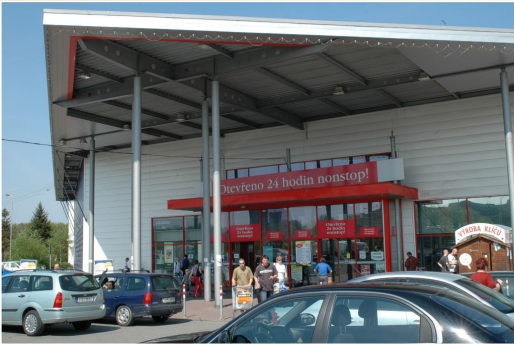
Podepření střešní konstrukce sloupy, Tesco, Ostrava - Třebovice
