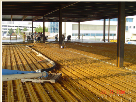
Deska – plošný nosný prvek, zatížený kolmo ke střednicové ploše
