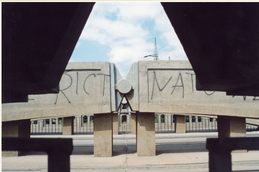
Maloměřický most z roku 1928, 3 oblouky o rozpětí 33 m s průřezem 1 m 2 , mezilehlá mostovka, Brno Prutová soustava 119 / 128
