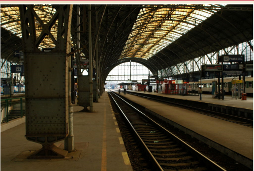
Podepření konstrukce nástupní haly, Hlavní nádraží, Praha
