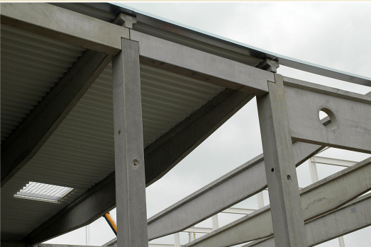
Kloubově uložené nosníky železobetonového skeletu, Albert, Ostrava-Poruba
