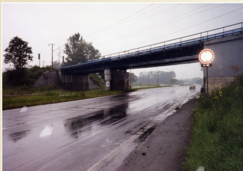
Havířov, železniční most přes silnici Rudná
