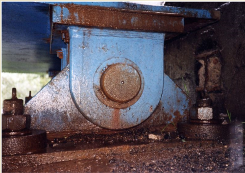
Havířov, železniční most přes silnici Rudná
