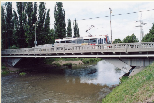
Maloměřický most z roku 1928, 3 oblouky o rozpětí 33 m s průřezem 1 m 2 , mezilehlá mostovka, Brno
