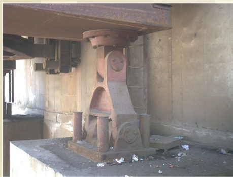
Most přes železniční trať z roku 1980, Ostrava – Svinov, délka 130 m, hmotnost 2.840 t
