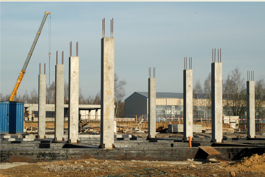
Vetknuté sloupy železobetonového skeletu, Centrum pokročilých technologií, VŠB-TU Ostrava
