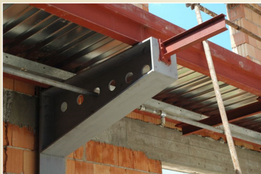
Konzolový nosník, výzkumné energetické centrum VŠB-TU Ostrava
