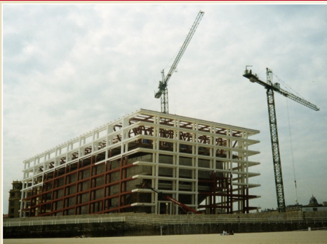
Konstrukce prostorového rámu Kursaal Convention Centre and Auditorium, San Sebastian, Španělsko
