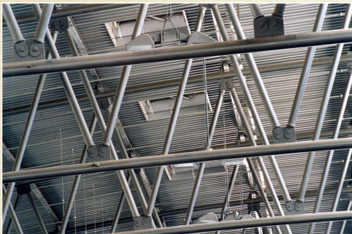
Kloubové připojení diagonál k dolnímu pásu příhradového vazníku, Pavilon V, Brněnské výstaviště
