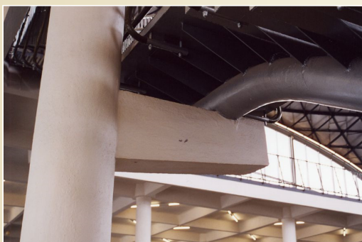
Konzolový nosník konstrukce schodiště pavilonu C, Brněnské výstaviště
