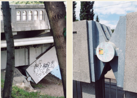
Maloměřický most z roku 1928, 3 oblouky o rozpětí 33 m s průřezem 1 m 2 , mezilehlá mostovka, Brno Prutová soustava 120 / 128
