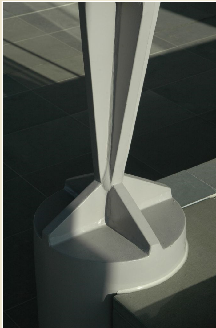
Detail podepření sloupu, nádraží Ostrava - Svinov
