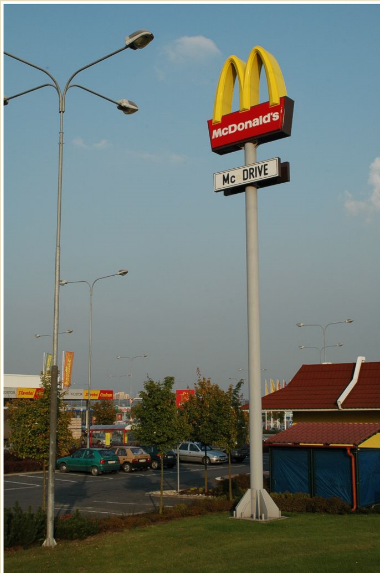
Sloup s podepřením vetknutím
