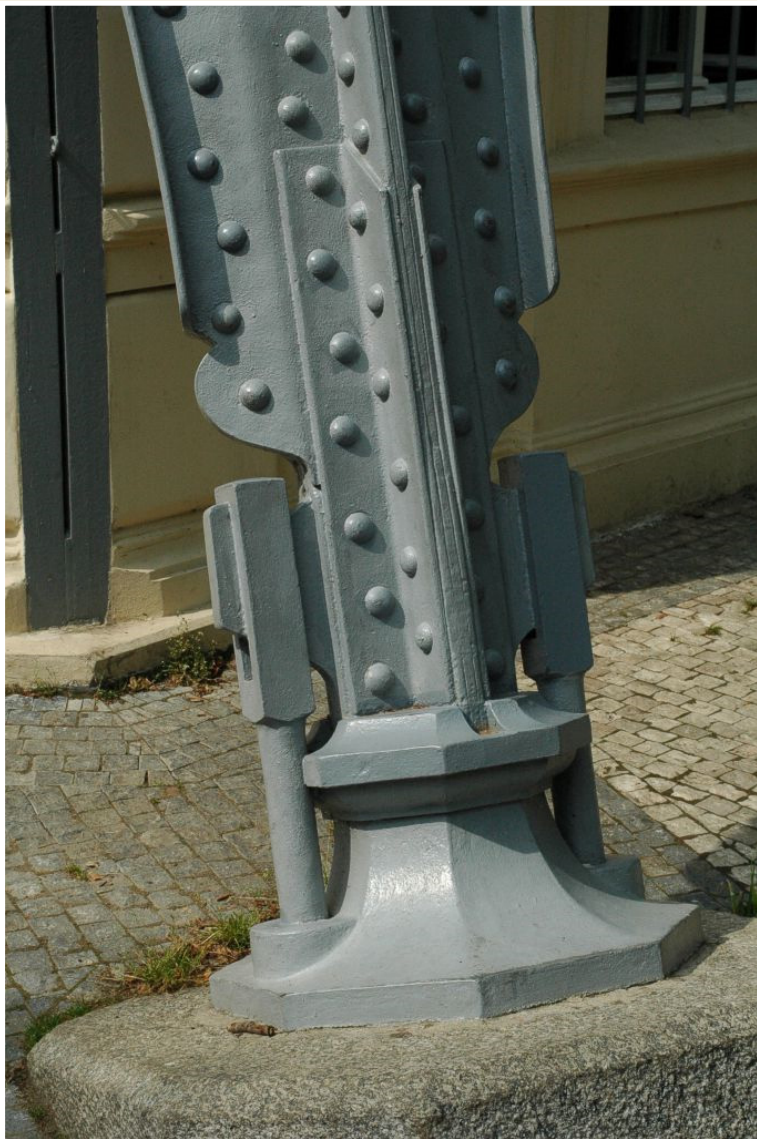
Detail podepření, Petřínská rozhledna, Praha
