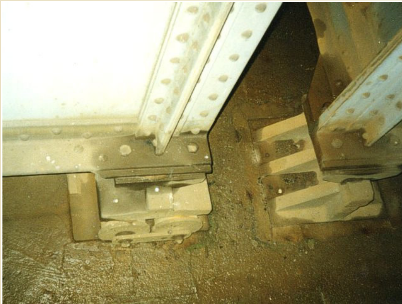
Most přes místní komunikaci na železniční trati Dětmorovice – Petrovice: km 286.258
