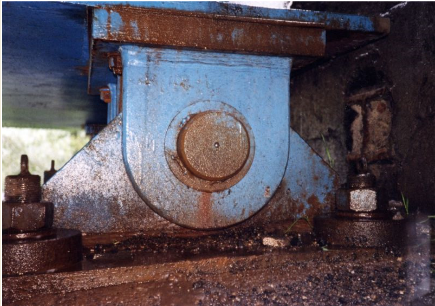
Havířov, železniční most přes silnici Rudná
