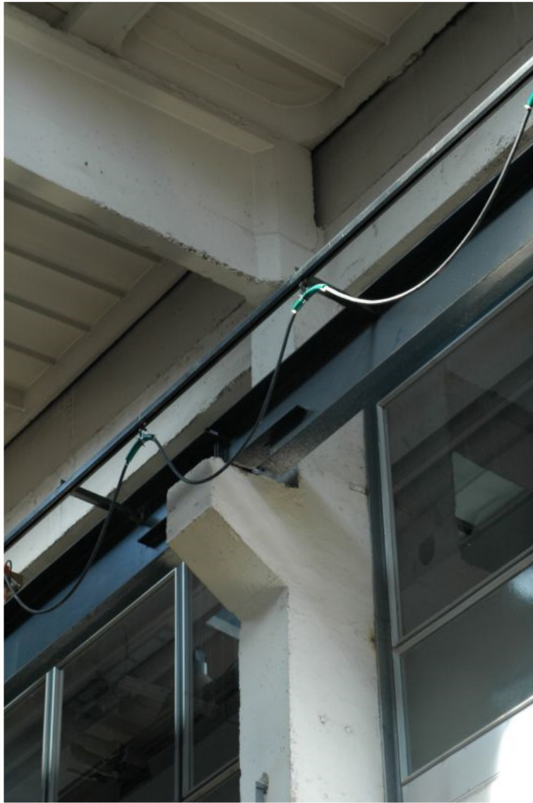
Bodové silové zatížení konzoly
