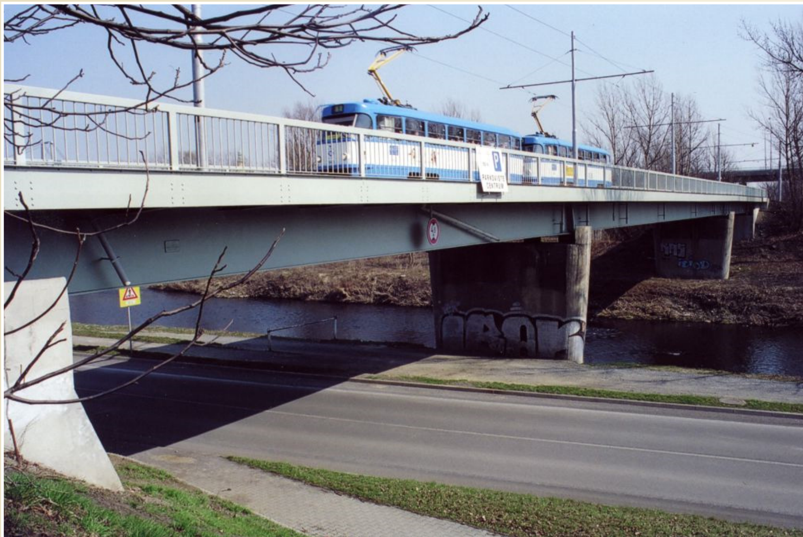
Most přes řeku Ostravici u Výstaviště, Ostrava
