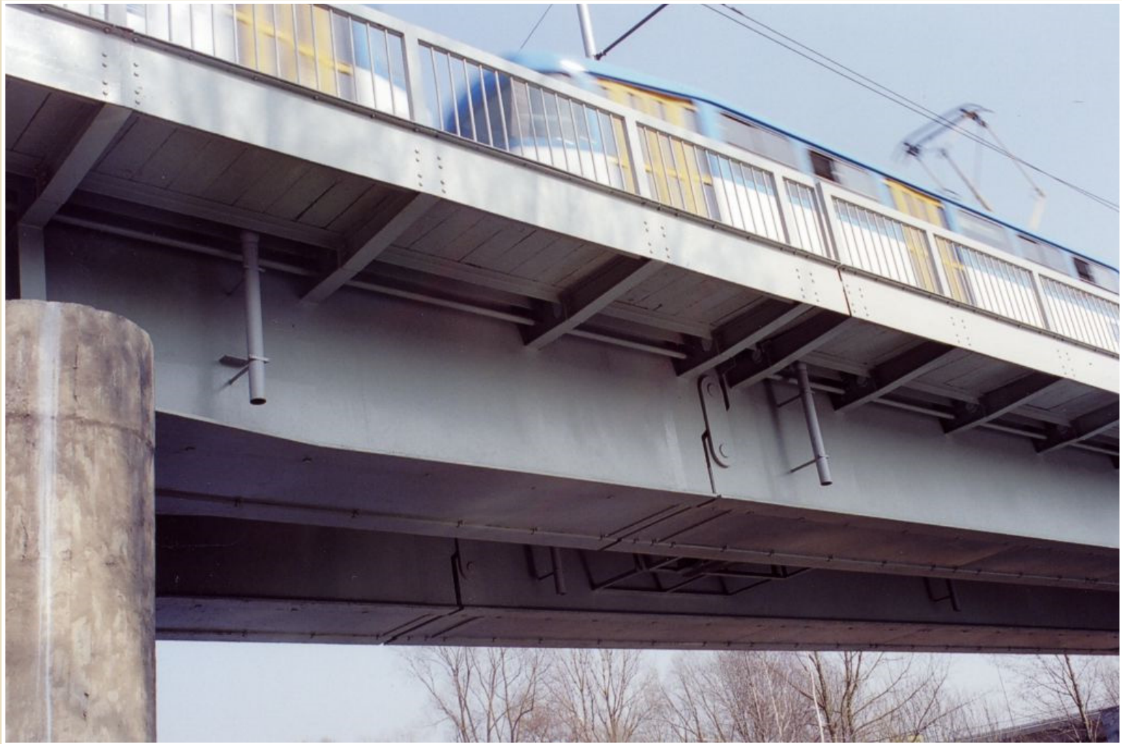
Most přes řeku Ostravici u Výstaviště, Ostrava
