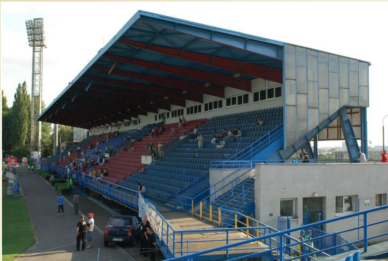
Tribuna fotbalového stadionu Baníku Ostrava, Ostrava - Bazaly
