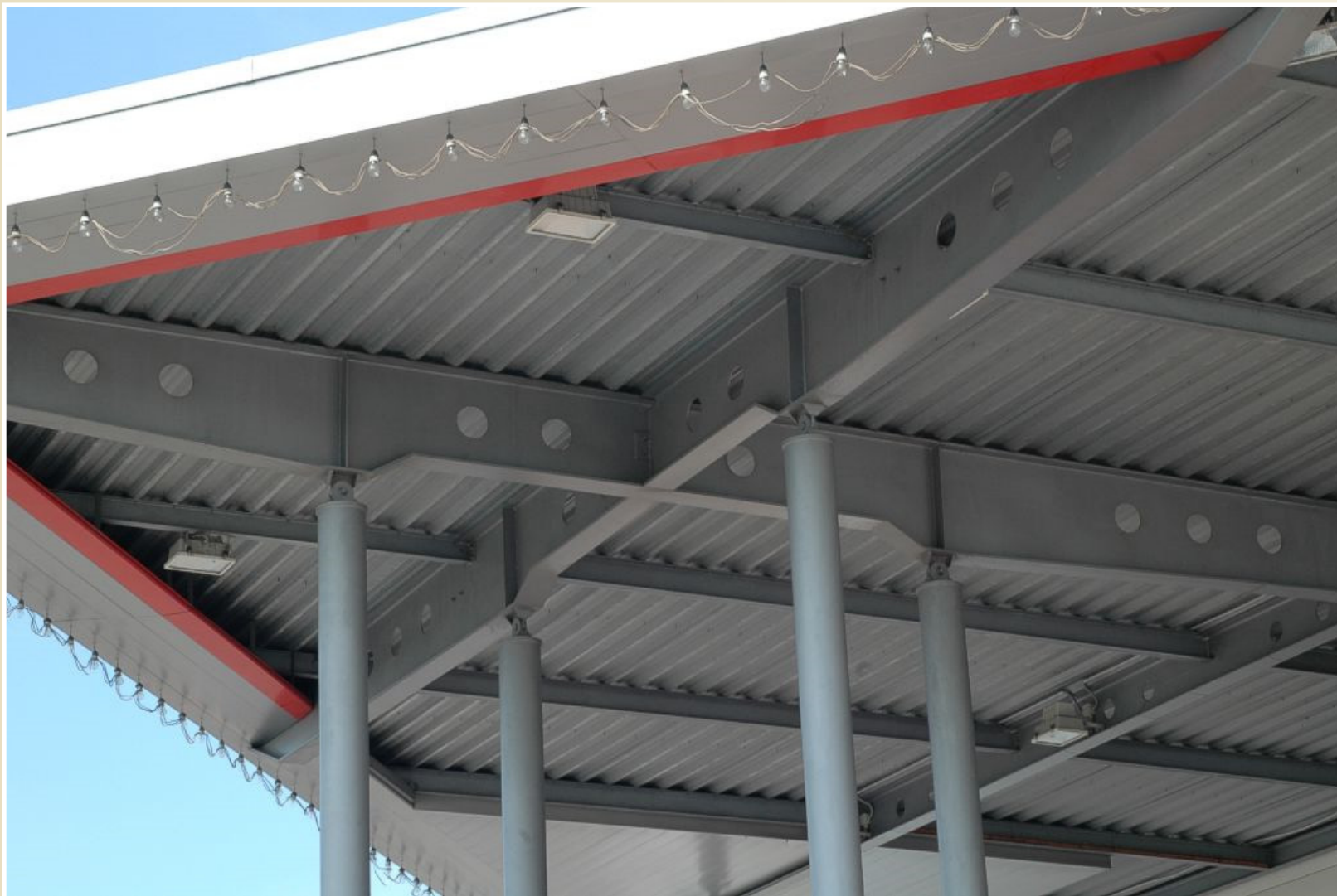
Podpěření střešní konstrukce sloupy, Tesco, Ostrava - Třebovice
