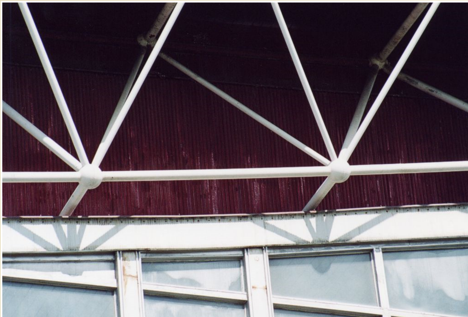
Monolitické styčníky prostorové příhradové ocelové konstrukce plaveckého stadiónu v Brně
