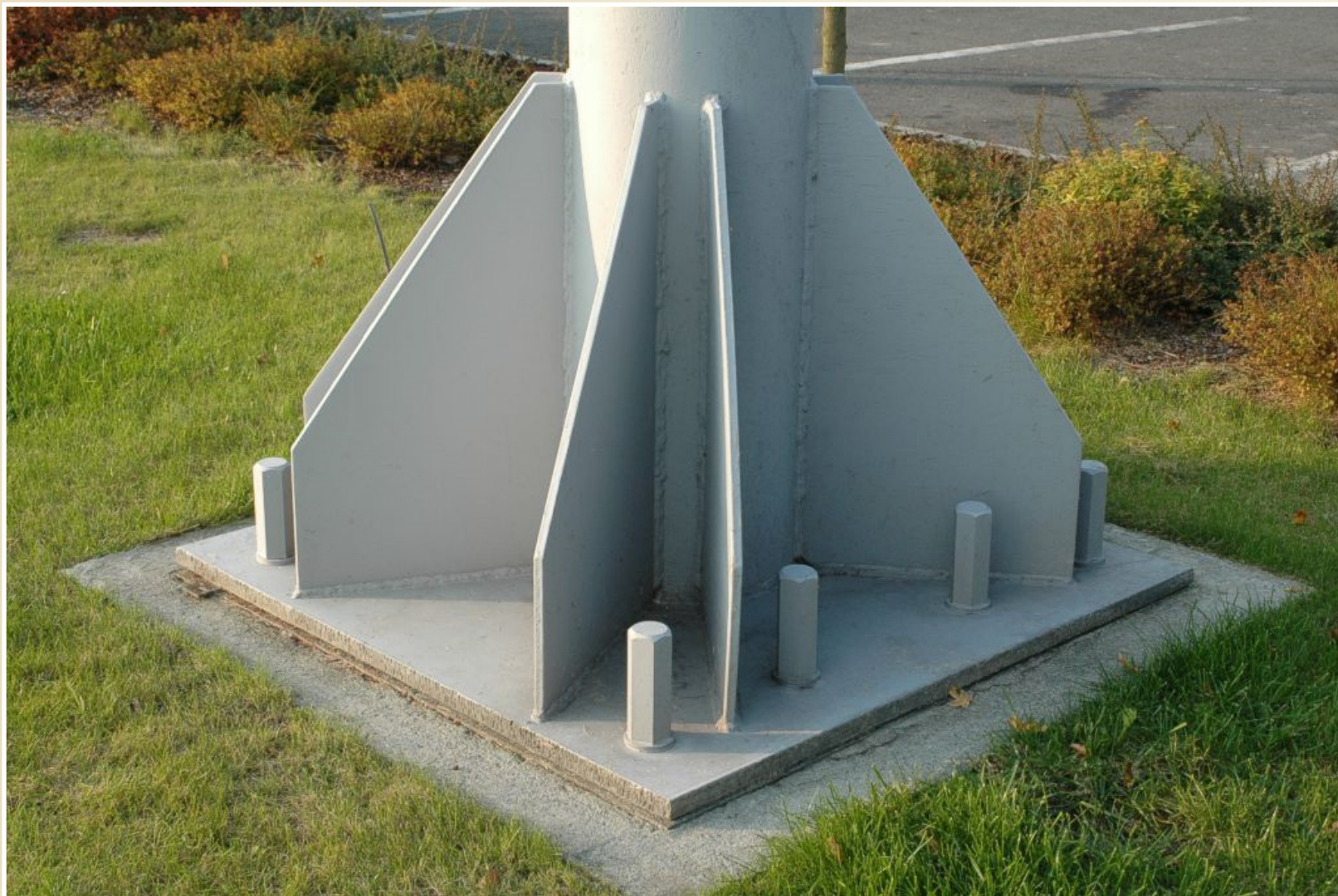
Sloup s podepřením vetknutím
