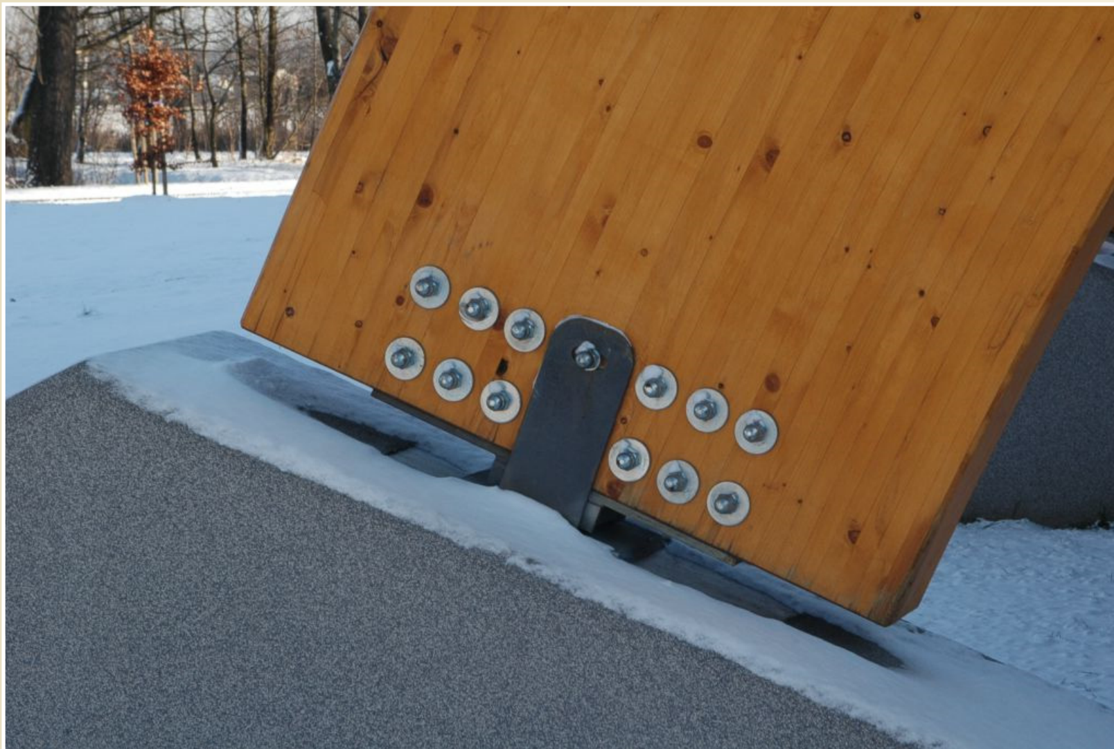
Detail podepření dřevěné konstrukce, Aquapark, Bohumín
