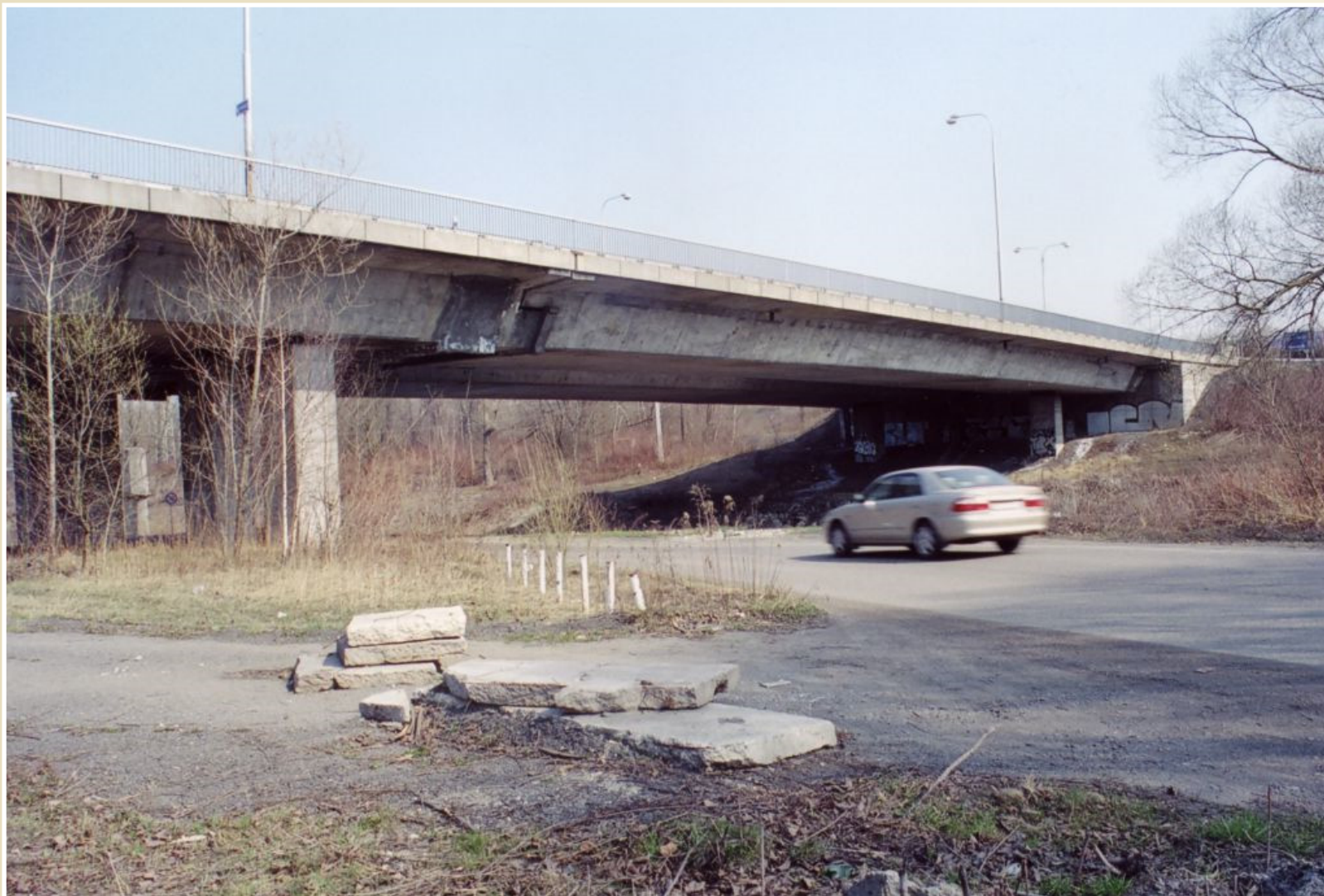
Most přes řeku Ostravici u Výstaviště, Ostrava
