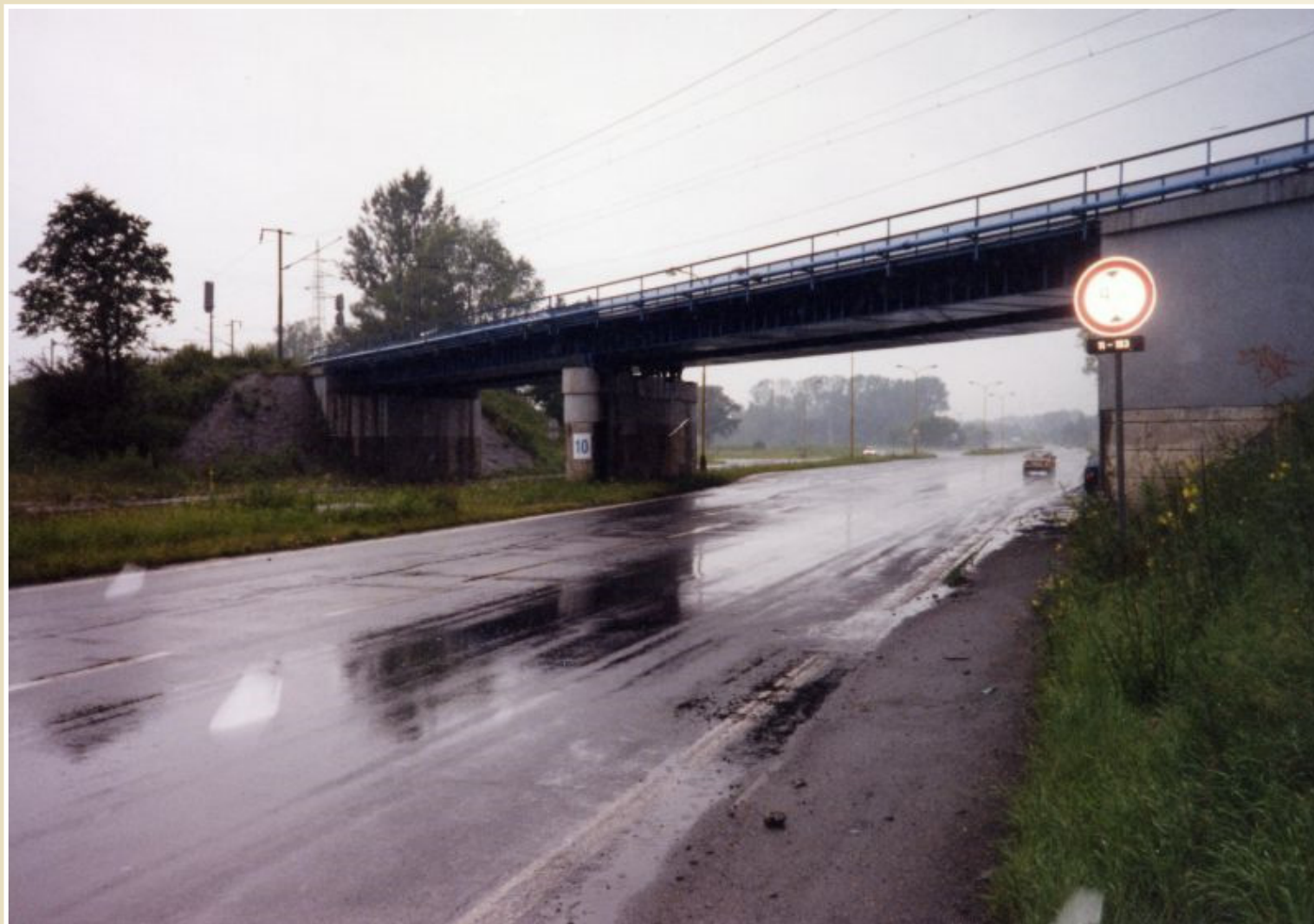
Havířov, železniční most přes silnici Rudná
