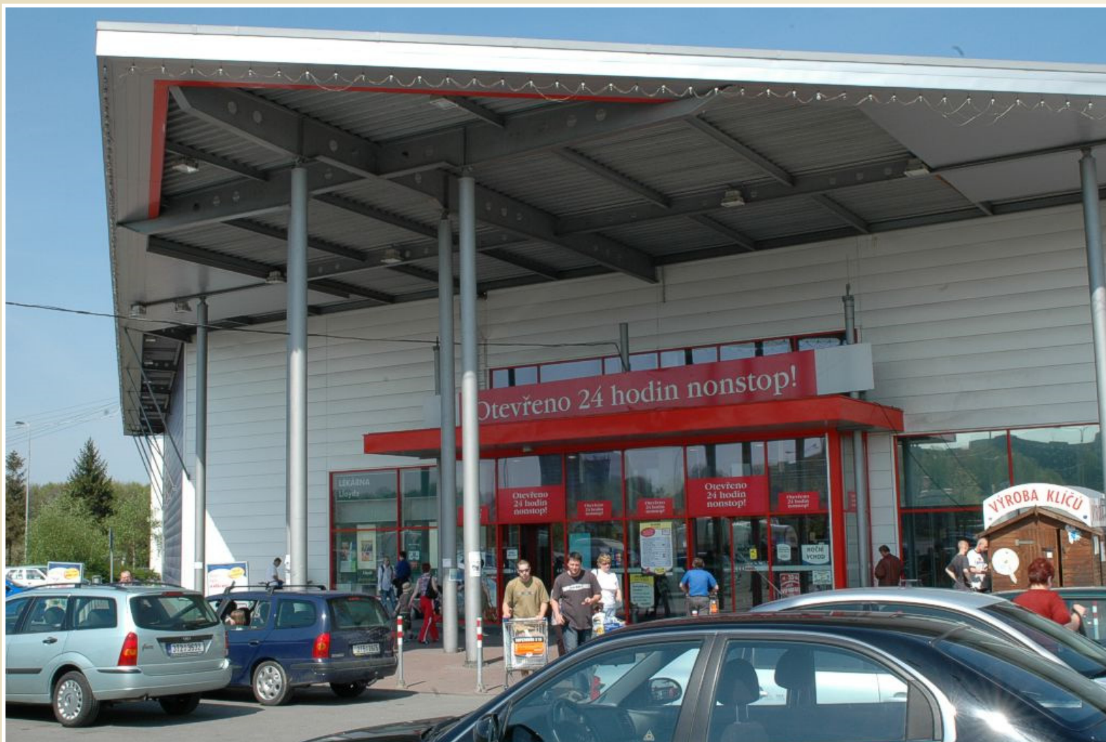
Podpření střešní konstrukce sloupy, Tesco, Ostrava - Třebovice
