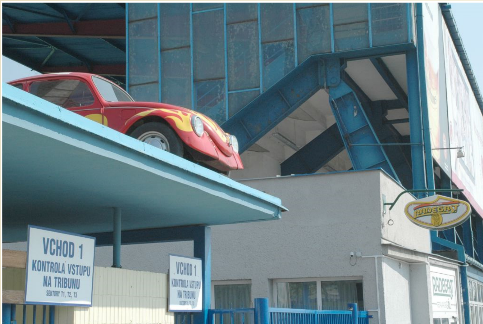
Tribuna fotbalového stadionu Baníku Ostrava, Ostrava - Bazaly
