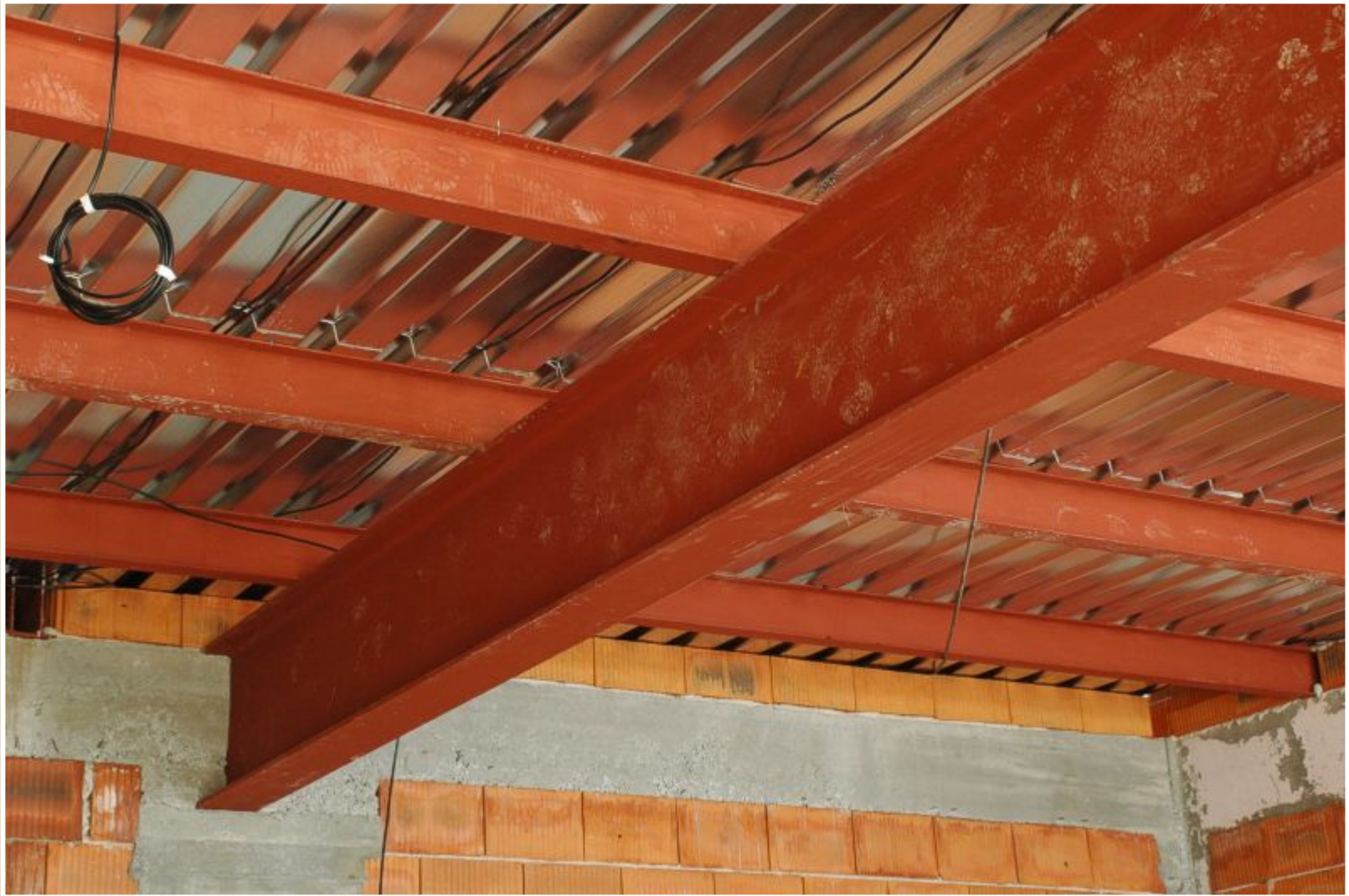
Stropní konstrukce výzkumného energetického centra VŠB-TU Ostrava
