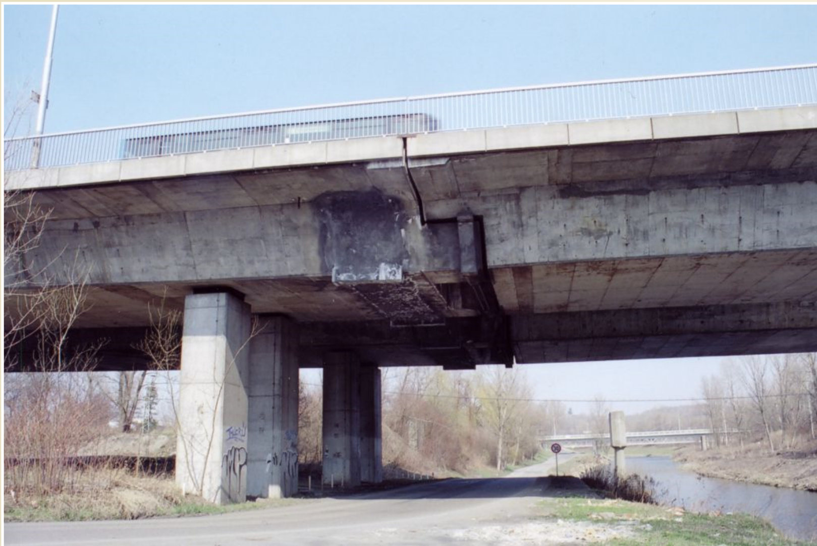
Most přes řeku Ostravici u Výstaviště, Ostrava
