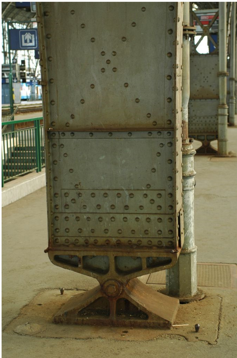
Detail podepření sloupu nástupní haly, Hlavní nádraží, Praha
