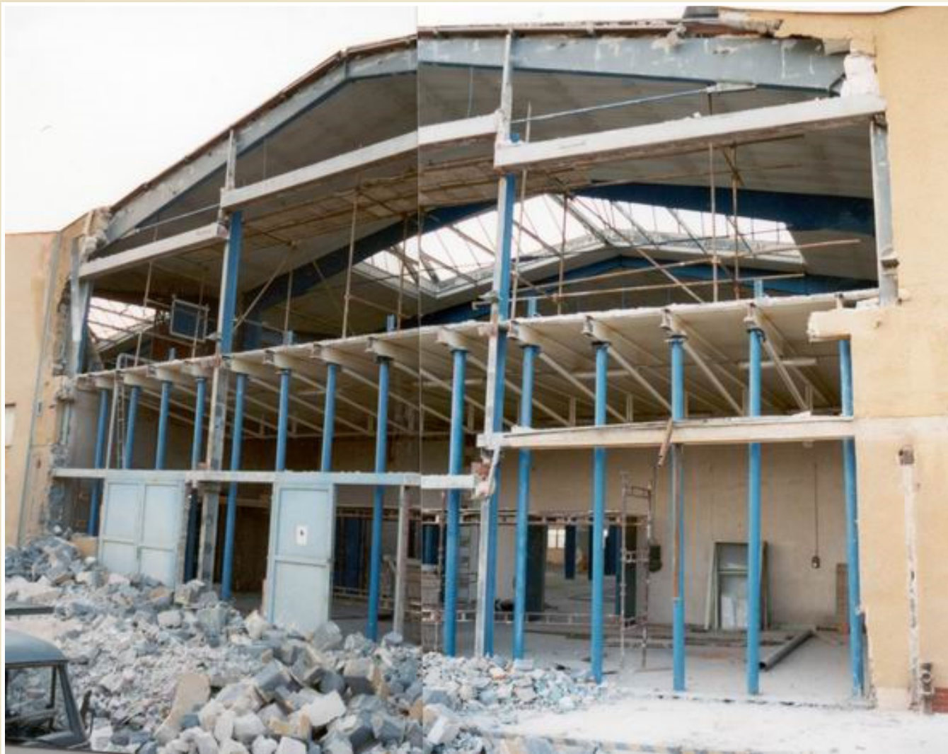
Provizorní podepření stropu stojkami
