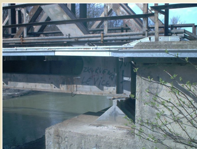
Most přes řeku Odru z roku 1964, Polanecká spojka, Ostrava – Záběh
