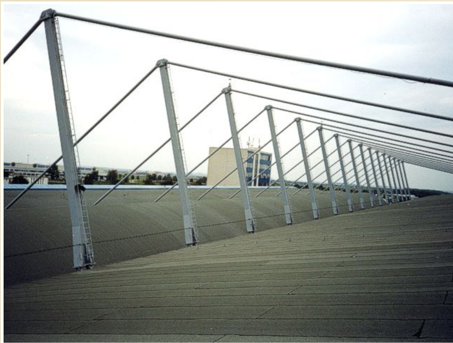
Jednostranně zavěšené zastřešení hangáru Praha - Ruzyně
