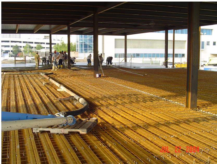
Obrázek 1.2: Nosný systém, který obsahuje stropní desku - plošný konstrukční prvek
