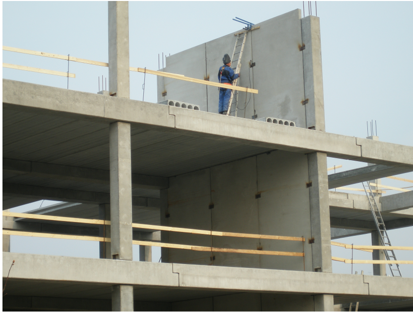
Obrázek 1.3: Nosný systém, tvořený prutovými prvky a tzv. ztužující stěnou - plošným konstrukčním prvkem
