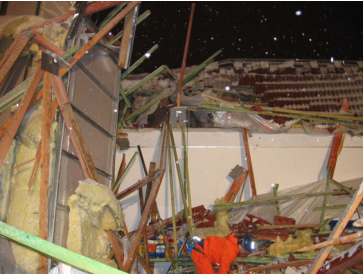
Destrukcce dřevěného vazníku v Ostravě, foto: doc. Ing. Karel Kubečka, Ph.D.
