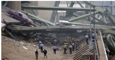
Zřícený most přes řeku Mississippi, Minneapolis, srpen 2007
