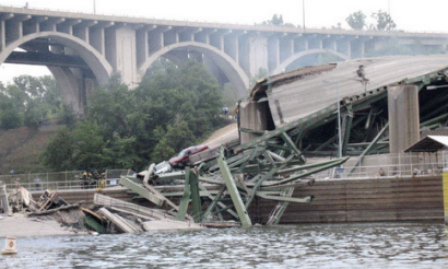
Zřícený most přes řeku Mississippi, Minneapolis, srpen 2007
