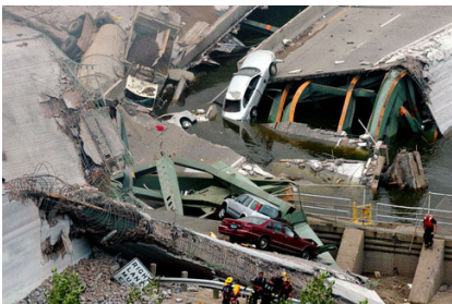
Zřícený most přes řeku Mississippi, Minneapolis, srpen 2007
