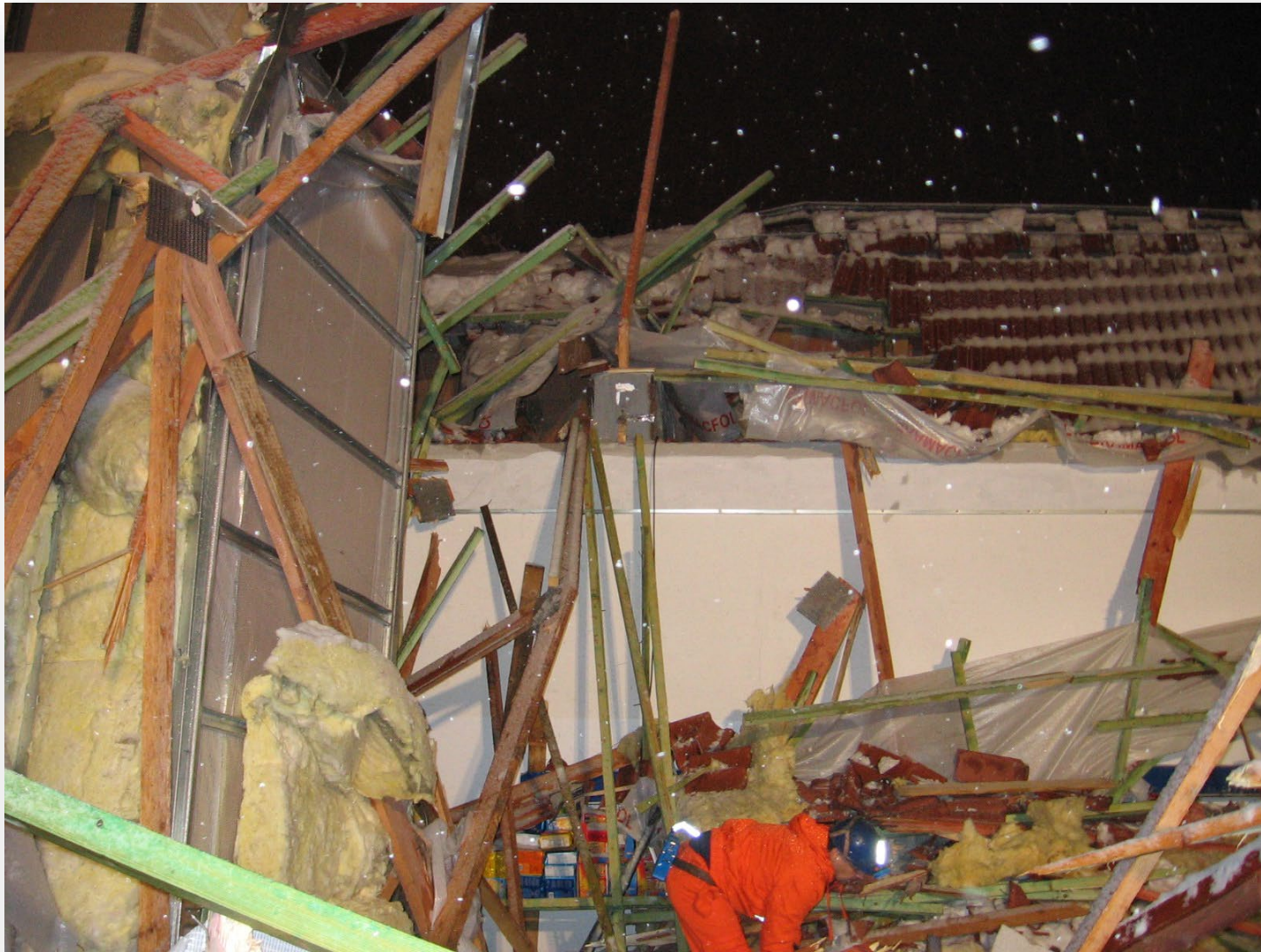
Destrukce dřevěného vazníku v Ostravě, foto: doc. Ing. Karel Kubečka, Ph.D.
