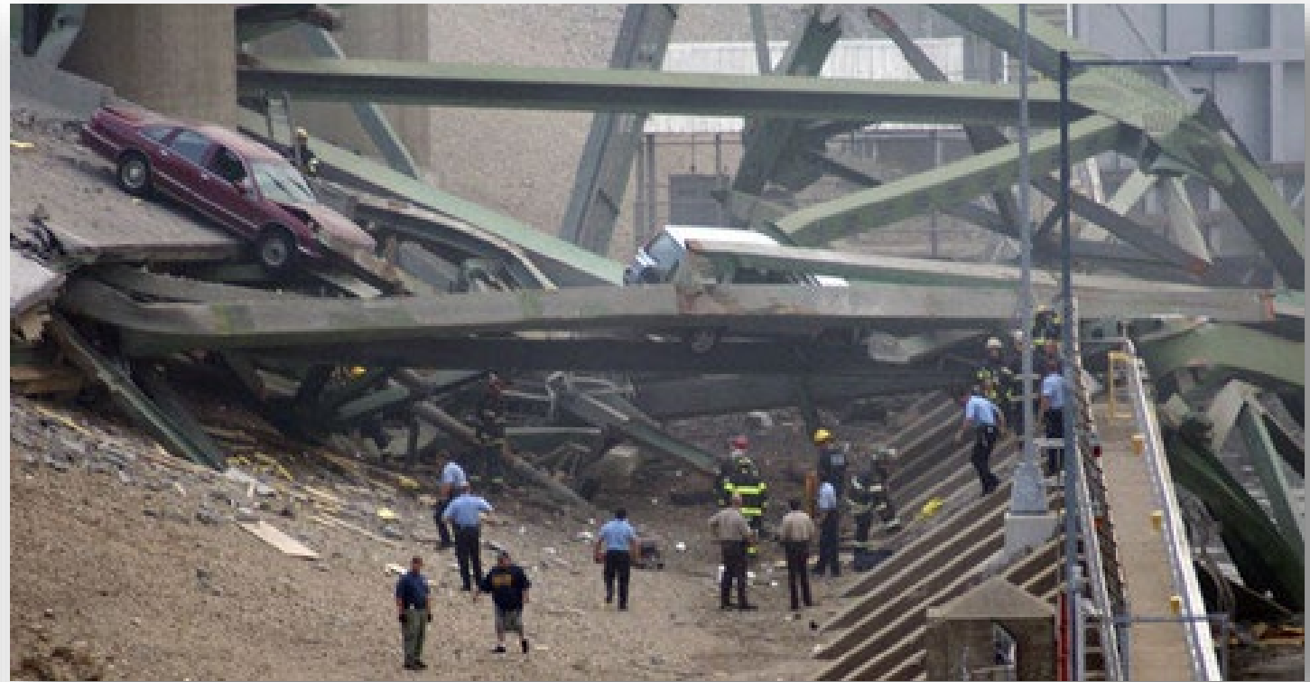
Zřícený most přes řeku Mississippi, Minneapolis, srpen 2007
