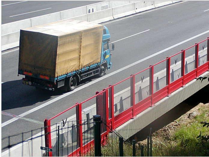
Pohled na posuzovaný silniční most, foto: doc. Ing. Jaroslav Odrobiňák, PhD.
