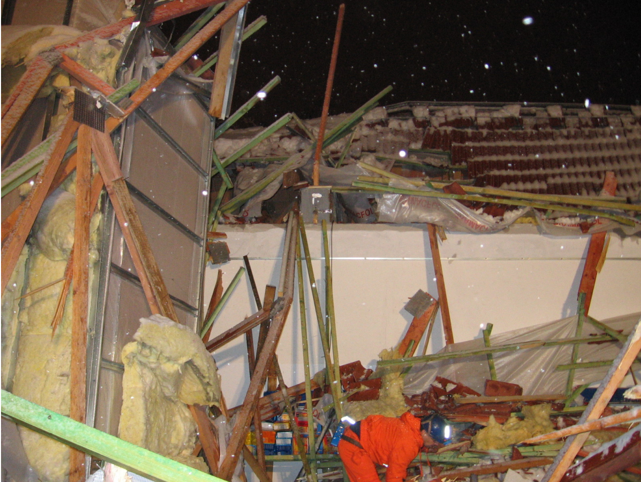
Destrukce dřevěné konstrukce střechy v Ostravě, foto: doc. Ing. Karel Kubečka, Ph.D.
