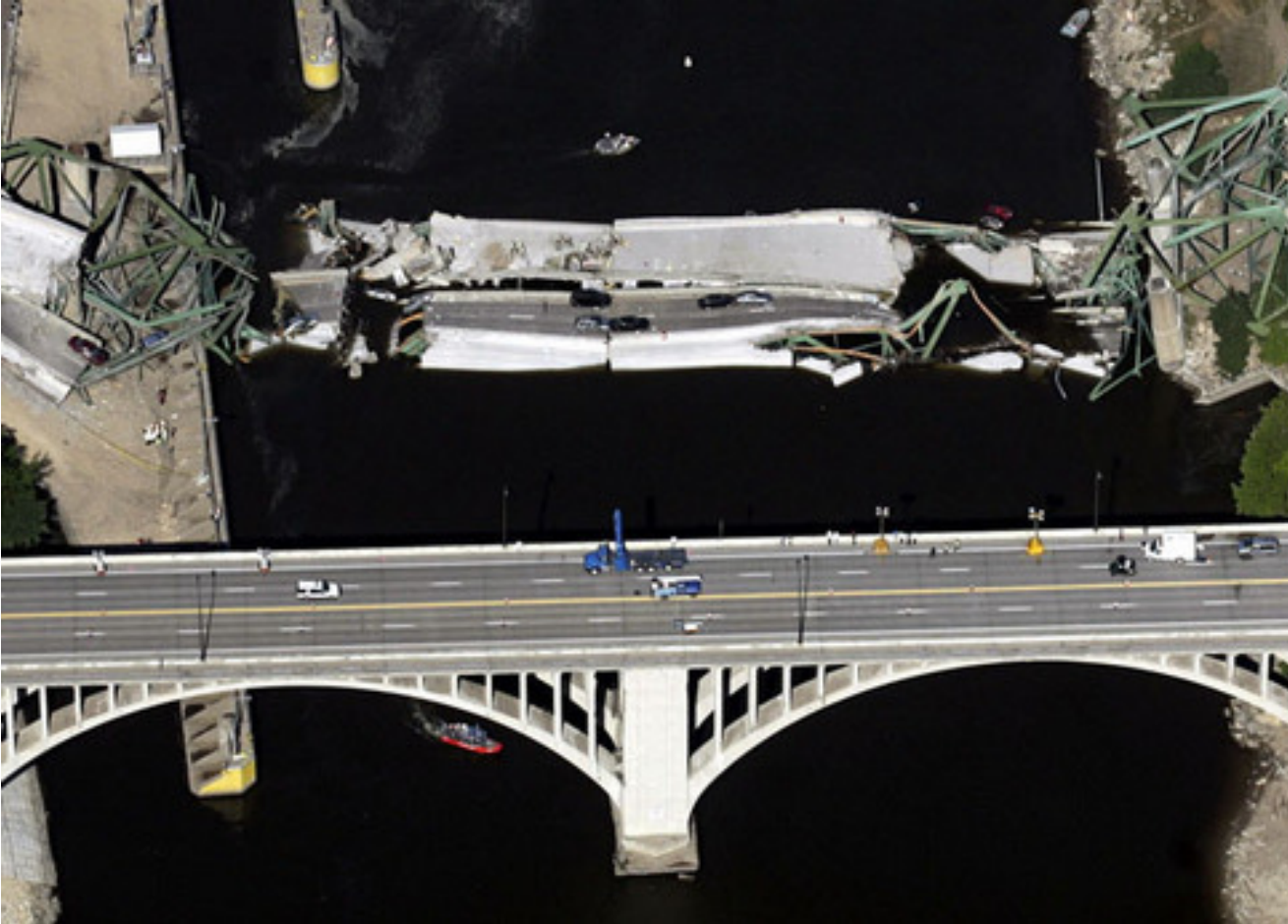
Havárie mostu přes řeku Mississippi, Minneapolis, USA, srpen 2007
