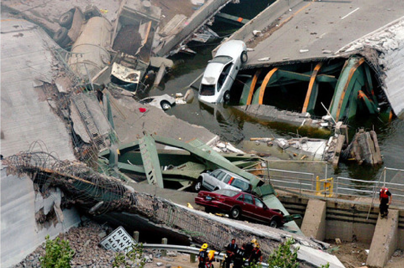
Havárie mostu přes řeku Mississippi, Minneapolis, USA, srpen 2007
