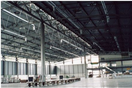
Ukázky stavebních konstrukcí s nosnými prvky namáhanými vzpěrným tlakem
