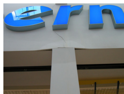
Porucha způsobená nerespektováním přetvoření betonového průvlastku, foto: prof. Ing. Radim Čajka, CSc.
