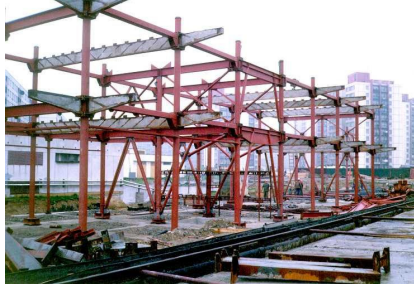
Ocelobetonová rámová konstrukce
