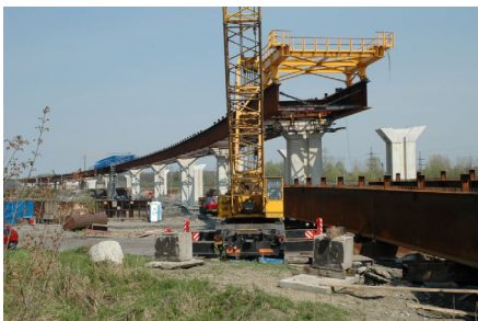
Montáž ocelové části mostu
