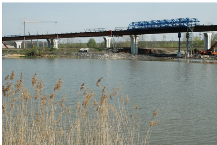
Montáž ocelové části mostu
