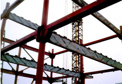
Ocelobetonová rámová konstrukce
