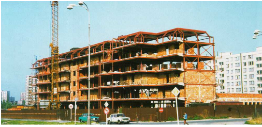
Ocelobetonová rámová konstrukce
