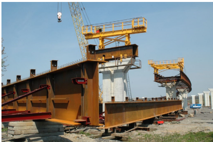
Montáž ocelové části mostu
