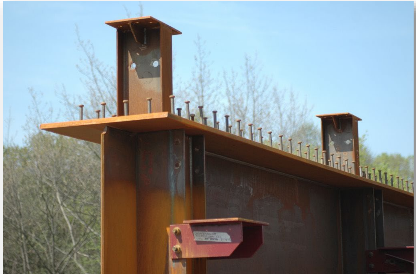
Detail spřahovacích trnů
