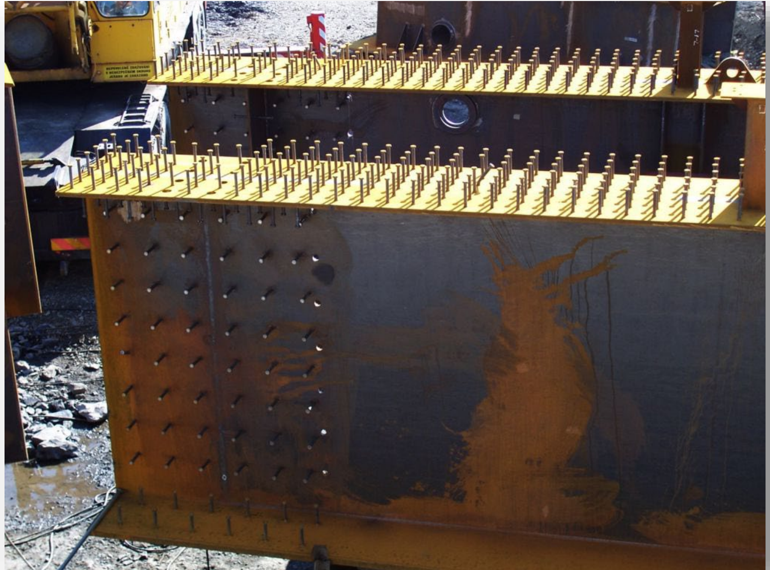
Detail spřahovacích trnů
