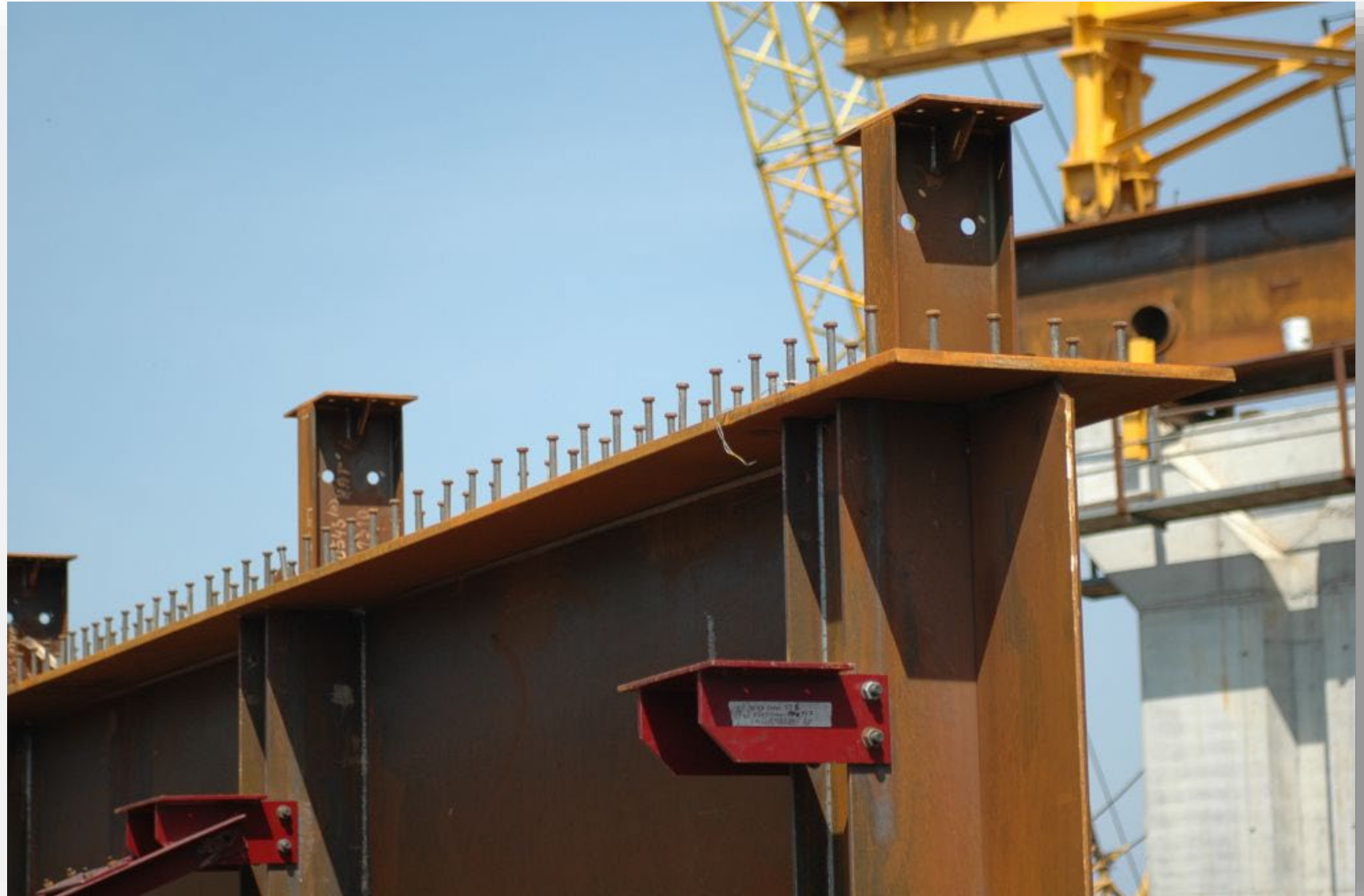
Detail spřahovacích trnů
