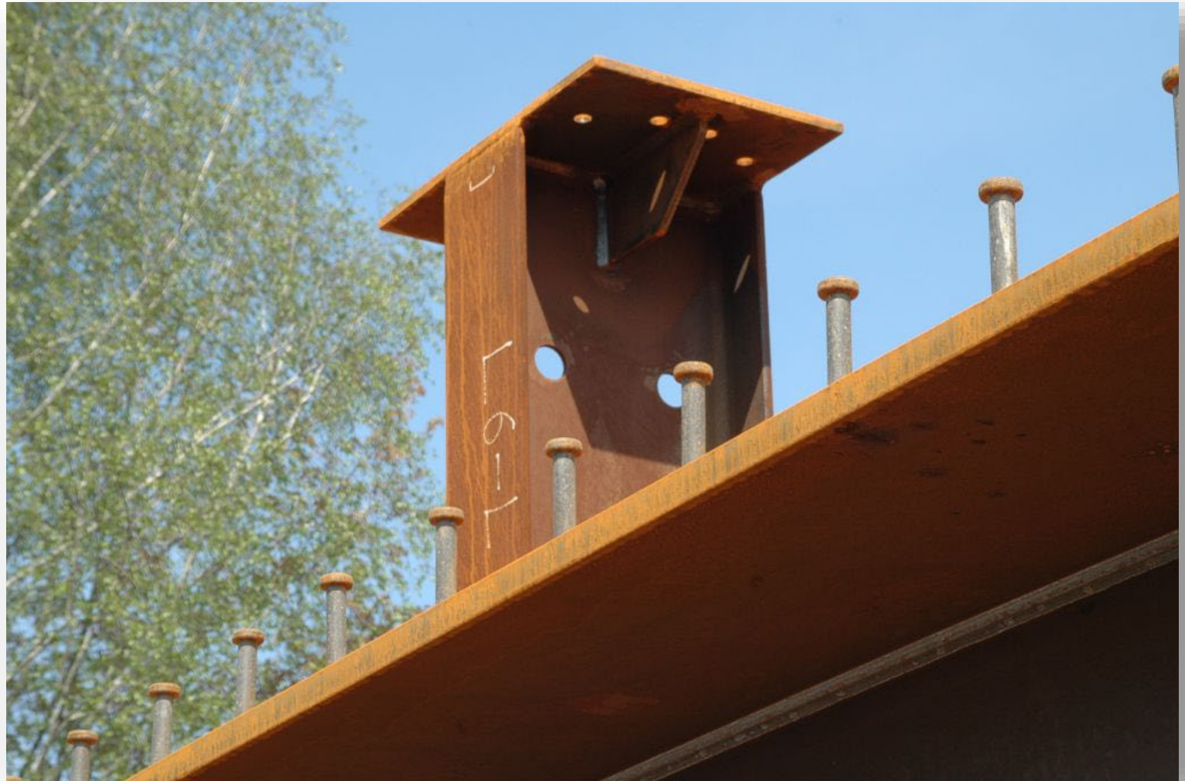
Detail spřahovacích trnů
