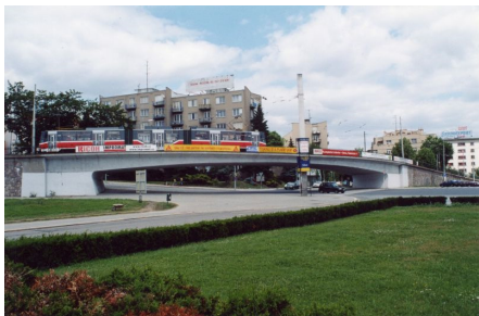
Železobetonový předpjatý tramvajový most, tzv. brněnský Karakas: • Specifický svým prostorovým zakřivením, stoupáním a nestejnou tloušťkou • Šířka 9 m
