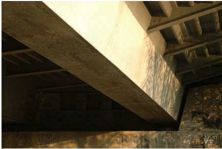
10/09/22 Příklady konstrukcí s prvky namáhanými kroucením 26
