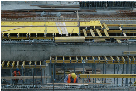
Stojkování betonového stropu
