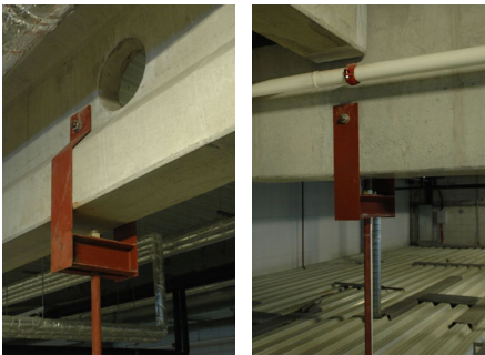
Zavěšení podhledů systémem táhel
