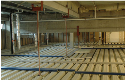
Zavěšení podhledů systémem táhel
