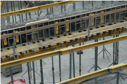
Stojkování betonového stropu
