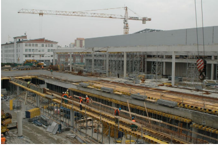
Stojkování betonového stropu
