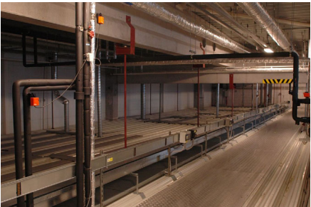
Zavěšení podhledů systémem táhel
