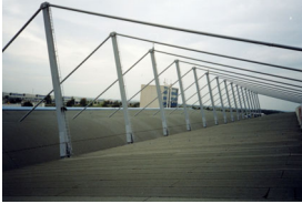
Hangár „F“ Ruzyně – první hala v ČR, která byla navržena podle metody mezních stavů (1966, M. Horák)
